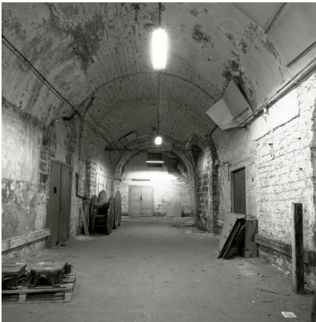
Le soubassement de la voie ferrée à l'est de la rue Delandine : vue d'une travée longitudinale des remises
