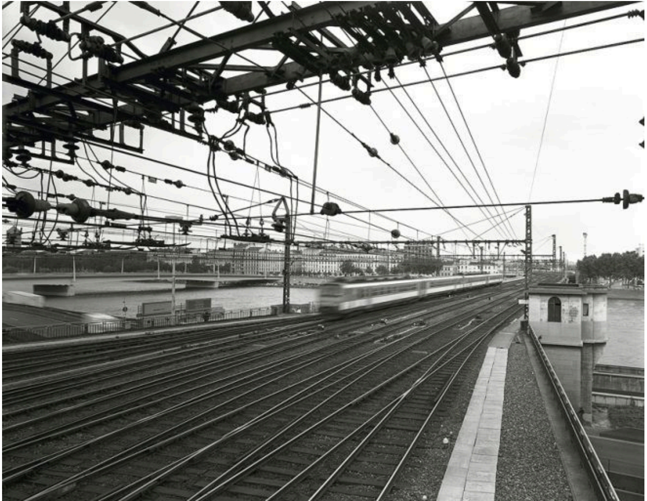
Vue d'ensemble du réseau ferré vers l'est
