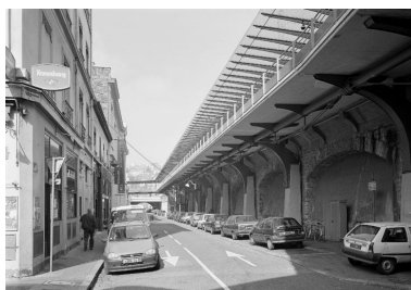
Mur de soutènement sur la partie ouest de la rue Dugas-Montbel, et passage vers les quais Saint-Etienne Phot. Jean-Marie Refflé IVR82_20026903564P
