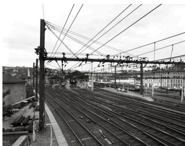
Vue d'ensemble de la gare depuis l'est Phot. Eric Dessert IVR82_20026903515V
