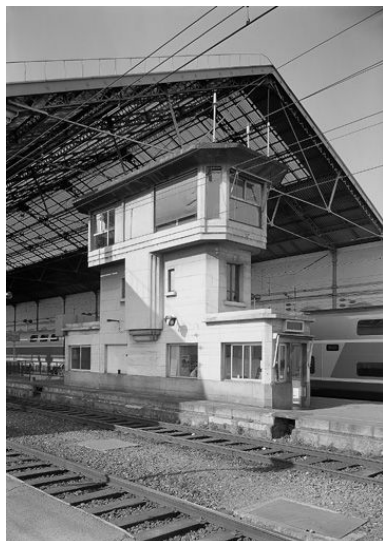
Vue du poste d'aiguillage C depuis le sud-est Phot. Jean-Marie Refflé IVR82_20026903715P
