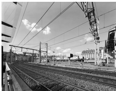
Les voies vers l'ouest depuis l'extrémité des quais de la gare de Perrache Phot. Eric Dessert IVR82_20016902745V
