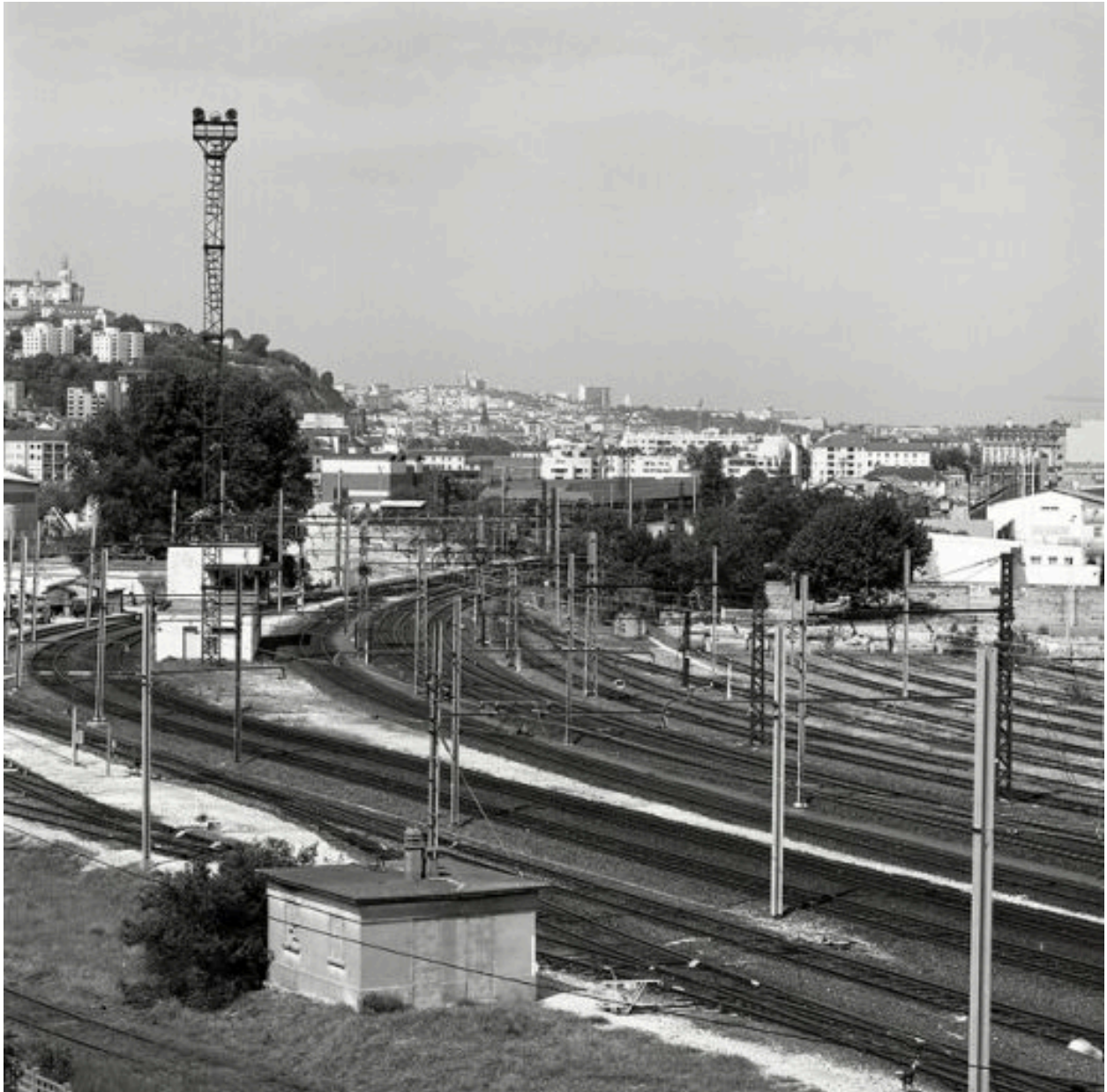
Vue du réseau ferré sud et de la tour d'aiguillage depuis le toit de l'entrepôt des sucres
