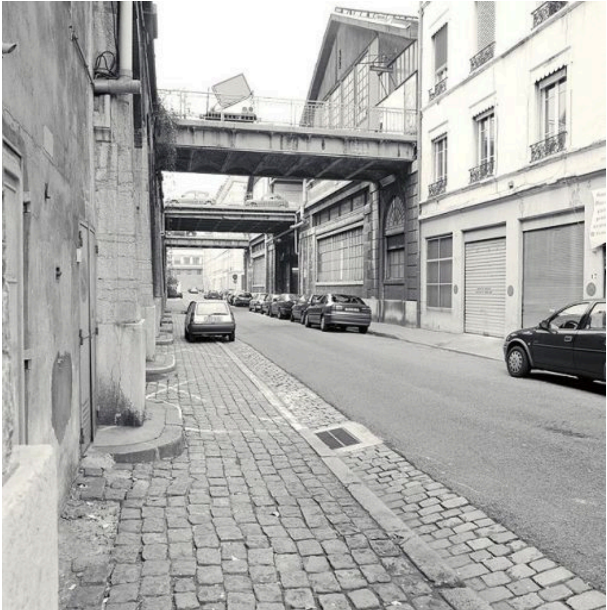
Vue des passerelles enjambant la rue du Bélier
