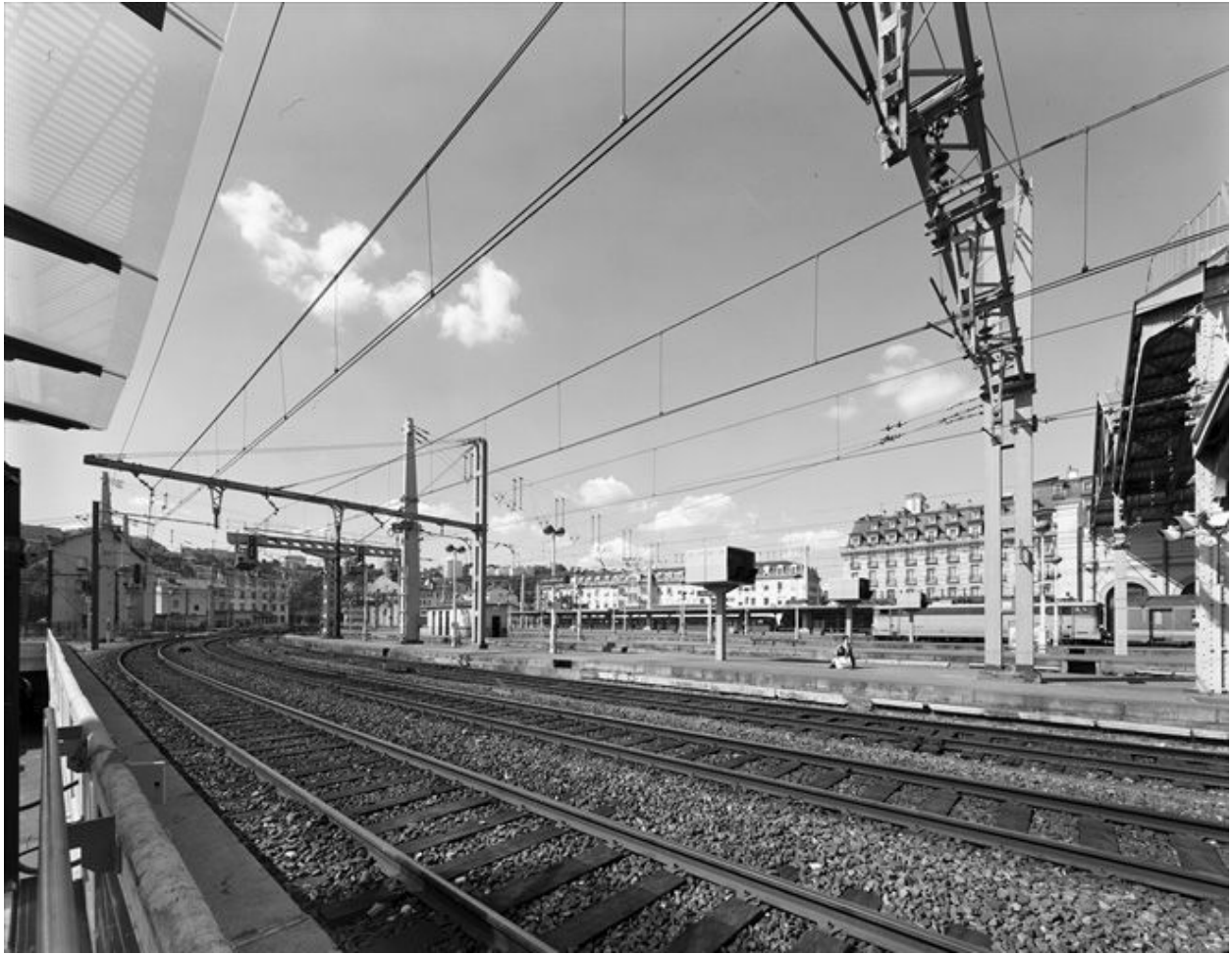
Les voies vers l'ouest depuis l'extrémité des quais de la gare de Perrache
