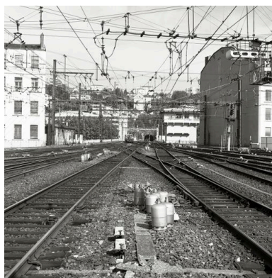
Vue d'ensemble des voies vers l'ouest et de l'entrée du tunnel Saint-Irénée Phot. Eric Dessert IVR82_20026903508X
