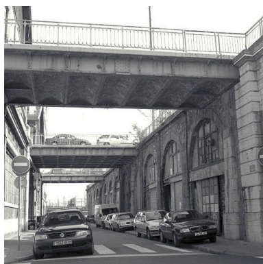
Les passerelles enjambant la rue du Béliet et les arcades des soutènements de la voie ferrée, depuis l'ouest Phot. Jean-Marie Refflé IVR82_20026903045X
