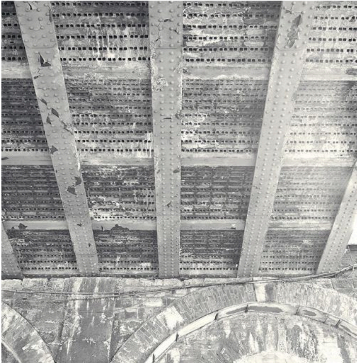
Détail des vouîtains des passerelles enjambant la rue du Bélier
