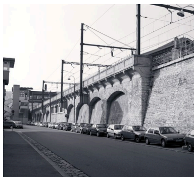
Le soutènement de la voie ferrée rue Dugas-Montbel, depuis l'est Phot. Jean-Marie Refflé IVR82_20026903049X
