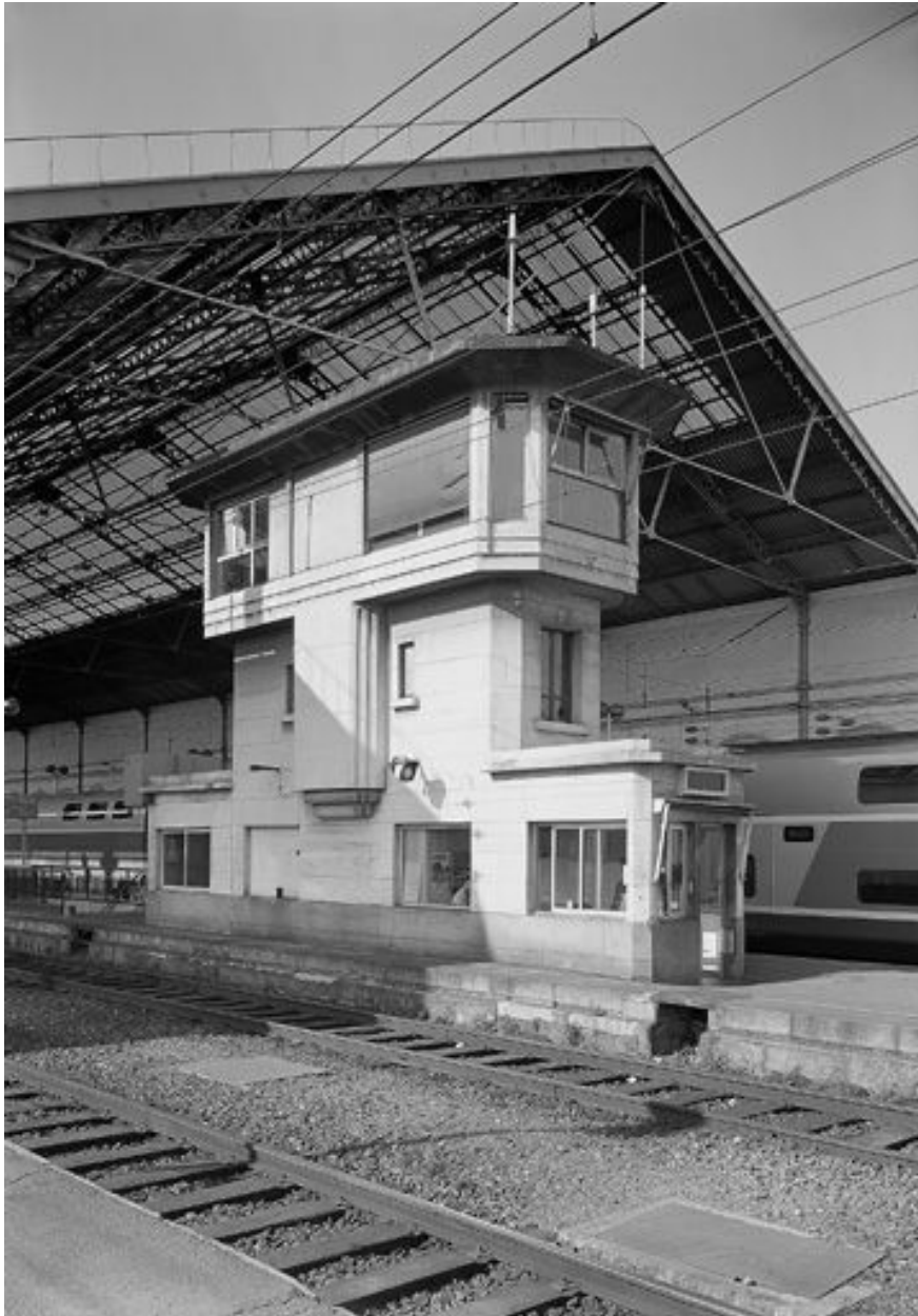
Vue du poste d'aiguillage C depuis le sud-est
