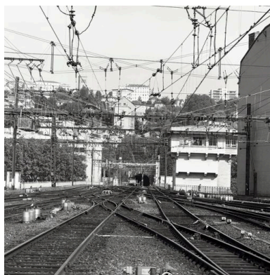
Les voies vers l'ouest et l'entrée du tunnel Saint-Irénée Phot. Eric Dessert IVR82_20026903509X
