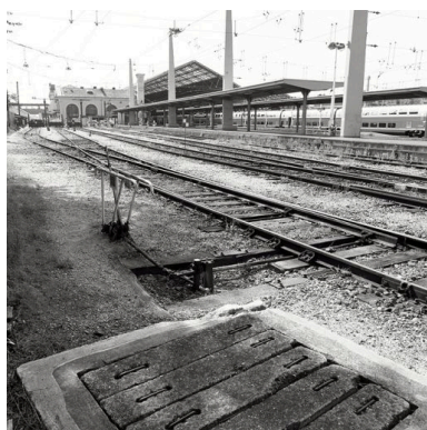
L'aiguille manuelle 103 et les quais sous abris parapluie vers Saint-Etienne Phot. Eric Dessert IVR82_20026903513X
