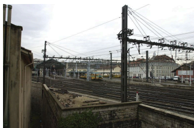
Vue générale depuis le sud-est Phot. Maryannick Chalabi IVR82_20016900024NUCA
