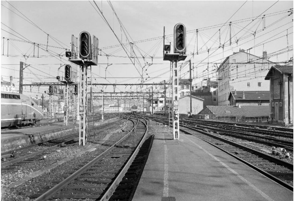
Départ des voies vers l'est depuis l'extrémité des quais
