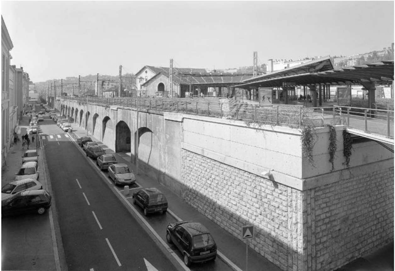
Le soutènement de la voie ferrée le long de la rue Gilibert, vers le sud, les quais saint-Etienne et la rotonde
