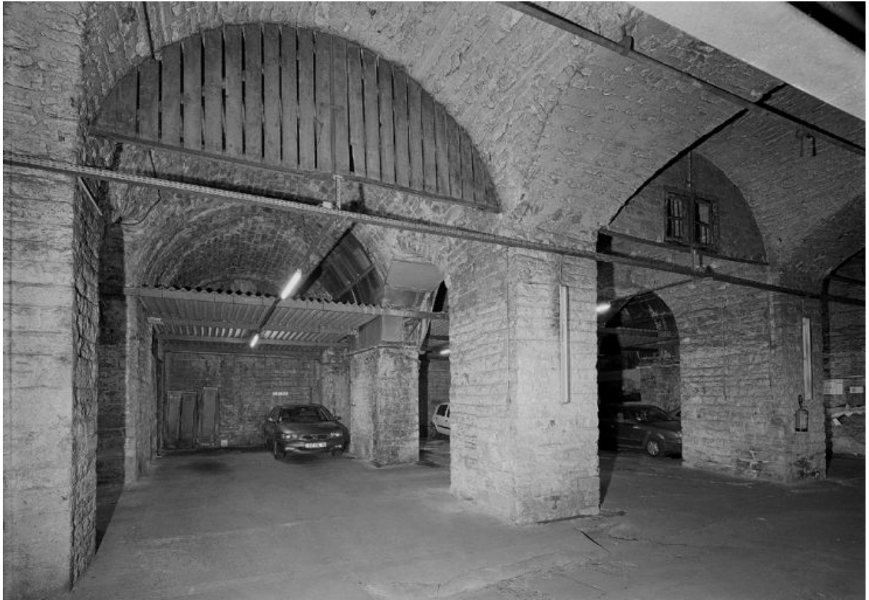
Le soubassement de la voie ferrée à l'est de la rue Delandine : vue d'ensemble des remises
