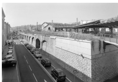
Le soutènement de la voie ferrée le long de la rue Gilibert, vers le sud, les quais saint-Etienne et la rotonde Phot. Jean-Marie Refflé IVR82_20026903053P
