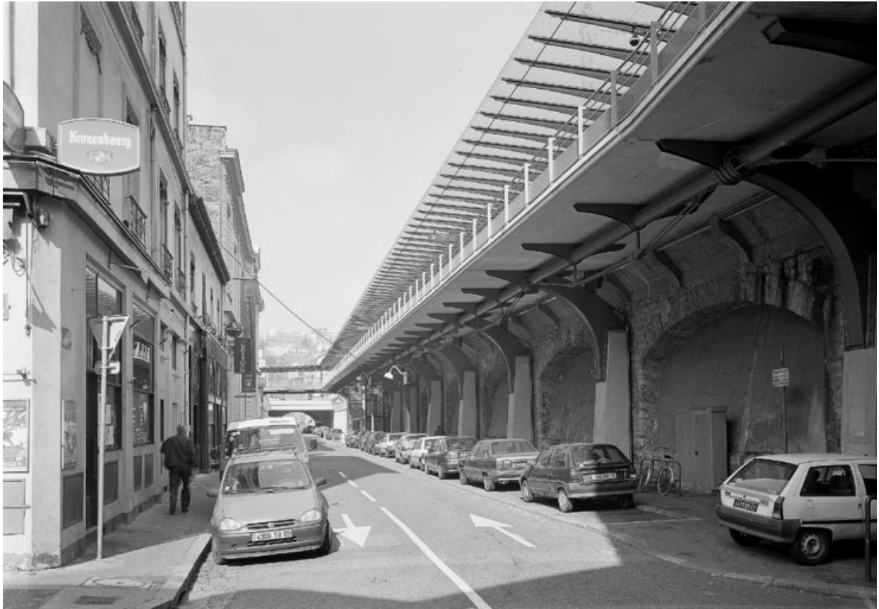
Mur de soutènement sur la partie ouest de la rue Dugas-Montbel, et passage vers les quais Saint-Etienne
