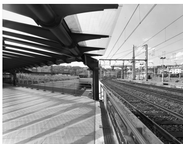
Les voies vers l'ouest depuis l'extrémité des quais Saint-Etienne Phot. Eric Dessert IVR82_20016902746V
