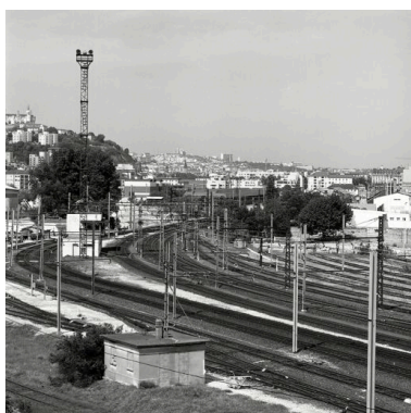
Vue du réseau ferré sud et de la tour d'aiguillage depuis le toit de l'entrepôt des sucres Phot. Eric Dessert IVR82_20026903520X
