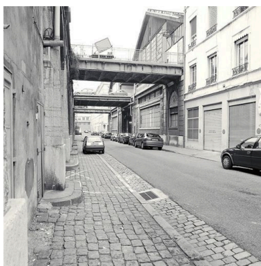
Vue des passerelles enjambant la rue du Béliet Phot. Eric Dessert IVR82_20016902493X
