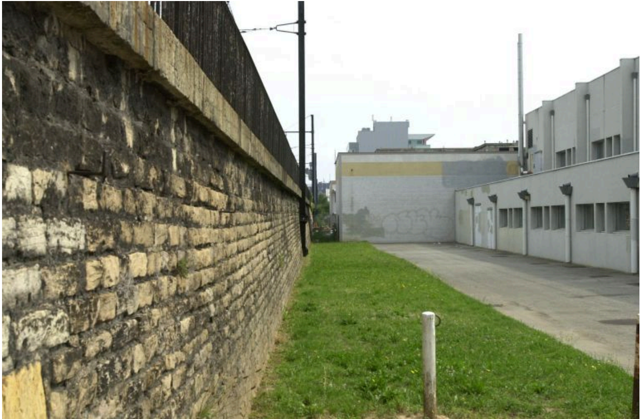
Vue du passage à l'est de la voie ferrée depuis la rue Casimir-Perier vers le nord
