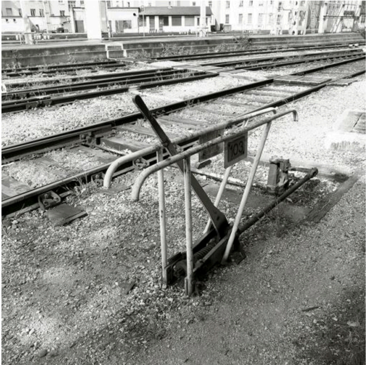
L'aiguille manuelle 103 actionnant les voies de service des porte-voitures
