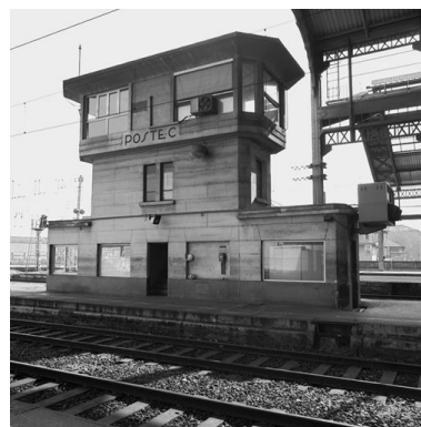
Le poste d'aiguillage C sous la grande halle Phot. Jean-Marie Refflé IVR82_20026903714X
