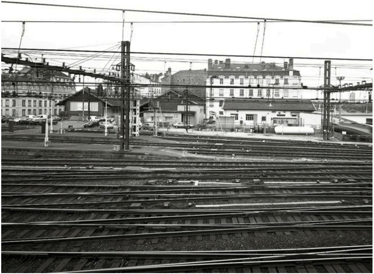
Les voies ferrées depuis le sud et les bâtiments de la Compagnie des wagons-lits
