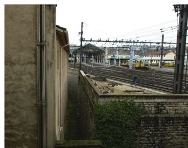
Vue de la ruelle longeant la gare au sud, depuis l'est Phot. Maryannick Chalabi IVR82_20016900023NUCA
