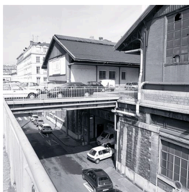
Vue d'ensemble des bâtiments de la compagnie des wagons-lits depuis le sud-ouest Phot. Jean-Marie Refflé IVR82_20026903047X
