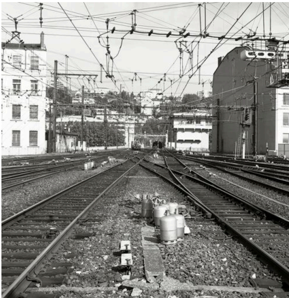
Vue d'ensemble des voies vers l'ouest et de l'entrée du tunnel Saint-Irénée
