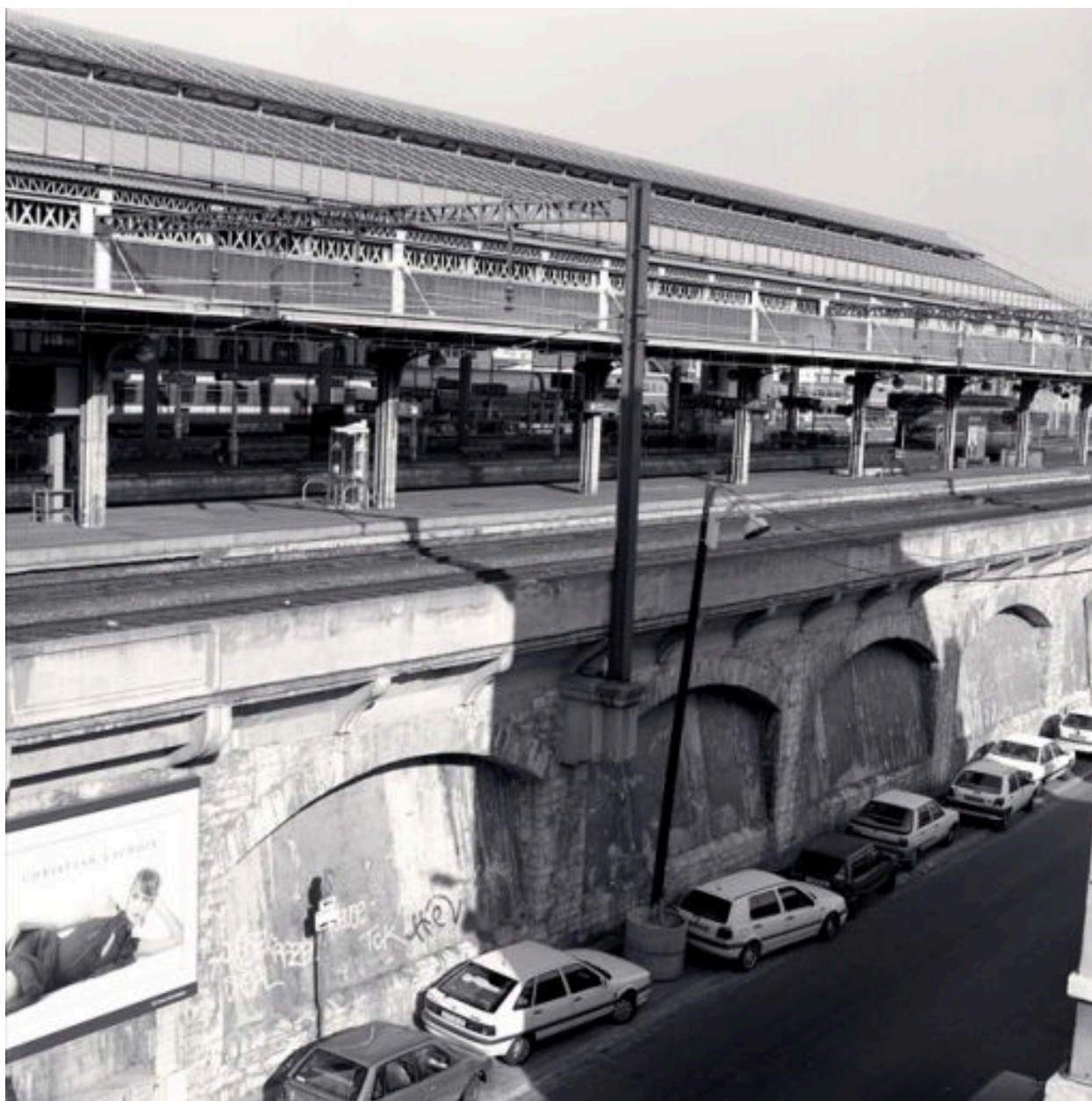
Vue d'ensemble des quais, au-dessus du soutènement de la voie ferrée rue Dugas-Montbel, côté Rhône
