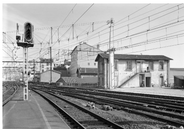
Les bâtiments d'exploitation au sud-est de la gare Phot. Jean-Marie Refflé IVR82_20026903558P
