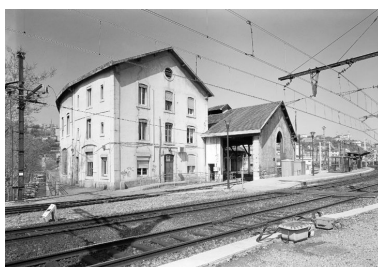
Le bâtiment du comité d'entreprise, cours Suchet, et la rotonde, depuis l'est Phot. Jean-Marie Refflé IVR82_20026903565P
