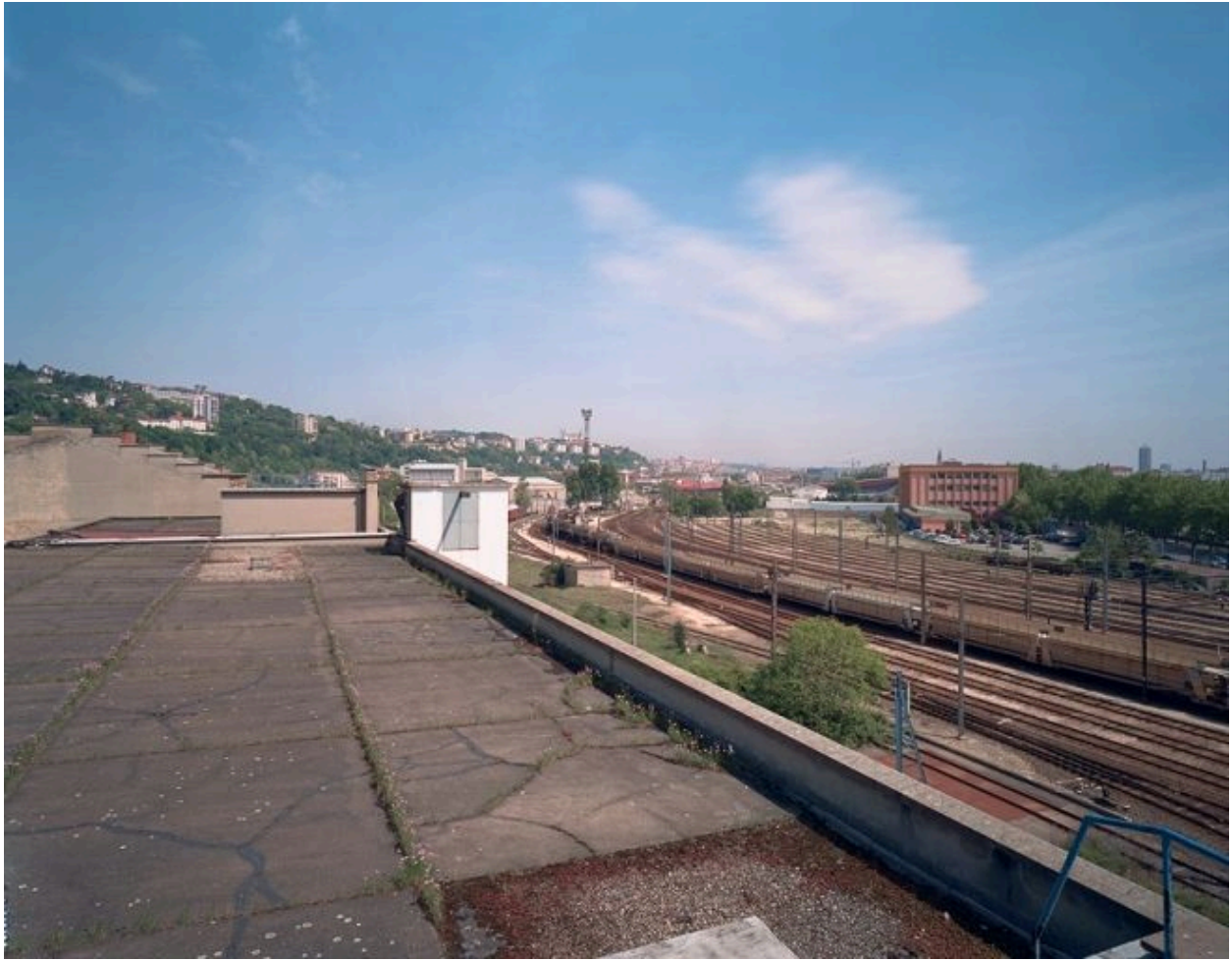
Vue d'ensemble des voies vers le nord, depuis le toit de l'entrepôt des sucres
