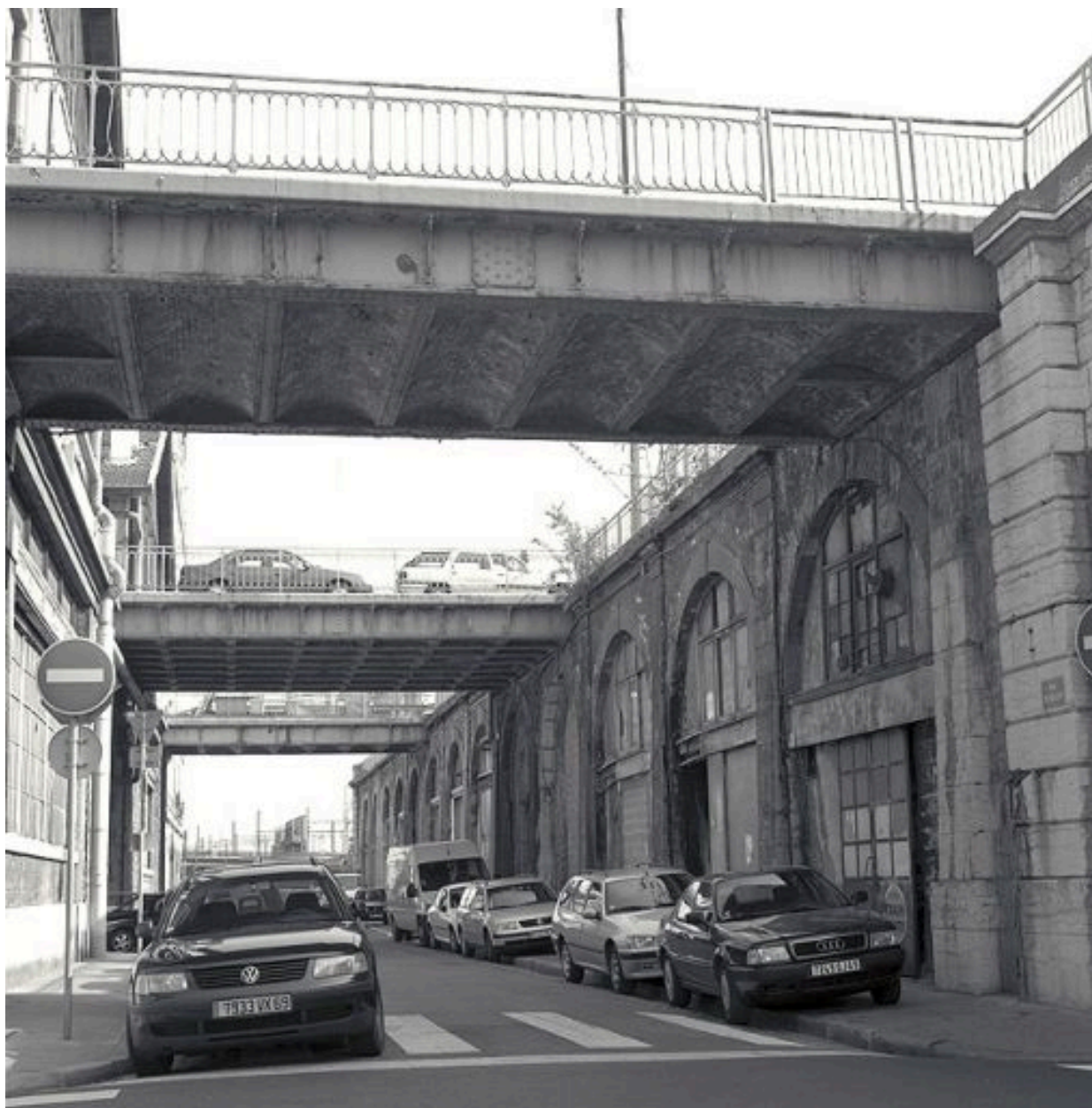
Les passerelles enjambant la rue du Bélier et les arcades des soutènements de la voie ferrée, depuis l'ouest
