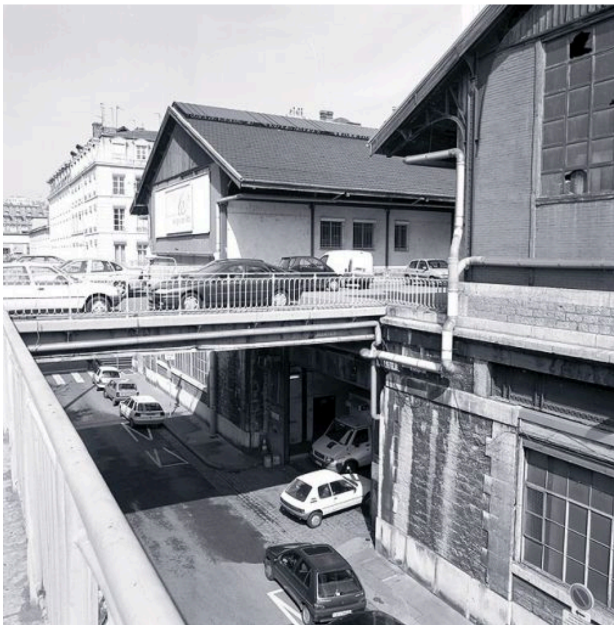
Vue d'ensemble des bâtiments de la compagnie des wagons-lits depuis le sud-ouest
