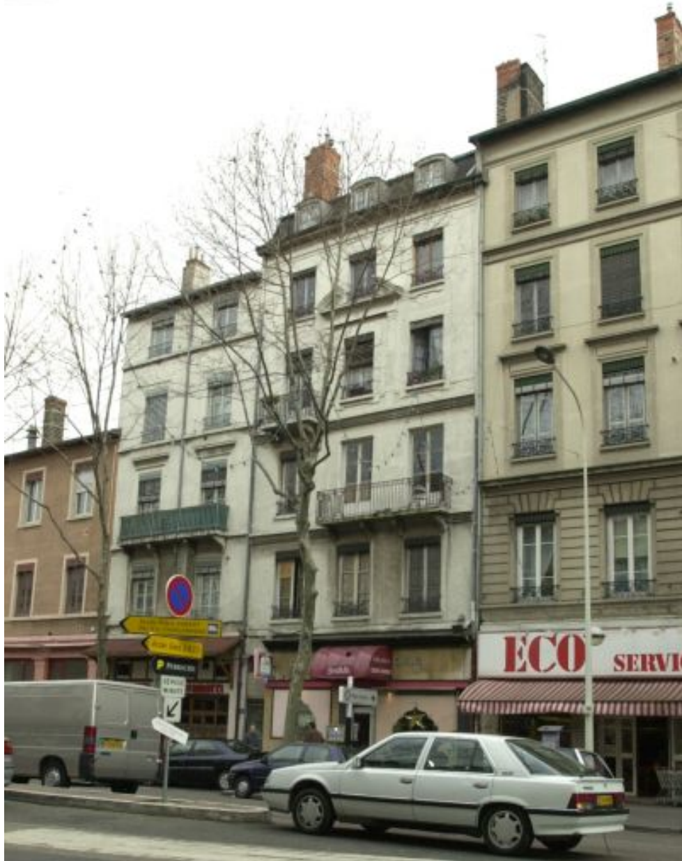
Vue générale depuis le sud
