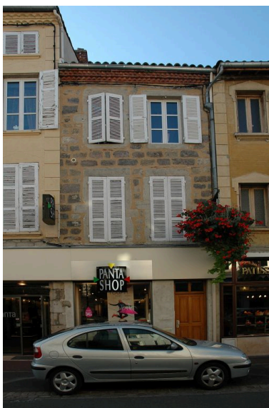
Vue générale sur la rue Tupinerie. Phot. Simone Hartmann-Nussbaum IVR82_20134200523NUCA
