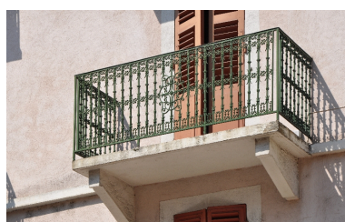
Détail d'un balcon Phot. François Fouger IVR82_20117300632NUCA
