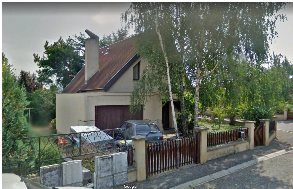
Le Cendre, la maison B.* vue du nord-ouest (Google street).
