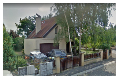
Le Cendre, la maison B.* vue du nord-ouest (Google street).
