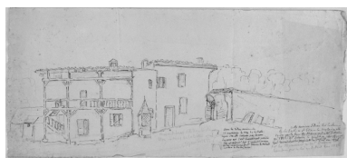
Maison Delmas, dite dans les vieux titres le Mas de la Bastie, 12 janvier 1839. (...) Repro. Eric Dessert IVR82_20024201601XB
