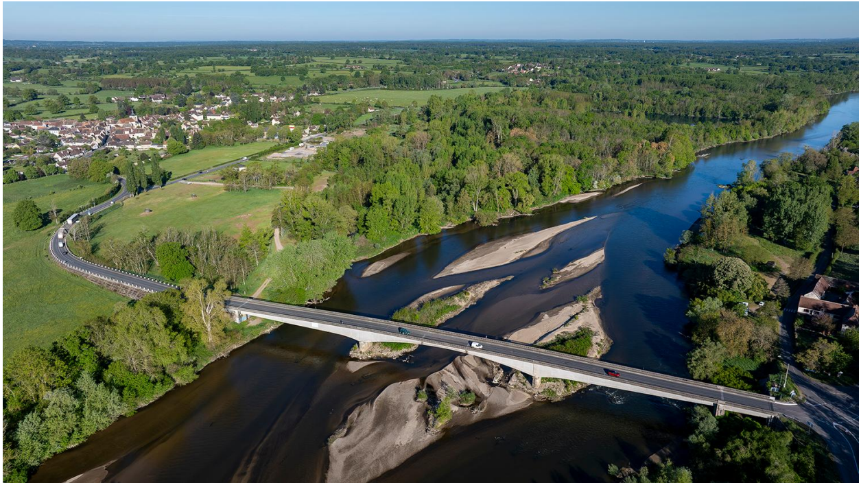
Prise de vue par drone du 3e pont sur l'Allier avec l'est bourg du Veudre à l'arrière plan, en 2026.
