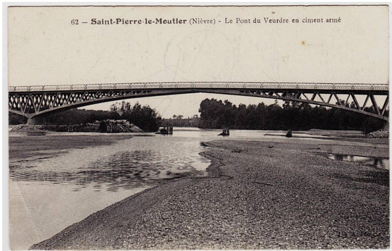
Vue du second pont nouvellement construit après 1910-1911, carte postale ancienne.
