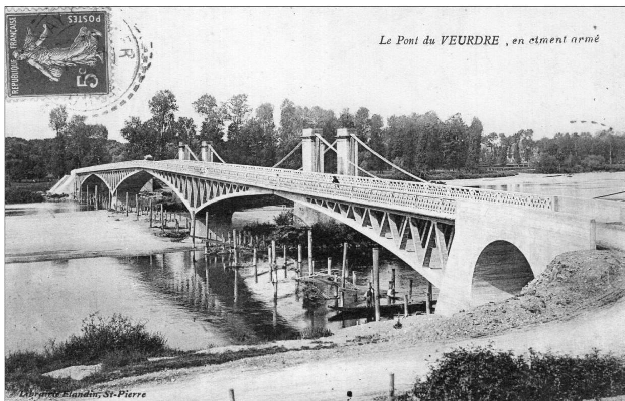
Le nouveau pont du Veurdre (n°2) en béton armé et l'ancien pont à l'arrière plan. Vers 1910-1911.
