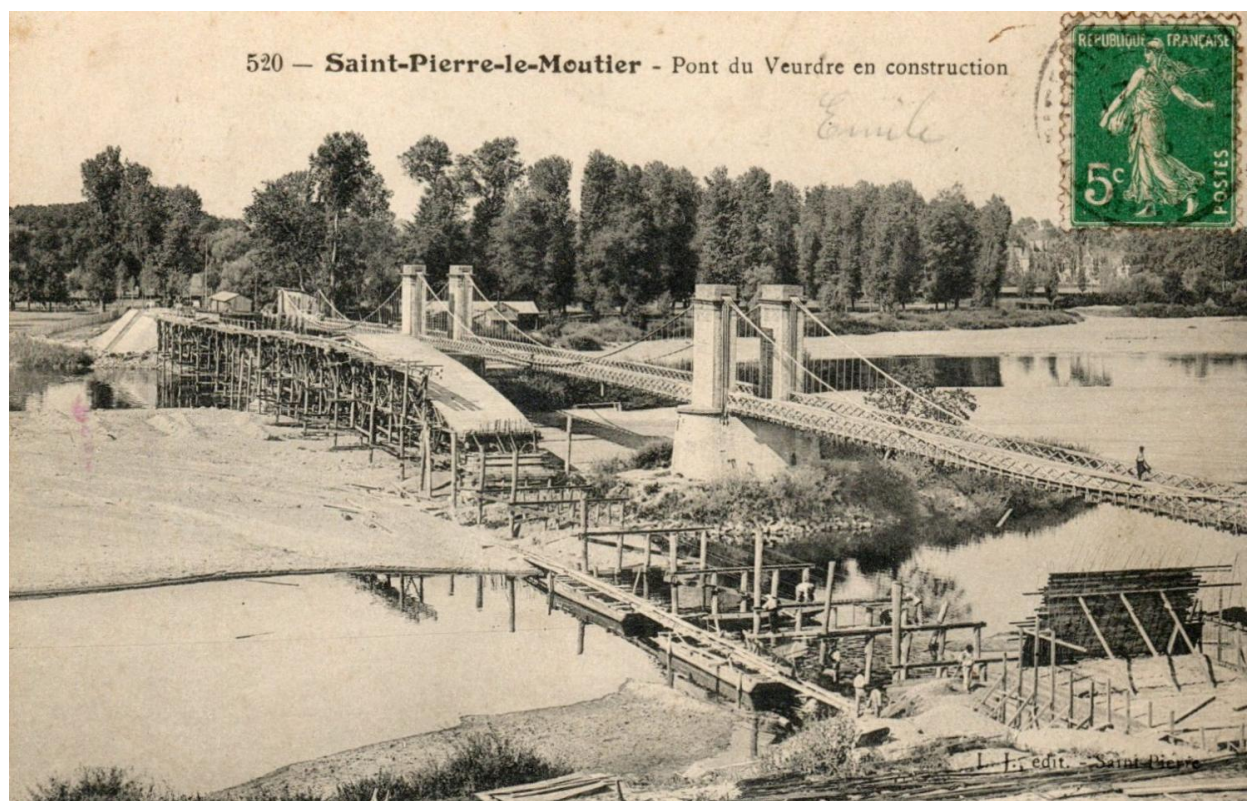
Le nouveau pont du Veudre (n°2) en béton armé en cours de construction et l'ancien pont à l'arrière plan. Vers 1910-1911.
