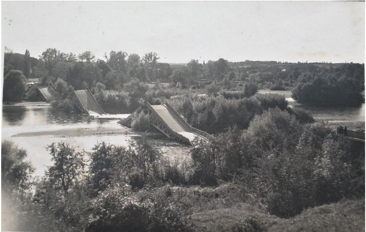
Le 2e pont dynamité le 7 septembre 1944 pour retarder le retour des colonnes allemandes.
