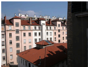
Vue générale depuis un immeuble de l'avenue Jean-Jaurès au sud-est Phot. N. Giroud IVR82_20046904170NUCA
