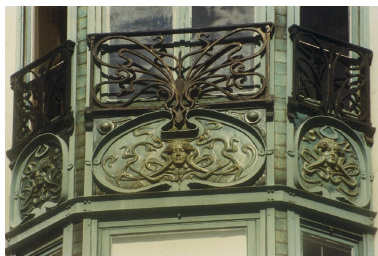
Détail du balcon Phot. Cendrine Sanquer IVR82_20084200555NUCA
