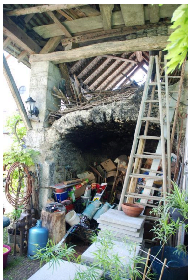
Vue d'ensemble intérieure du four à pain. Phot. Thierry Monnet IVR82_20157302716NUCA
