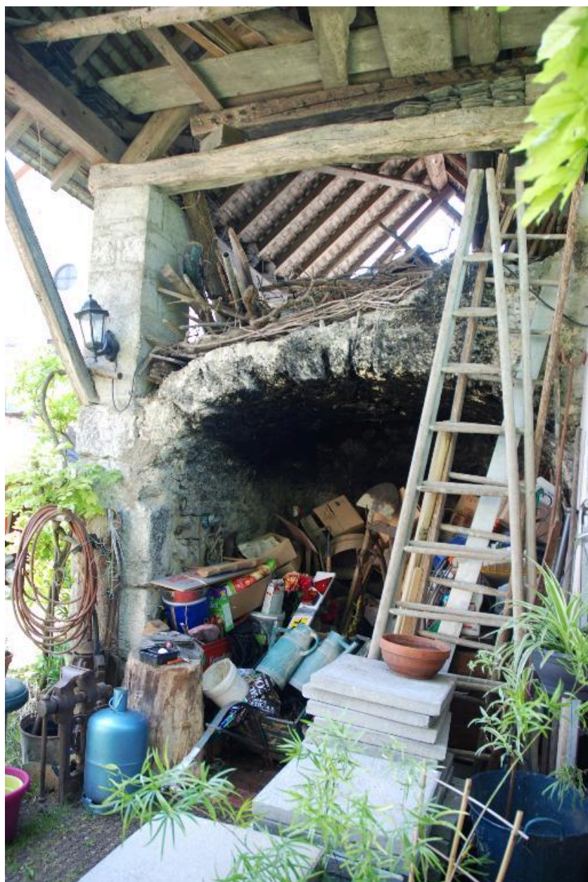
Vue d'ensemble intérieure du four à pain.
