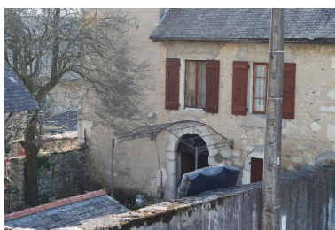
Détail de la façade est Phot. Thierry Monnet IVR82_20157302718NUCA
