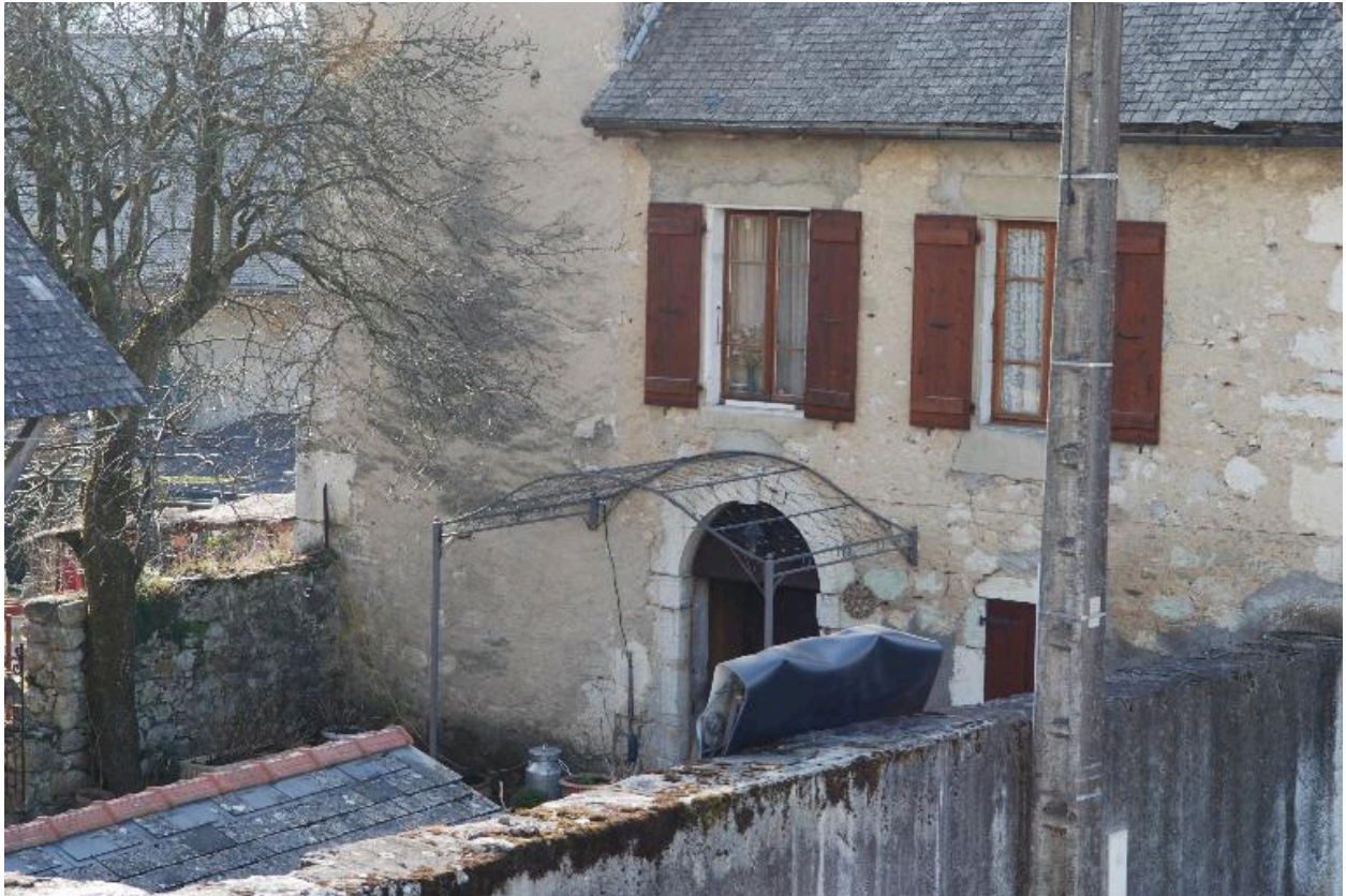
Détail de la façade est
