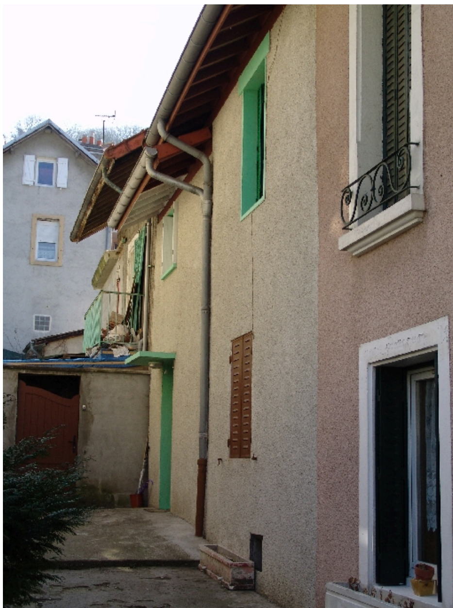
Détail de l'élévation nord
