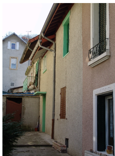
Détail de l'élévation nord Phot. François Fouger IVR82_20097300548NUCA
