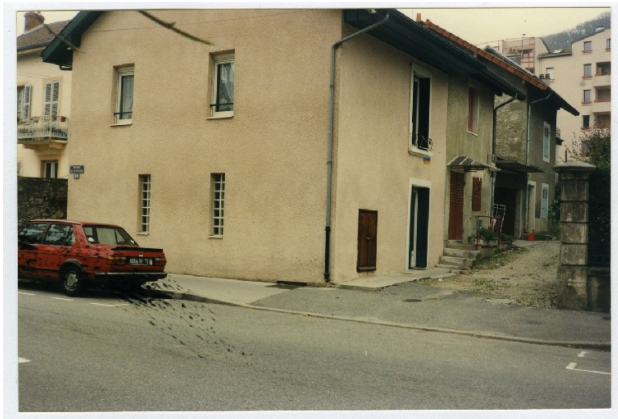
Façade sud avant transformation
