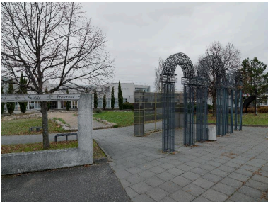
Vue d'ensemble, depuis l'entrée Phot. Eric Dessert IVR82_20154200712NUCA
