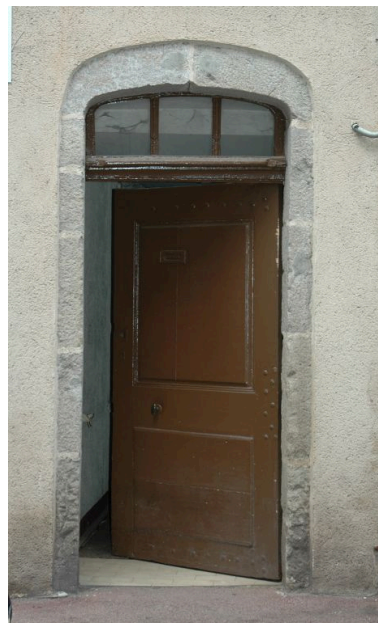
Porte piétonne avec arc en anse de panier. Phot. Simone Hartmann-Nussbaum IVR82_20134200566NUCA
