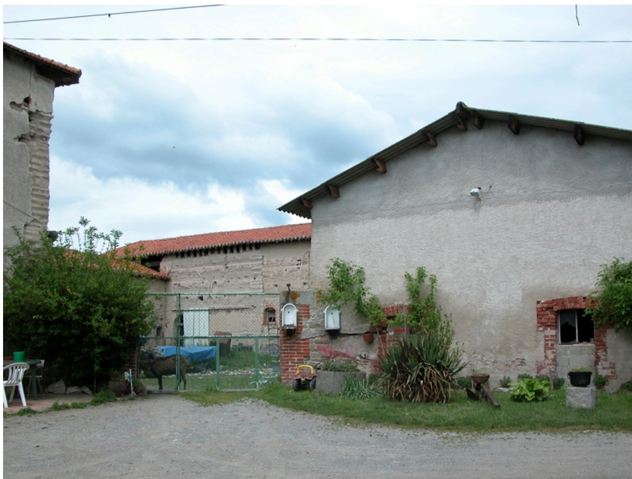
Vue de l'entrée de la cour (à droite, grange-remise et petite étable).
