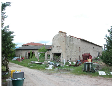
Vue depuis le sud-est (vue arrière de la grange-remise et petite étable, et de la sonde grange-étable). Phot. Thierry Monnet IVR82_20134201778NUCA
