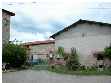
Vue de l'entrée de la cour (à droite, grange-remise et petite étable). Phot. Thierry Monnet IVR82_20134201775NUCA
