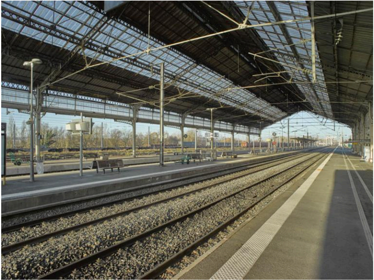
Détail de la grande halle à structure métallique et verrières au-dessus des quais de la gare de Saint-Germain-des-Fossés.
