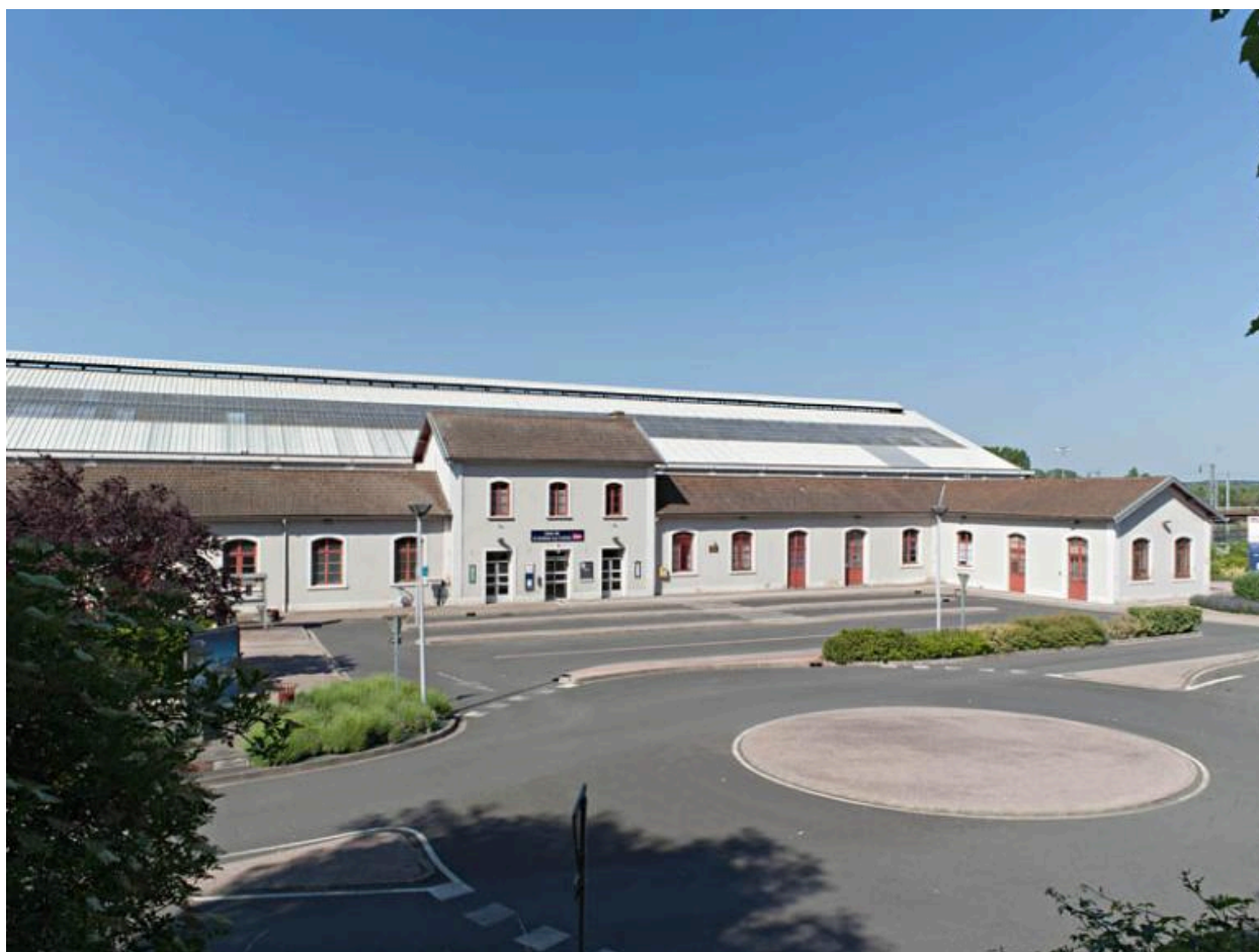
Vue générale de la gare de Saint-Germain-des-Fossés, côté parvis.
