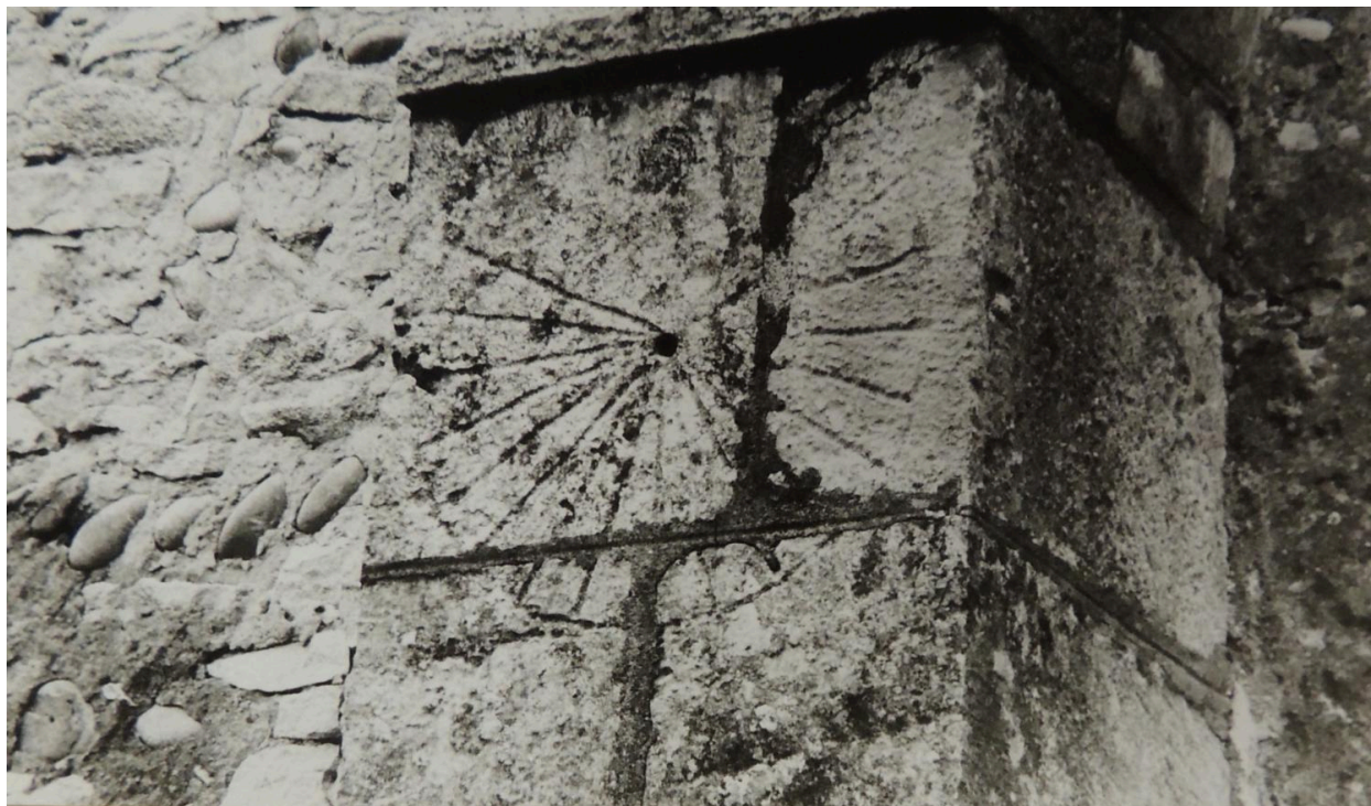
Vestige de cadran solaire, contrefort sud (Paul Cattin. AD de l'Ain. 6 Fi 1921).
