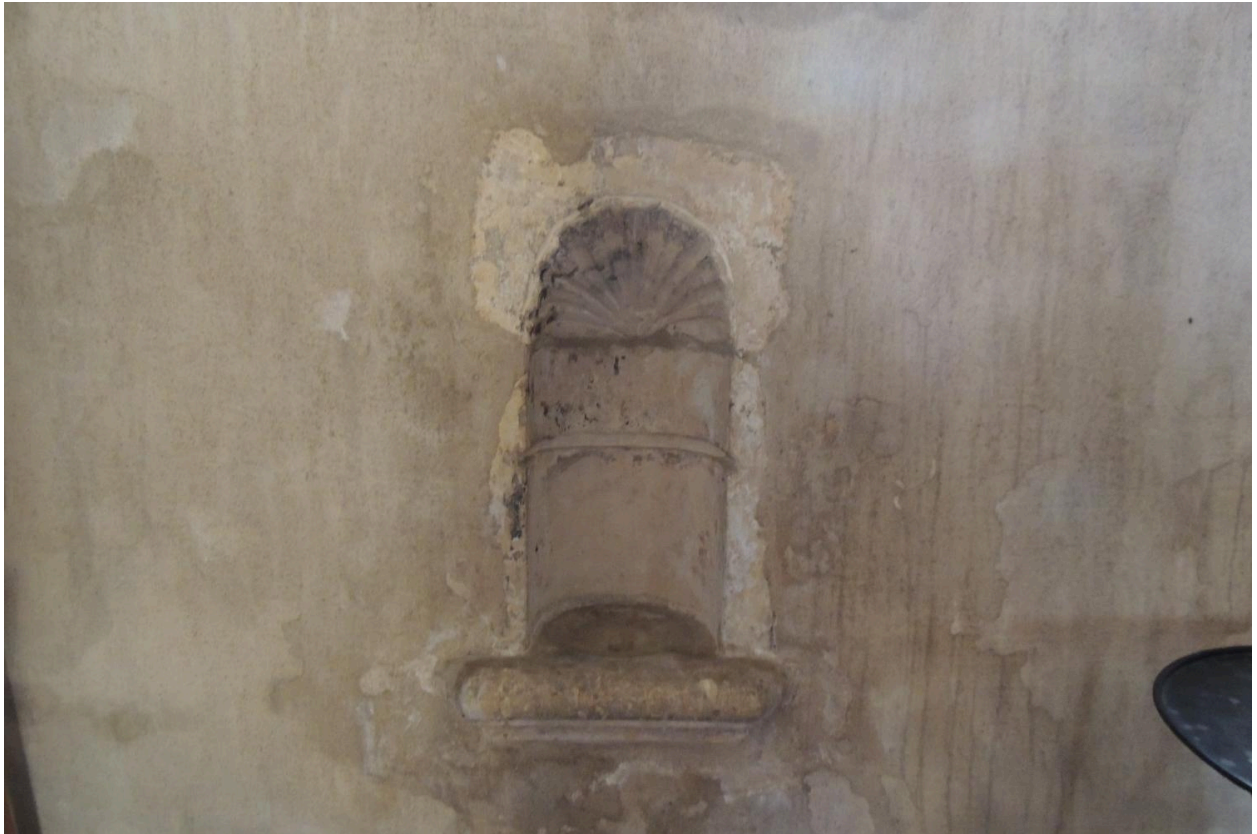
Niche dans la chapelle sud n° 3.
