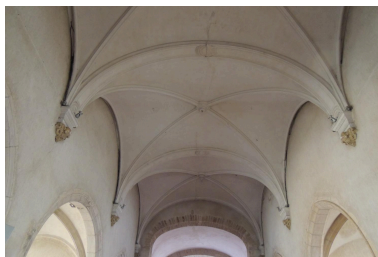
Fausse voûte en briques enduites de la nef. Phot. Elisabeth Dandel IVR84_20200100415NUCA
