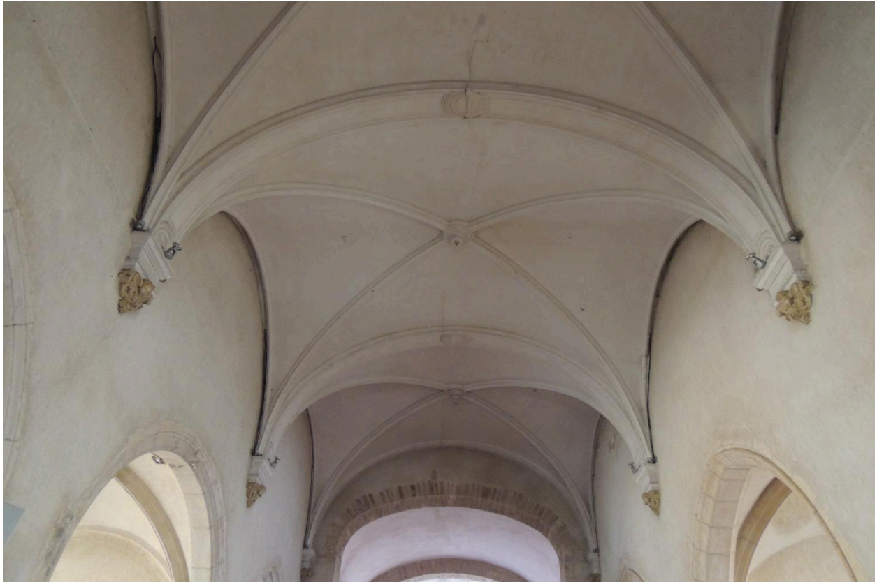
Fausse voûte en briques enduites de la nef.
