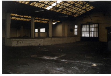
Ancienne maison- atelier : intérieur du hangar Phot. St. Autran IVR84_20166901655NUCA
