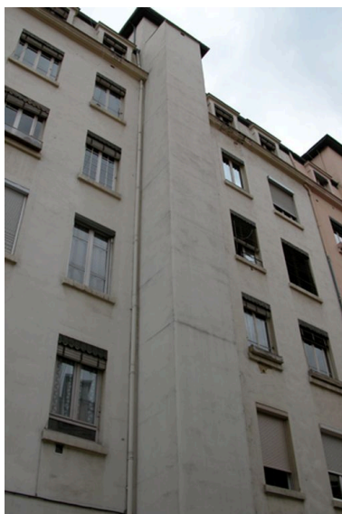
Colonne d'ascenseur rajouté sur l'élévation sur cour Phot. N. Giroud IVR82_20046904173NUCA
