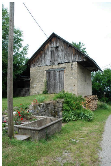
Vue de l'annexe (cellier, remise) et du bassin. Phot. Caroline Guibaud IVR84_20167304601NUCA
