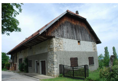
Vue d'ensemble depuis l'est. Phot. Caroline Guibaud IVR84_20167304600NUCA
