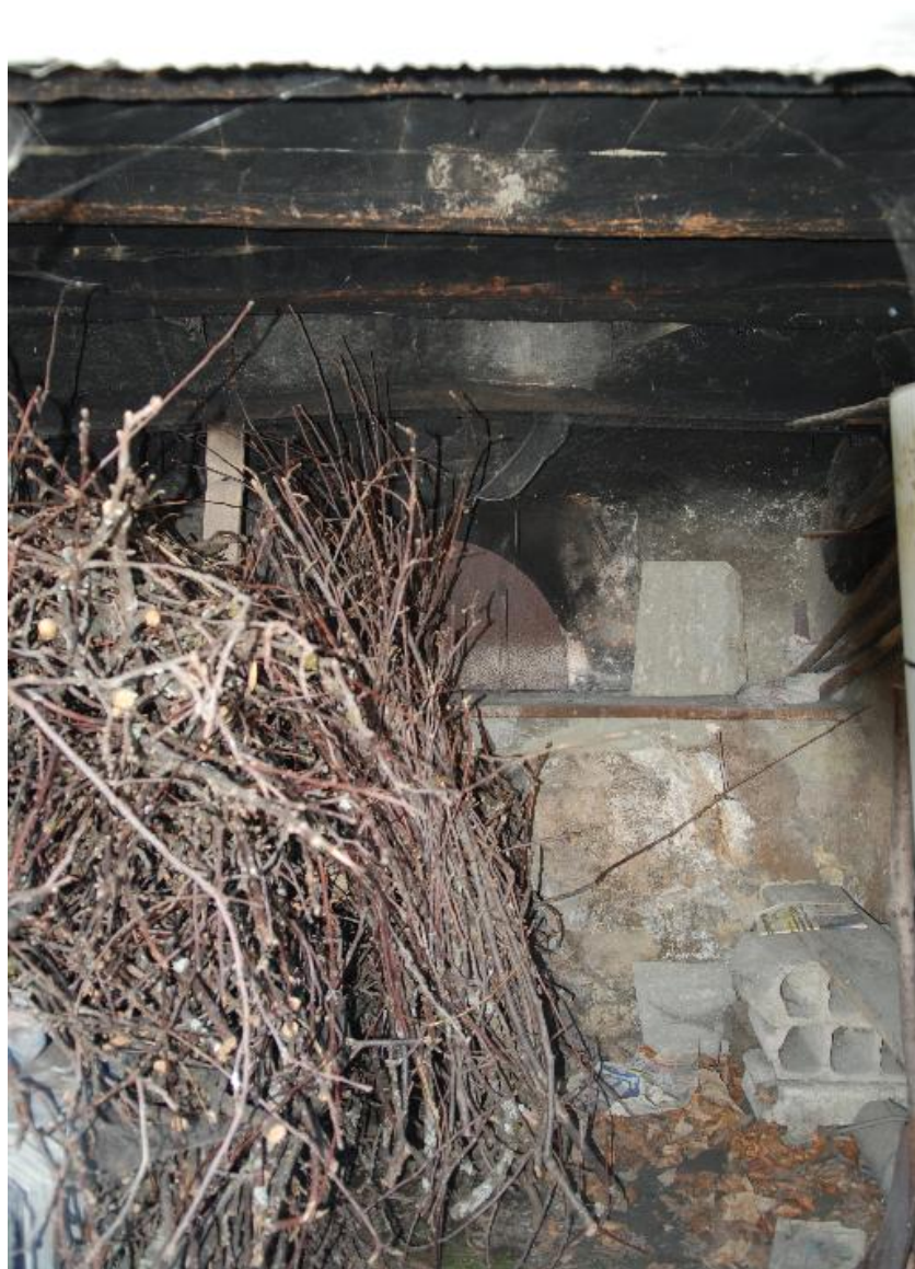
Vue intérieure du four à pain.
