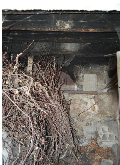
Vue intérieure du four à pain. Phot. Thierry Monnet IVR84_20177301899NUCA
