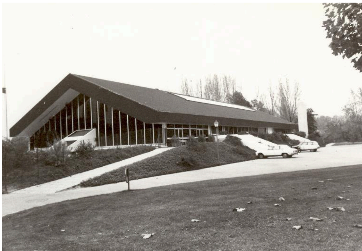
Le bâtiment avant travaux
