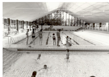
Bassins intérieurs avant travaux Repro. Denys Harreau IVR82_20157301097NUCB
