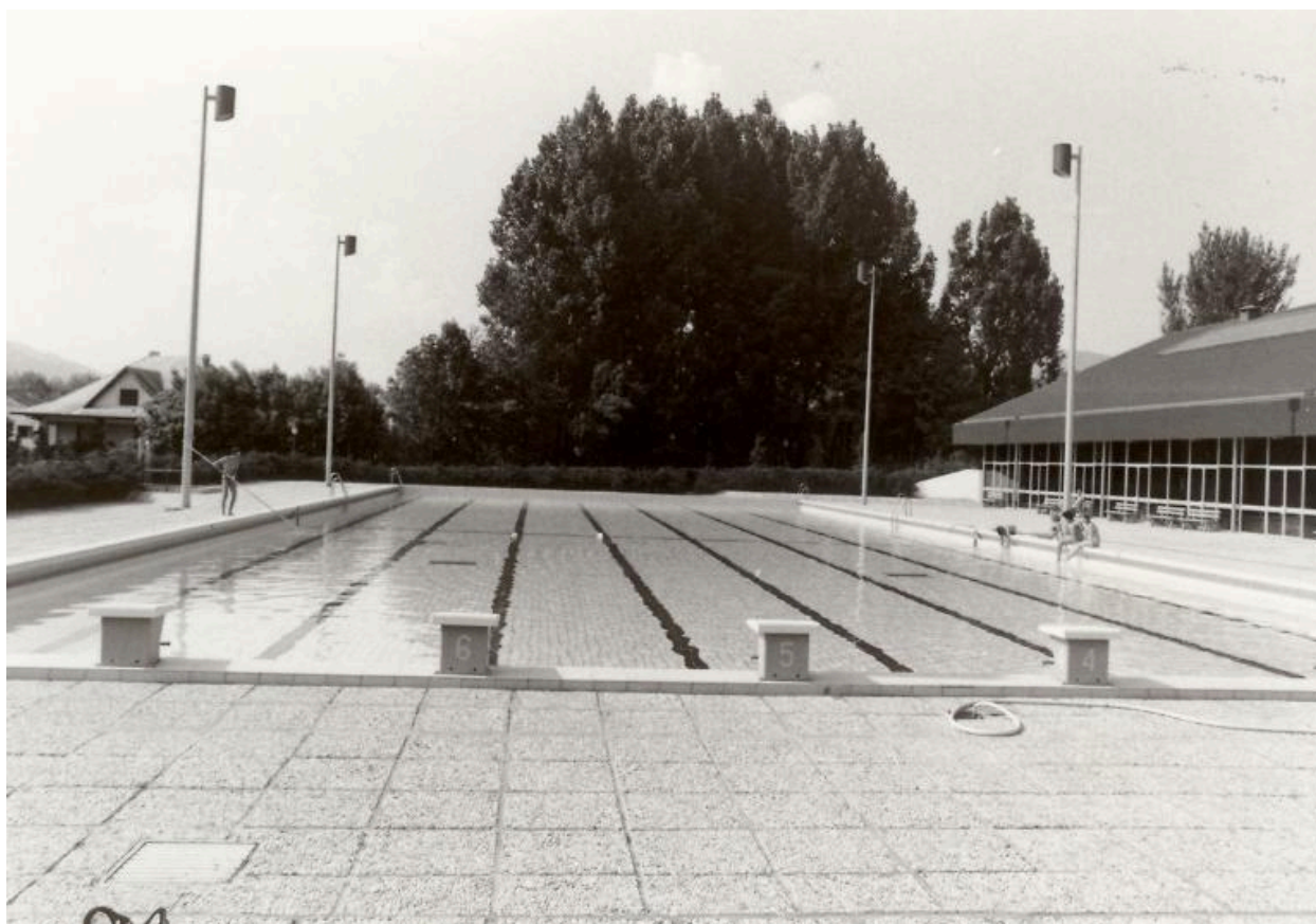
Bassin olympique extérieur avant travaux
