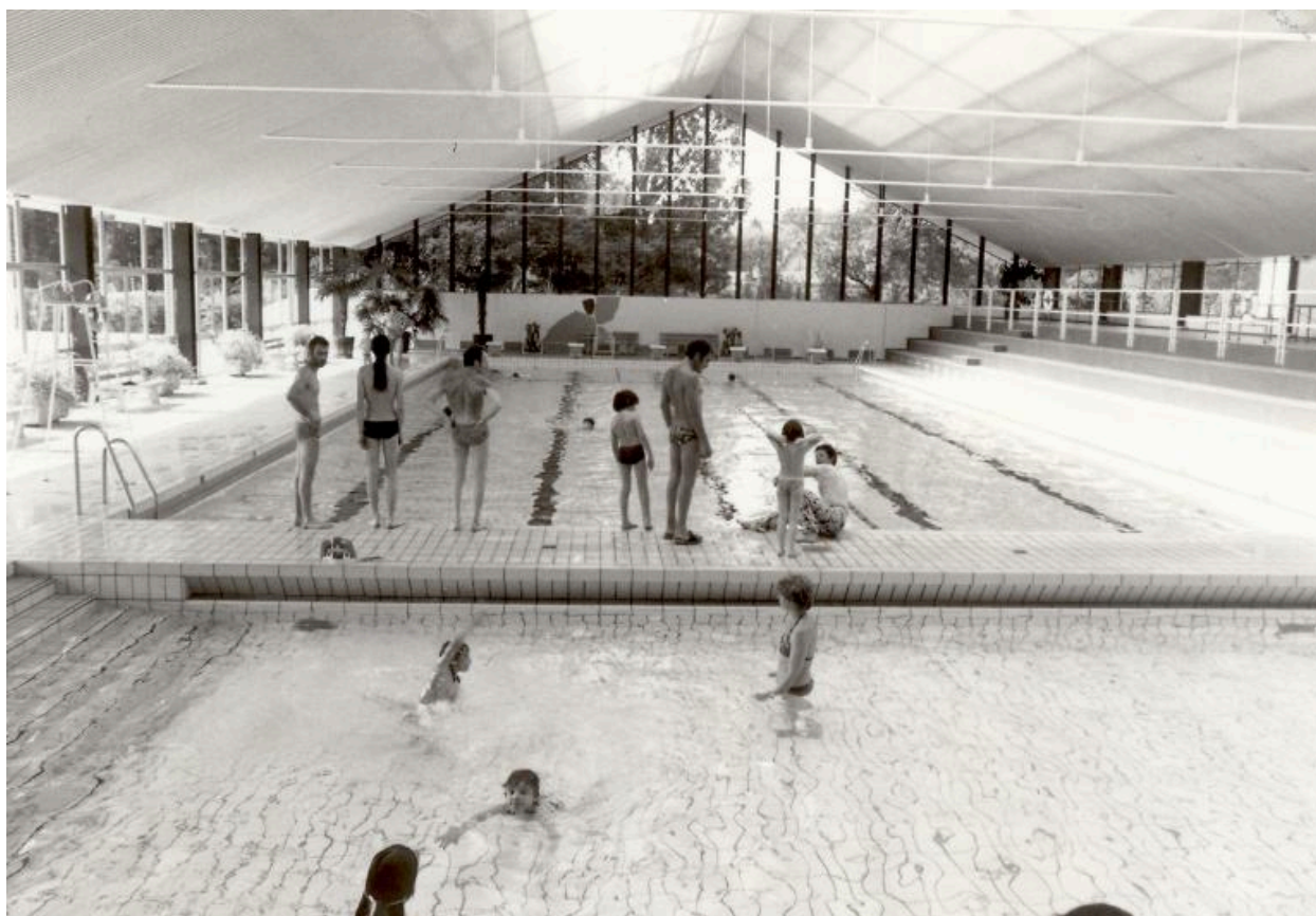
Bassins intérieurs avant travaux
