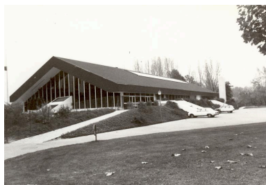
Le bâtiment avant travaux Repro. Denys Harreau IVR82_20157301094NUCB
