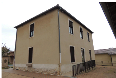
Vue de trois quarts. Phot. Elisabeth Dandel IVR84_20210100076NUCA
