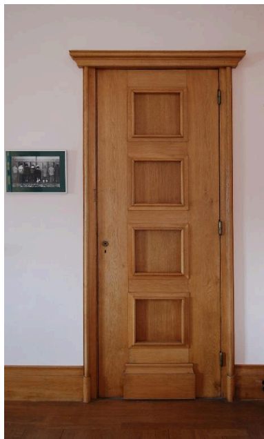
Appartement du proviseur : détail d'une porte (salon) Phot. Catherine Guégan IVR82_20150100074NUCA
