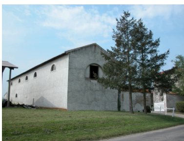
Vue du bâtiment est depuis le chemin. Phot. Thierry Monnet IVR82_20134204311NUCA
