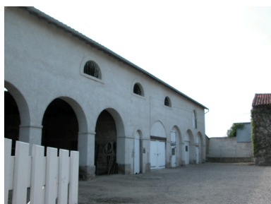
Vue du bâtiment est depuis l'entrée de la cour. Phot. Caroline Guibaud IVR82_20134204307NUCA
