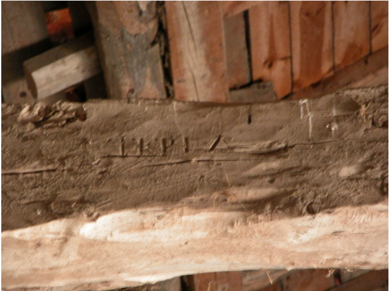
Détail de la charpente de la grange-étable, partie ouest.
