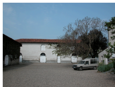
Vue du bâtiment ouest depuis la cour. Phot. Caroline Guibaud IVR82_20134204304NUCA
