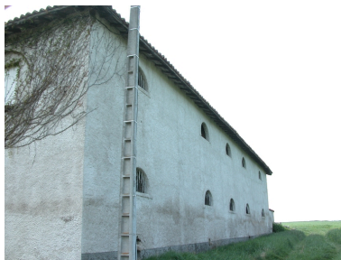
Vue de l'élévation postérieure du bâtiment ouest. Phot. Caroline Guibaud IVR82_20134204308NUCA
