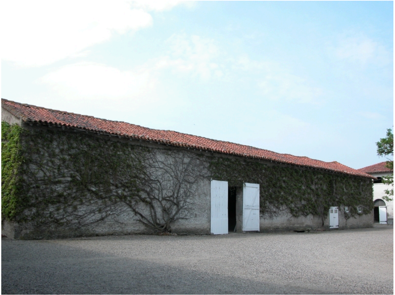
Vue de la grange-étable depuis la cour.
