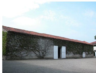
Vue de la grange- étable depuis la cour. Phot. Caroline Guibaud IVR82_20134204303NUCA
