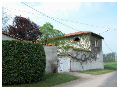
Vue du bâtiment ouest depuis le chemin. Phot. Caroline Guibaud IVR82_20134204309NUCA
