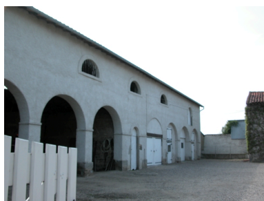
Vue du bâtiment est depuis l'entrée de la cour. Phot. Caroline Guibaud IVR82_20134204307NUCA
