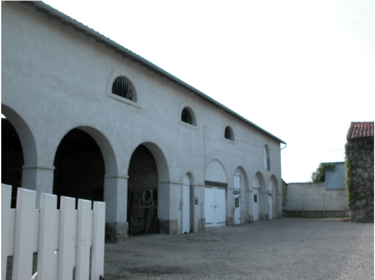
Vue du bâtiment est depuis l'entrée de la cour.
