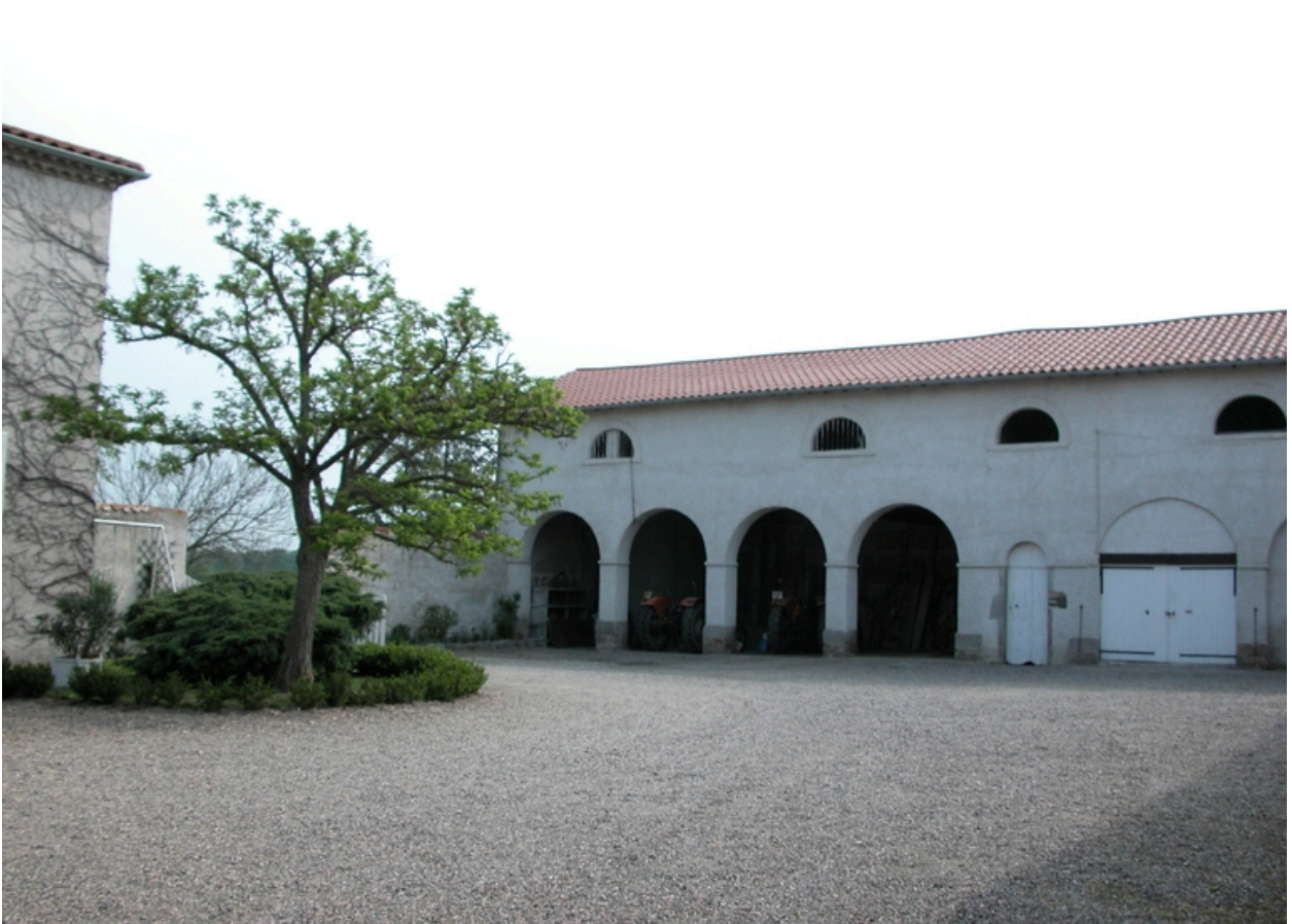
Vue du bâtiment est, depuis la cour.
