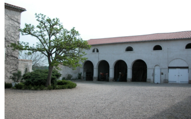
Vue du bâtiment est, depuis la cour. Phot. Caroline Guibaud IVR82_20134204305NUCA
