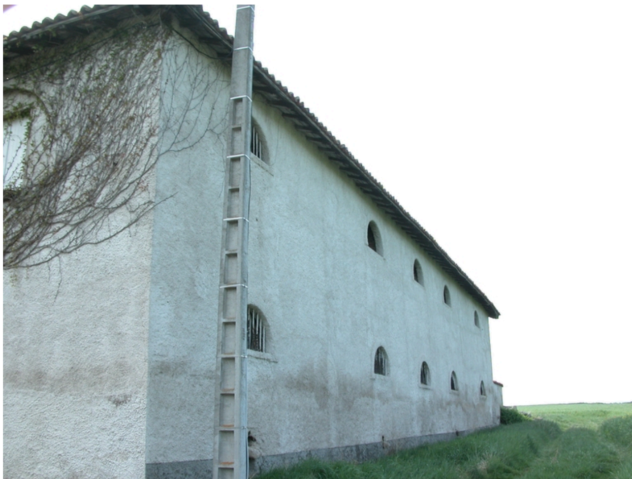
Vue de l'élévation postérieure du bâtiment ouest.
