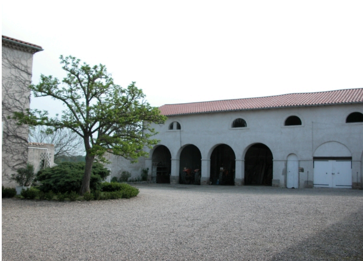
Vue du bâtiment est, depuis la cour.
