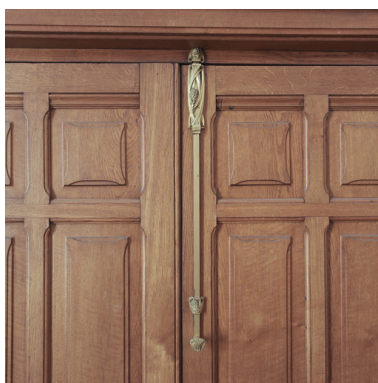
Salle du conseil : crémone de la porte d'entrée. Phot. Didier Gourbin IVR82_20064200904NUCA
