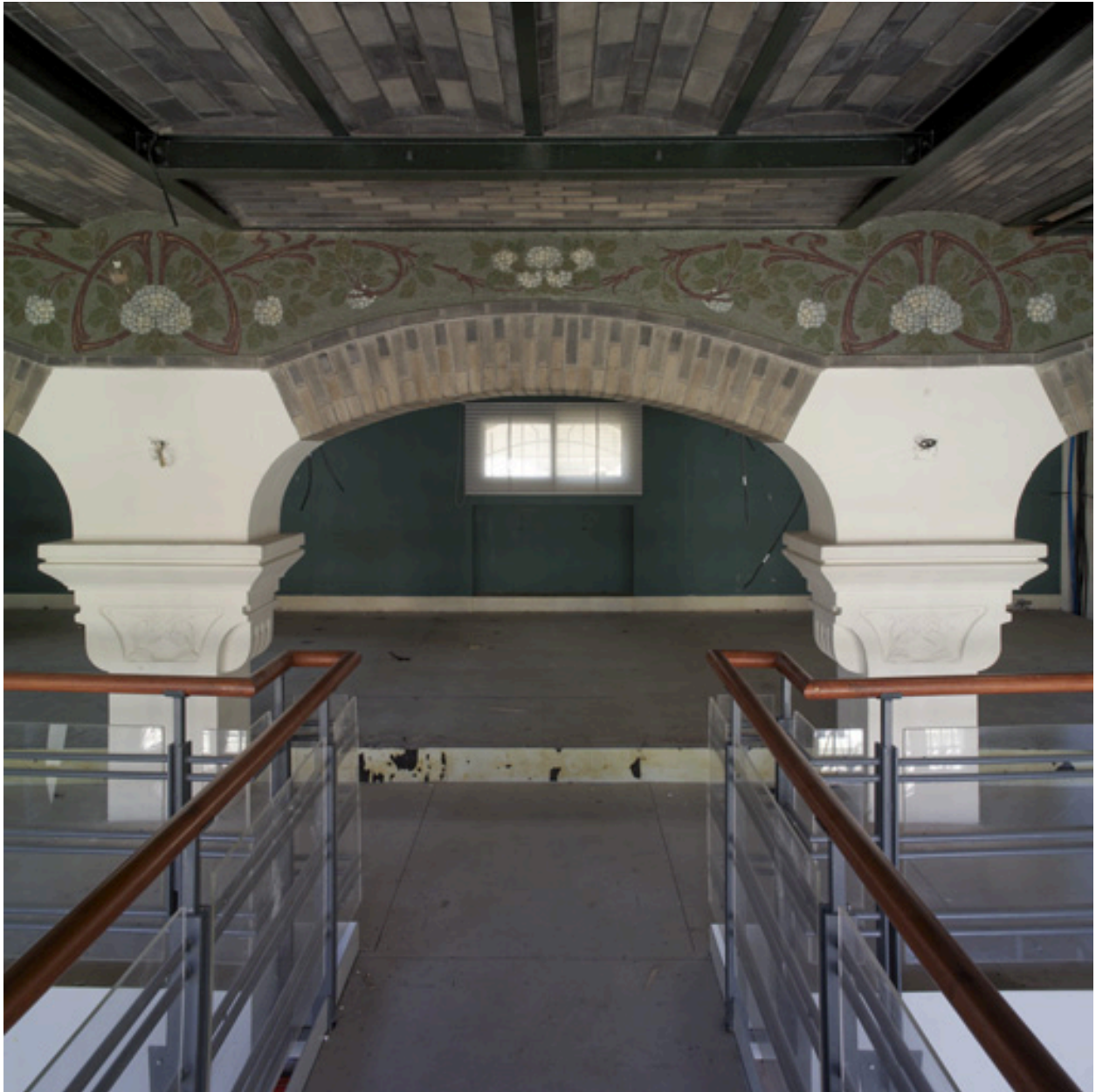
Plafond de la salle des guichets sur entrevous en berceau segmentaire, détail.
