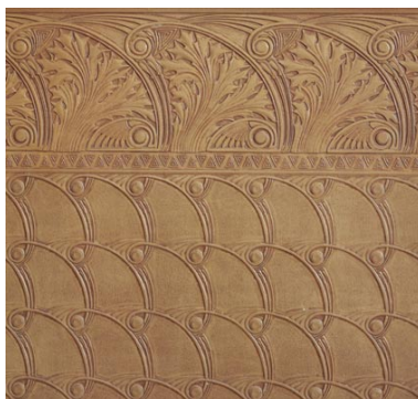
Cabinet du président : lambris d'appui en carton-cuir gaufré. Phot. Didier Gourbin IVR82_20064200899NUCA
