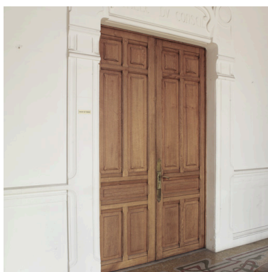
Menuiserie de la porte d'entrée de la salle du conseil. Phot. Didier Gourbin IVR82_20064200896NUCA
