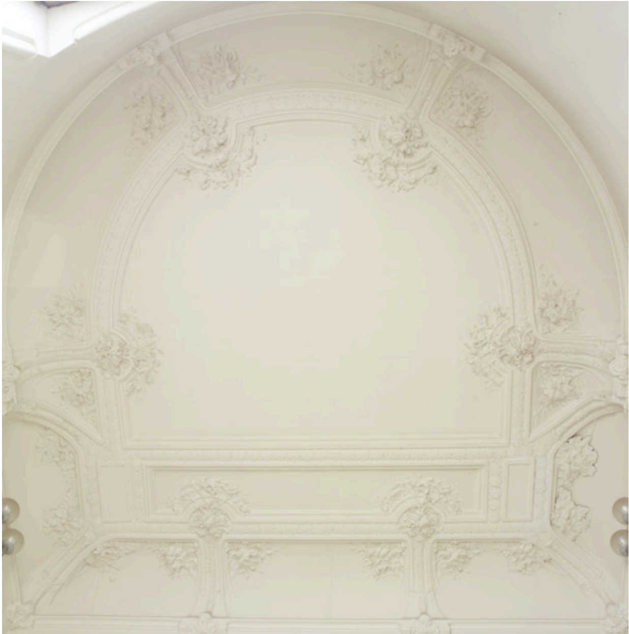
Plafond de l'escalier d'honneur et du palier.
