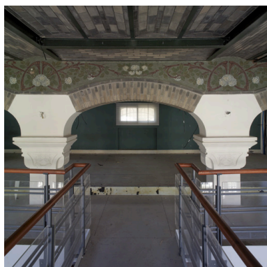
Plafond de la salle des guichets sur entreevous en berceau segmentaire, détail. Phot. Didier Gourbin IVR82_20064200886NUCA
