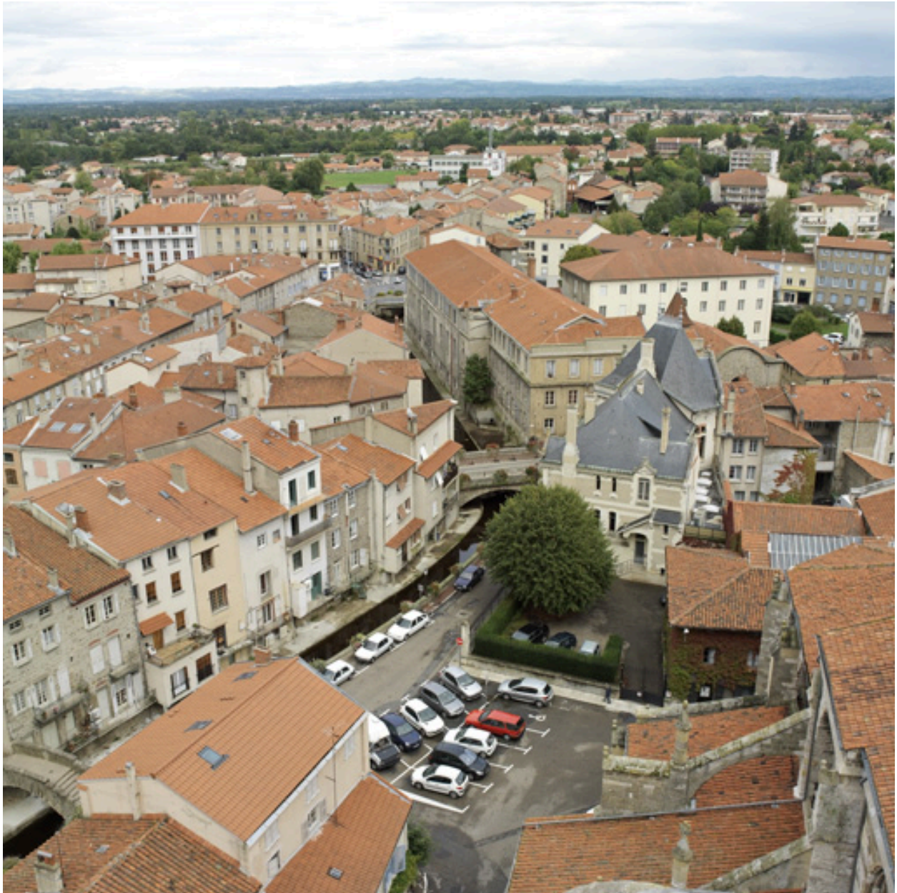
Vue de situation de la Caisse d'épargne depuis le clocher de la Collégiale.
