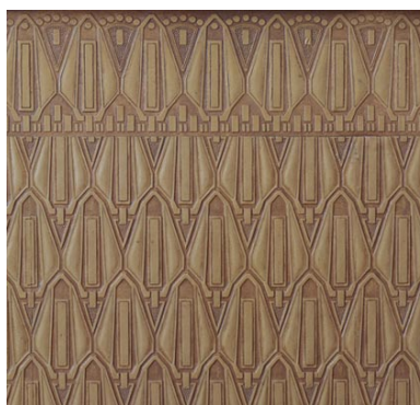
Salle du conseil : lambris d'appui en carton-cuir gaufré. Phot. Didier Gourbin IVR82_20064200898NUCA
