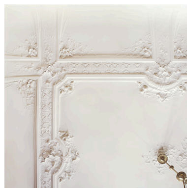
Plafond de la salle du conseil : angle à décor stuqué de motifs floraux. Phot. Didier Gourbin IVR82_20064200903NUCA
