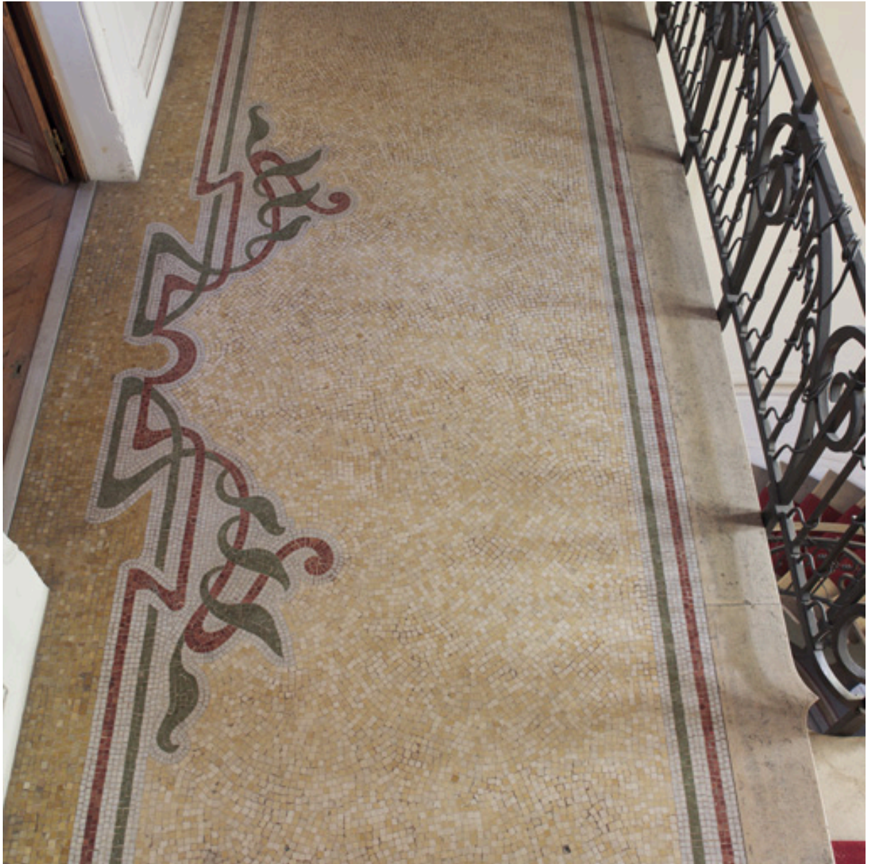
Décor en mosaïque sur le palier du 1er étage : seuil de la salle du conseil.
