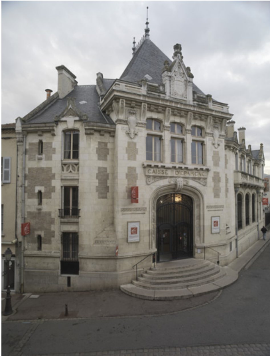
Vue du corps d'entrée.
