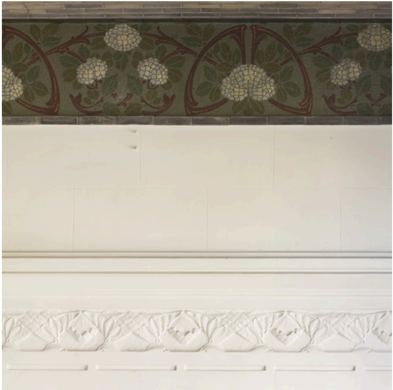
Décor de la partie haute des murs du vestibule d'entrée et de la salle des guichets.
