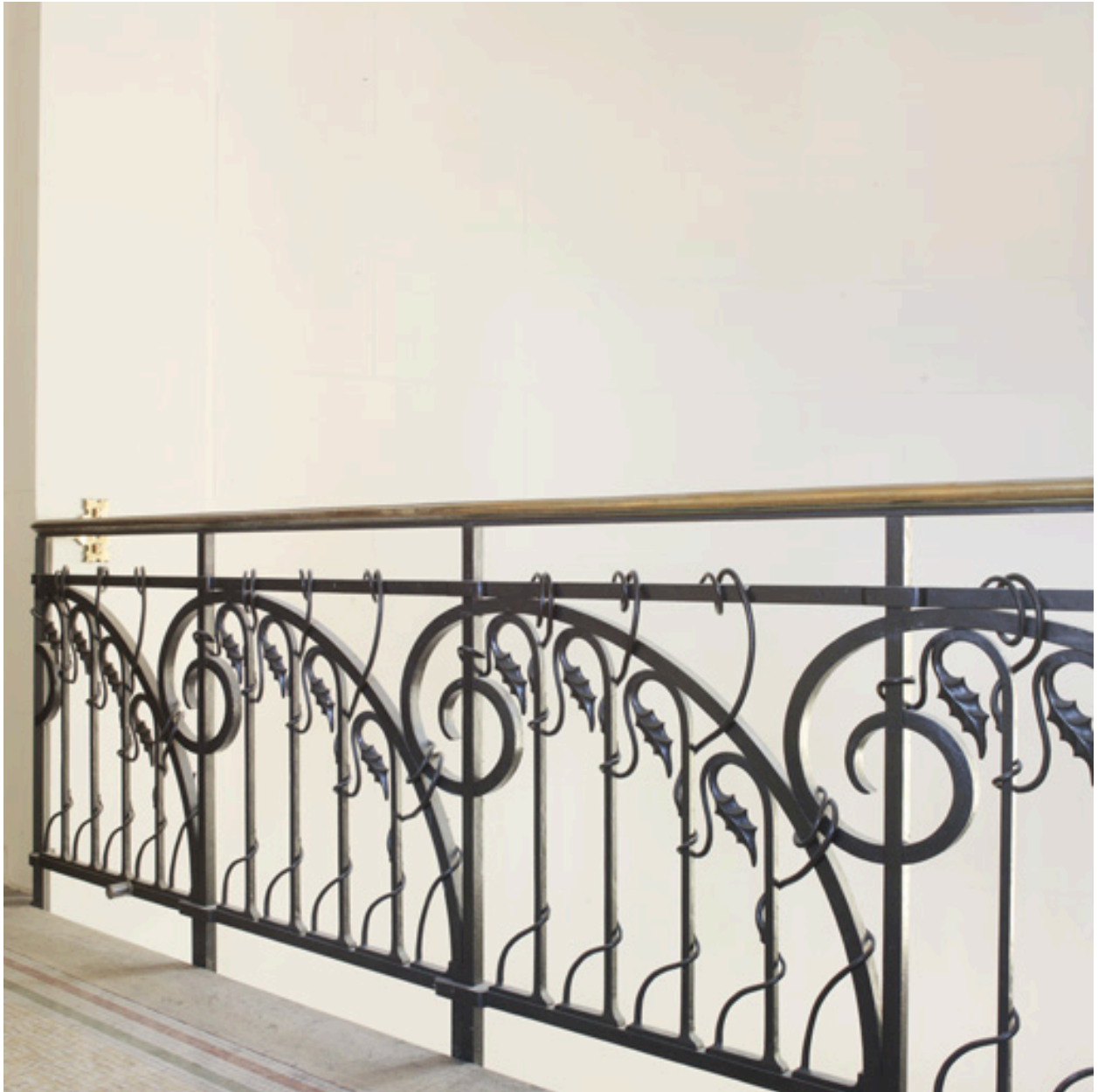
Palier du 1er étage : garde corps en ferronnerie.
