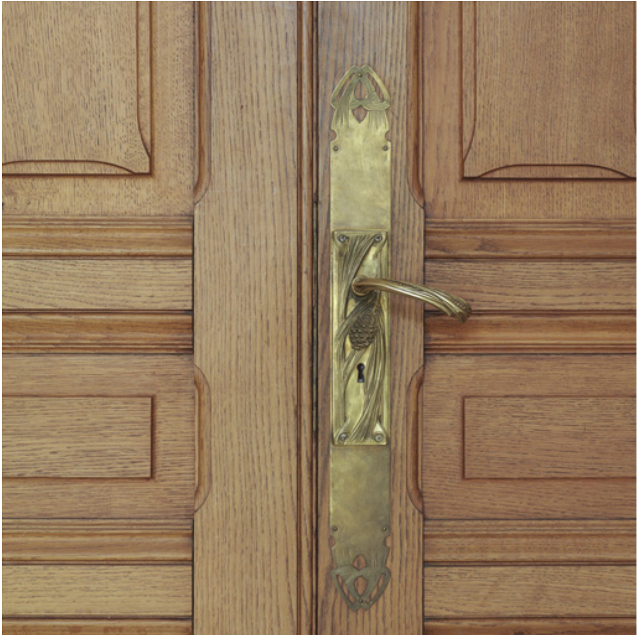
Salle du conseil : ornementation végétale d'une poignée de porte et d'une entrée de serrure en plaque.
