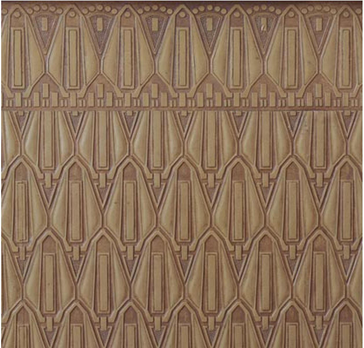
Salle du conseil : lambris d'appui en carton-cuir gaufré.
