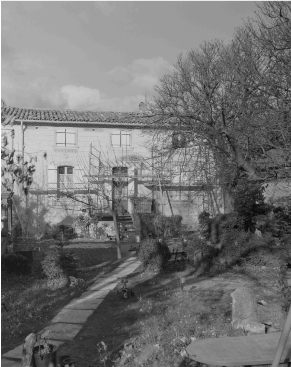
Vue de la façade sur jardin d'un des corps de logis, modernisée au début du 20e siècle.
