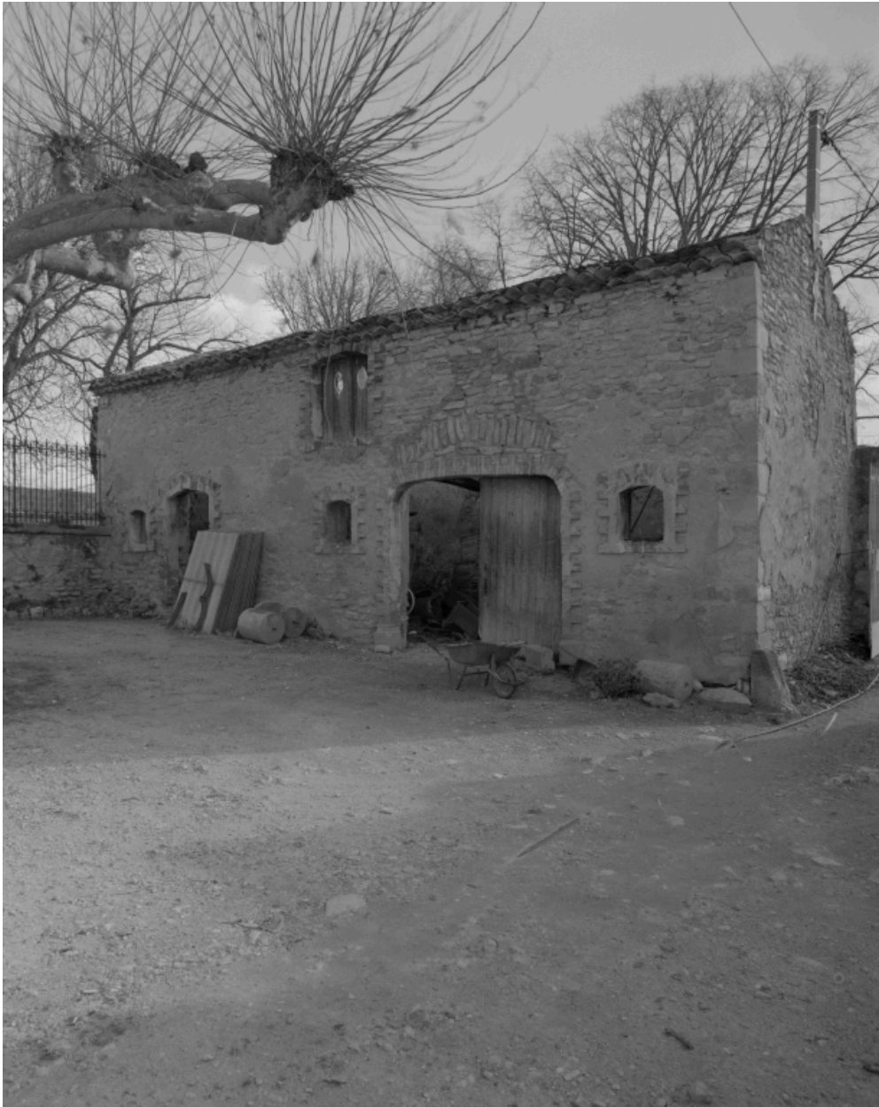
Vue de l'ancienne écurie.
