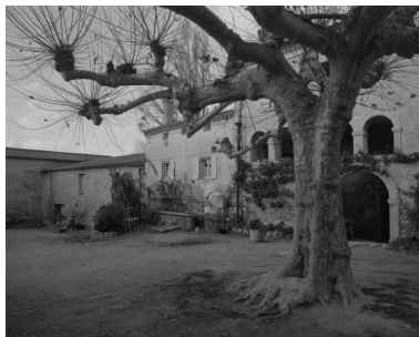
Vue partielle des élévations sur cour des corps de bâtiment nord : dépendances, logis du fermier et du maître.
