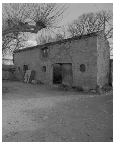
Vue de l'ancienne écurie.
