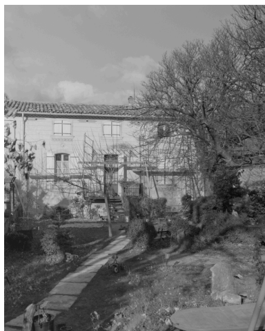
Vue de la façade sur jardin d'un des corps de logis, modernisée au début du 20e siècle.
