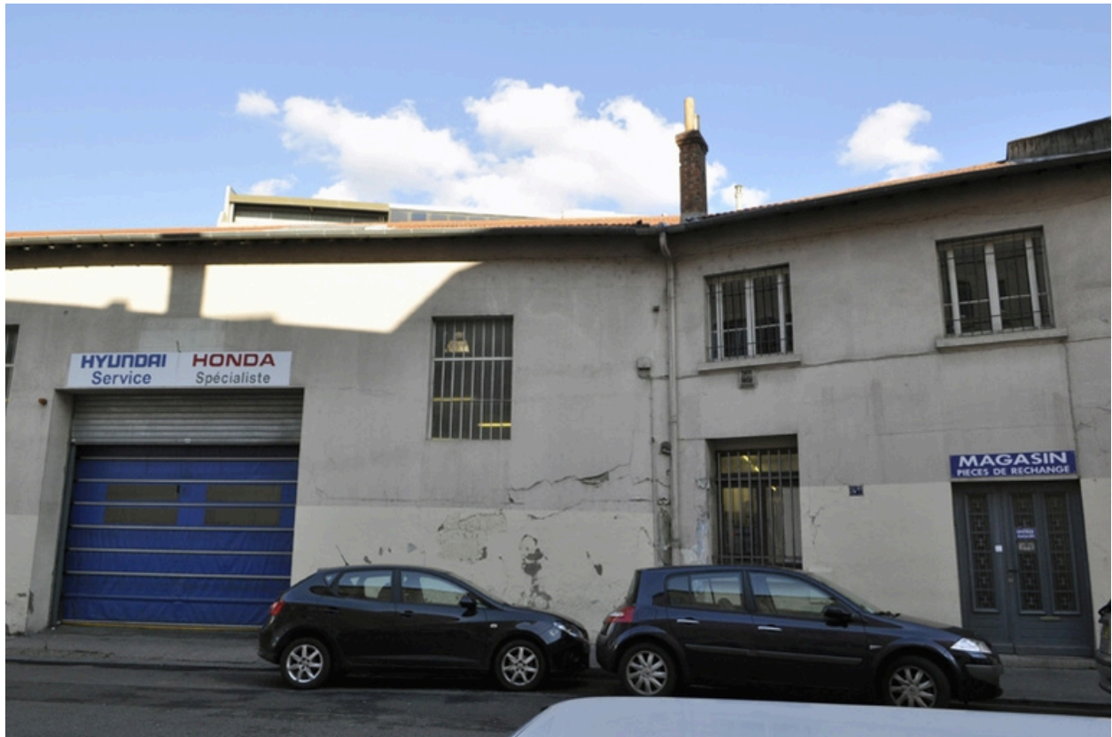
Détail façade est
