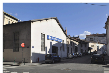
Vue d'ensemble ouest, rue Renan Phot. Nadine Halitim-Dubois IVR82_20126900198NUCA
