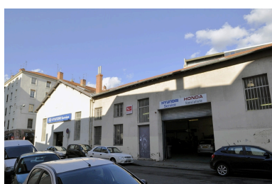
Vue d'ensemble est Phot. Nadine Halitim-Dubois IVR82_20126900199NUCA
