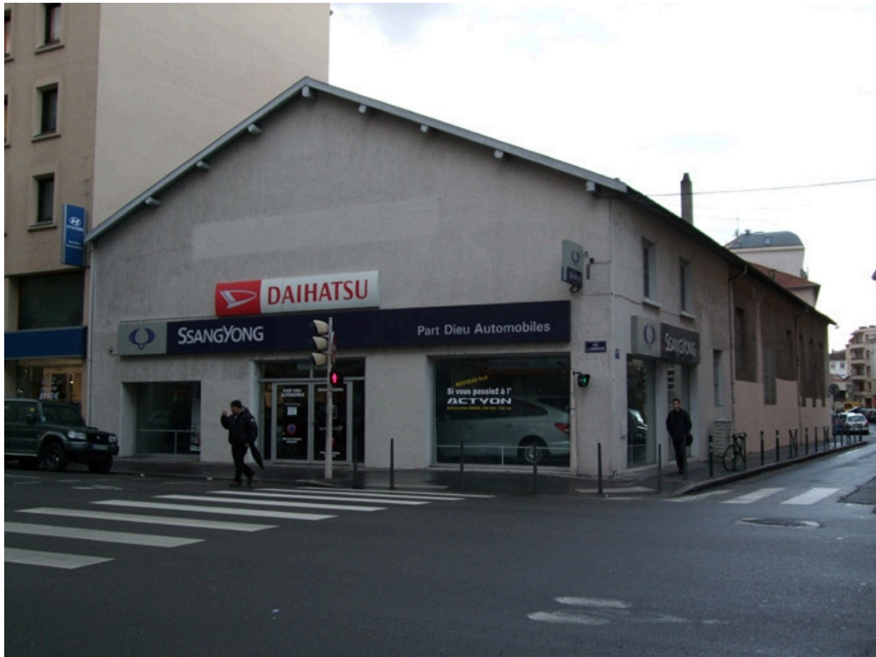
Vue générale nord
