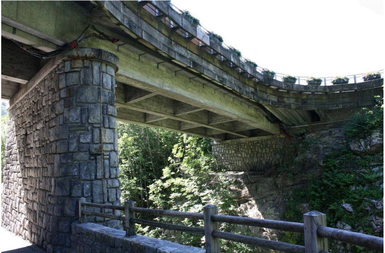
Pont de l'Ars, détail pile et poutraison
