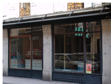
Détail des vitrines Phot. François Fouger IVR82_20047300252NUCA
