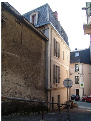
Élévation latérale gauche Phot. François Fouger IVR82_20047300114NUCA
