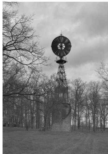
Vue générale de l'éolienne, du sud. Phot. Eric Dessert IVR82_20014201613P
