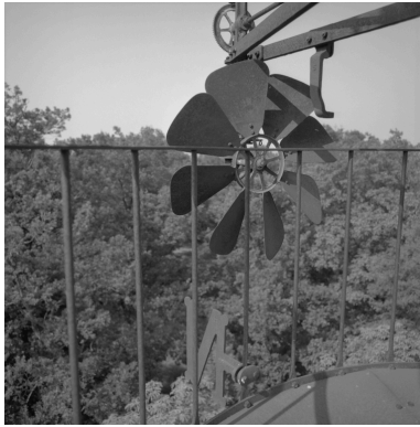
Détail du gouvernail de l'éolienne. Phot. Eric Dessert IVR82_20014201617X
