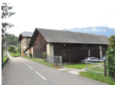
Vue du moulin de Ponturin. Phot. Clara Bérelle IVR82_20157301745NUCA
