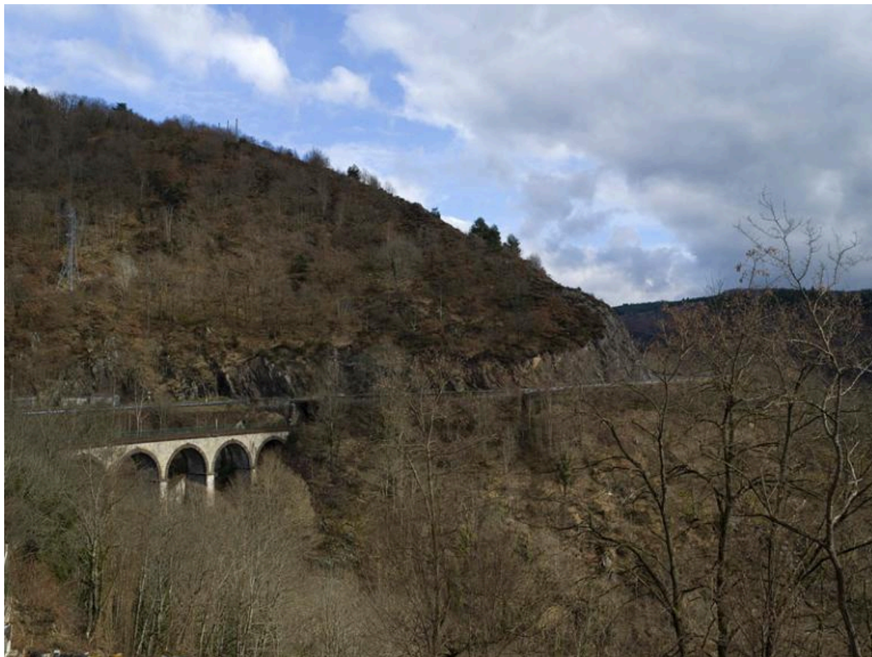
Site de la voie ferrée sur la ligne Thiers - Saint-Etienne : viaduc à proximité du lieu-dit la Roche Noire.
