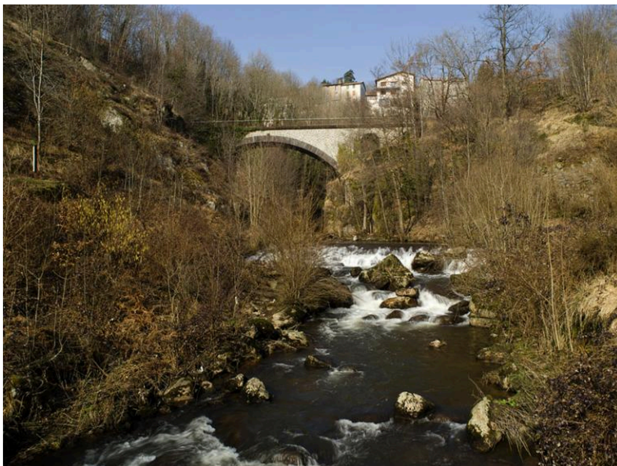
La Durolle enjambée par la voie ferrée, en limite est de la commune, près de Château-Gaillard.
