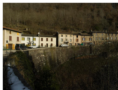
Le lieu-dit le Grand-Tournant. Phot. Jean-Michel Périn IVR83_20116300046NUC4A
