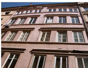
Façade vue par-dessous Phot. Phot. Inv. D. Chevallier IVR82_20046900723NUCA
