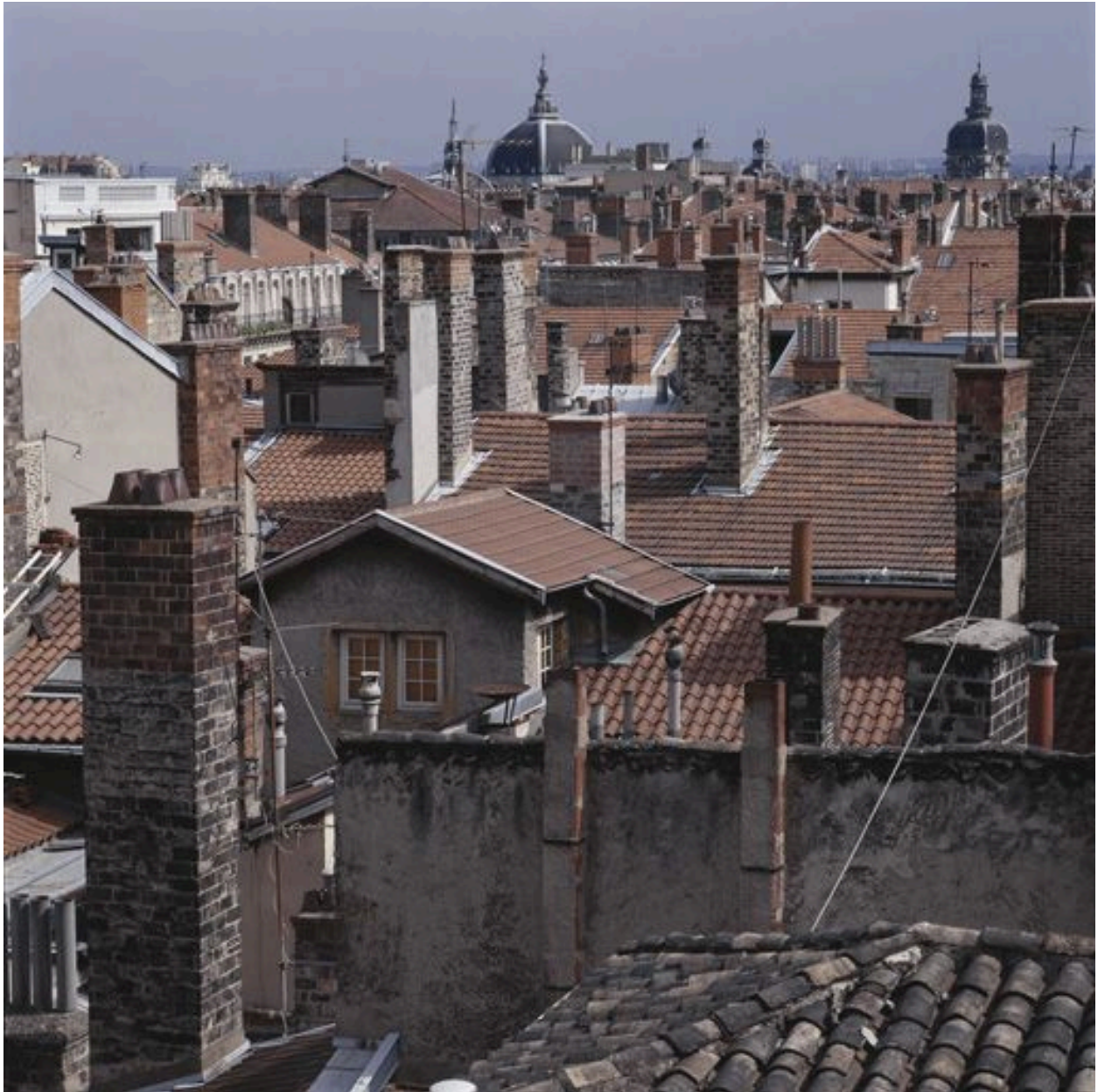
Toit du bâtiment sur rue et pavillon d'escalier vus depuis le haut de la collégiale Saint-Nizier
