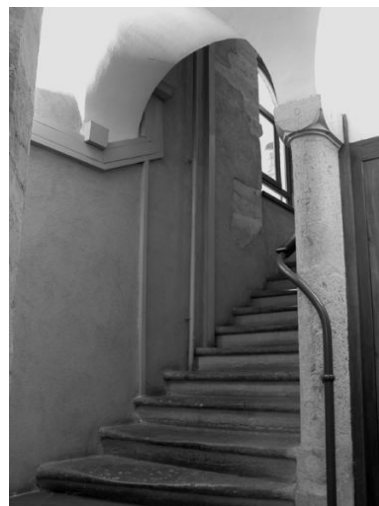
Départ de l'escalier Phot. Phot. Inv. D. Chevallier IVR82_20046900727NUC
