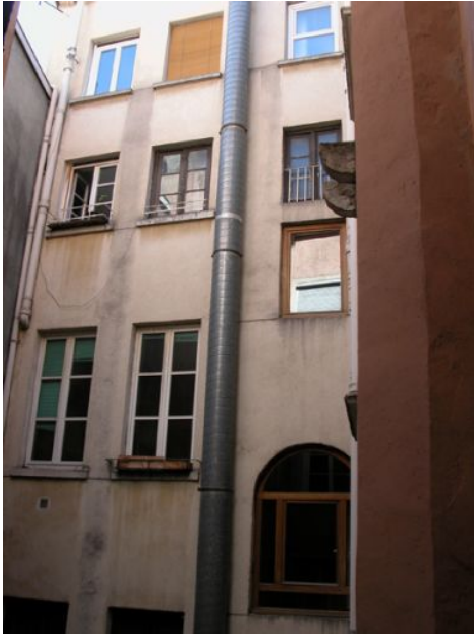
Cour, élévation de l'aile en retour, vue depuis la cour du 5, rue de Brest
