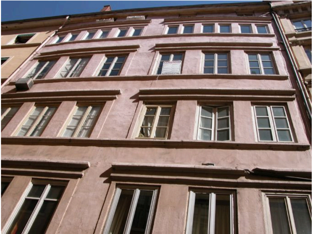
Façade vue par-dessous
