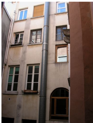
Cour, élévation de l'aile en retour, vue depuis la cour du 5, rue de Brest Phot. Phot. Inv. D. Chevallier IVR82_20046900726NUCA
