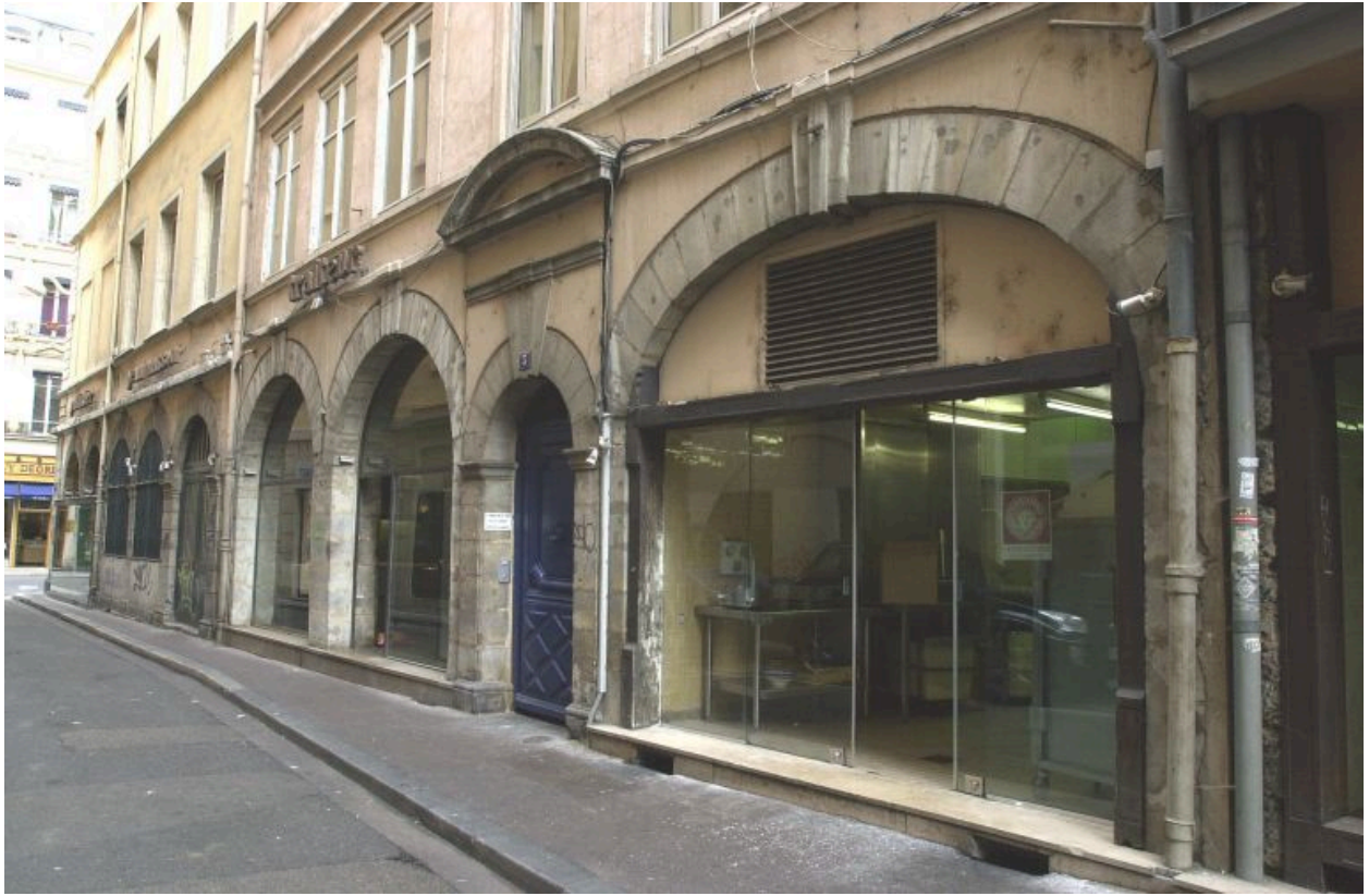
Façade, 1er niveau
