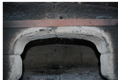
Vue de la bouche du four à pain. Phot. Thierry Monnet IVR84_20207402756NUCA
