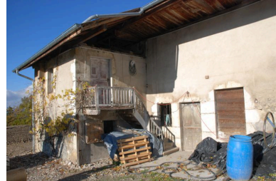
Habitation, élévation sud. Phot. Thierry Monnet IVR84_20207402742NUCA
