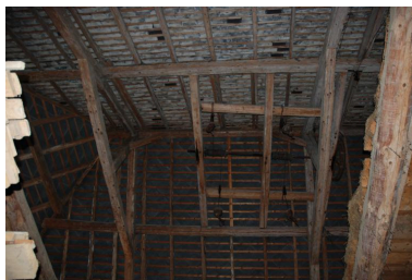
Grange, vue intérieure de la charpente avec monte-foin à quatre câbles. Phot. Thierry Monnet IVR84_20207402752NUCA
