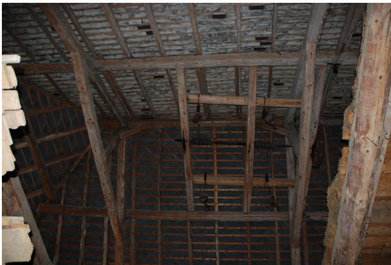
Grange, vue intérieure de la charpente avec monte-foin à quatre câbles.
