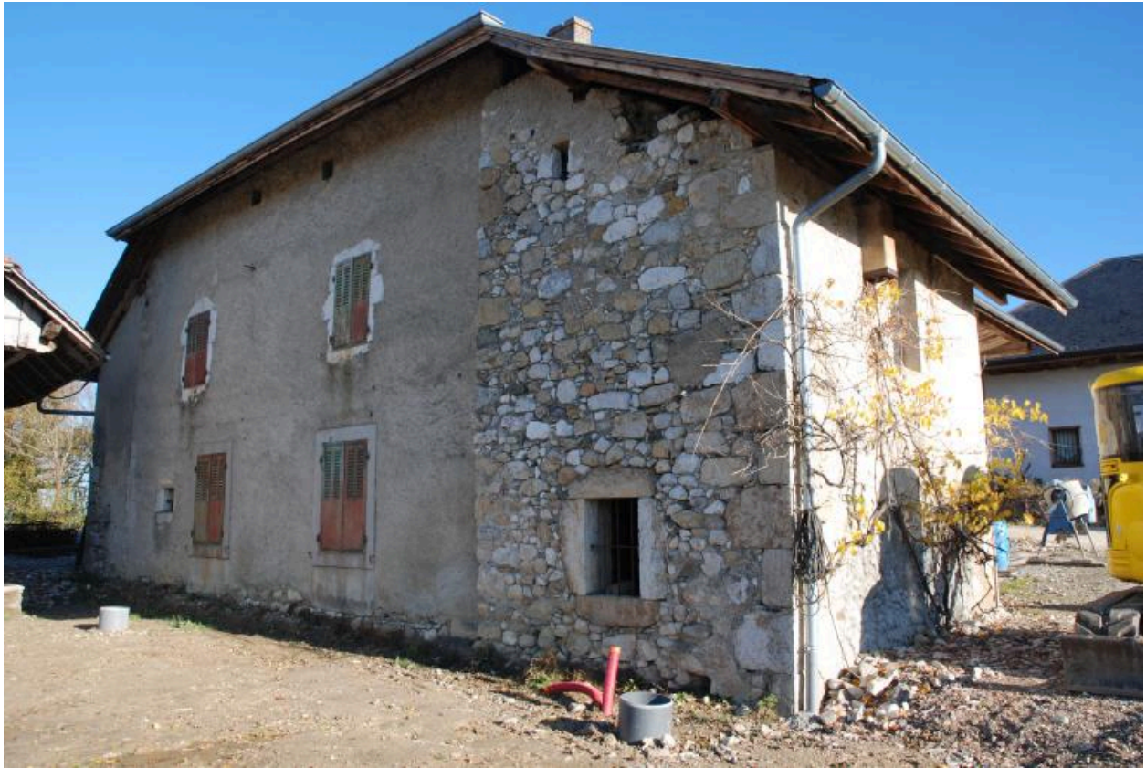
Habitation, vue depuis le sud.
