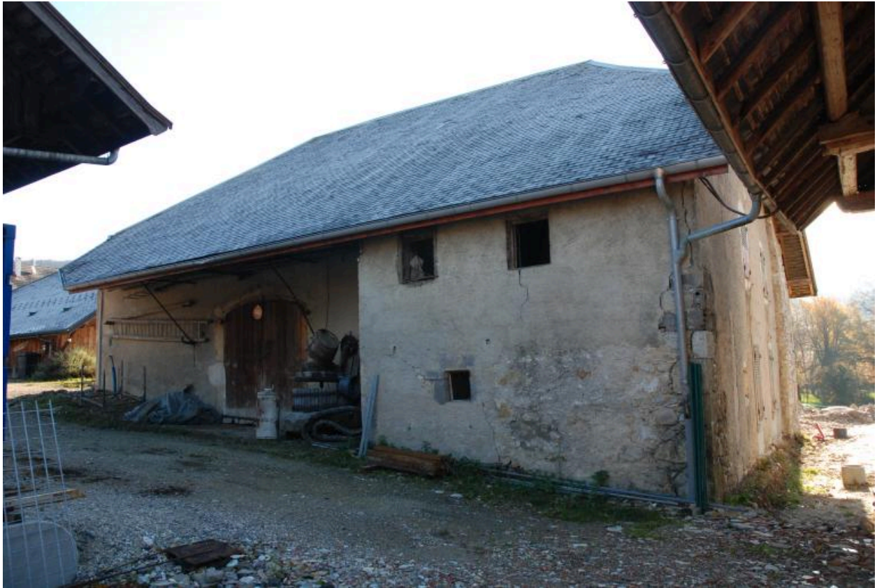
Bâtiment principal, vue d'ensemble depuis le nord-est.
