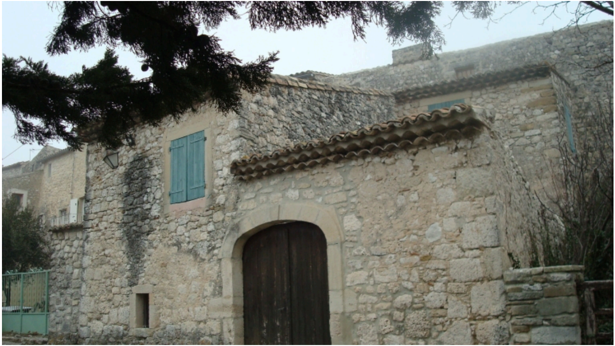
Elévation et portail d'entrée du côté du chemin de la Blache.
