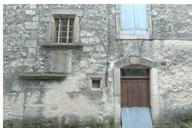
Façade, détail : partie centrale, où voisinent des éléments d'architecture de deux époques différentes. IVR82_20102600632NUCA
