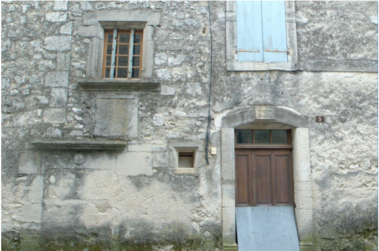
Façade, détail : partie centrale, où voisinent des éléments d'architecture de deux époques différentes.
