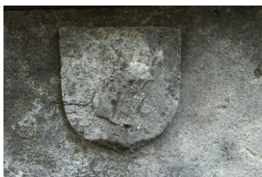
Détail du linteau de la porte murée : écu armorié (armoiries non identifiées). IVR82_20102600633NUCA
