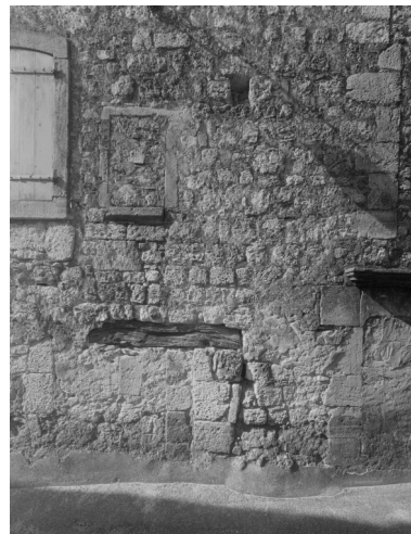
Détail de la façade, partie gauche, montrant plusieurs remaniements : reprise de construction et baies murées. Phot. Eric Dessert IVR82_20002600900P
