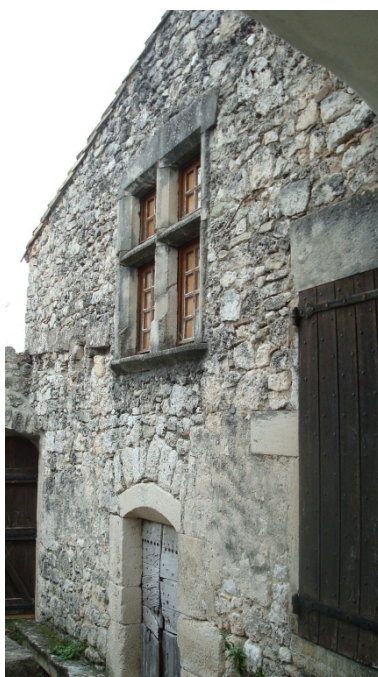
Elévation sur cour du corps en retour. IVR82_20112600004NUCA
