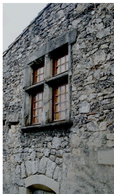
Corps postérieur, élévation sur cour, détail : fenêtre à croisée. IVR82_20112600005NUCA
