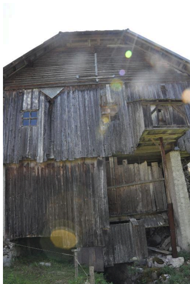
Vue du pignon ouest de la scierie. Phot. Clara Bérelle IVR82_20137301775NUCA
