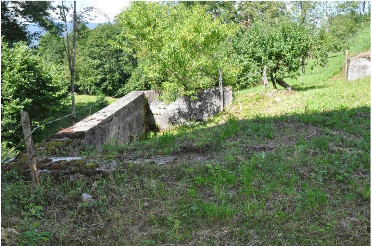
Vue de l'emplacement de l'une des retenues de la scierie permettant d'alimenter une deuxième roue.
