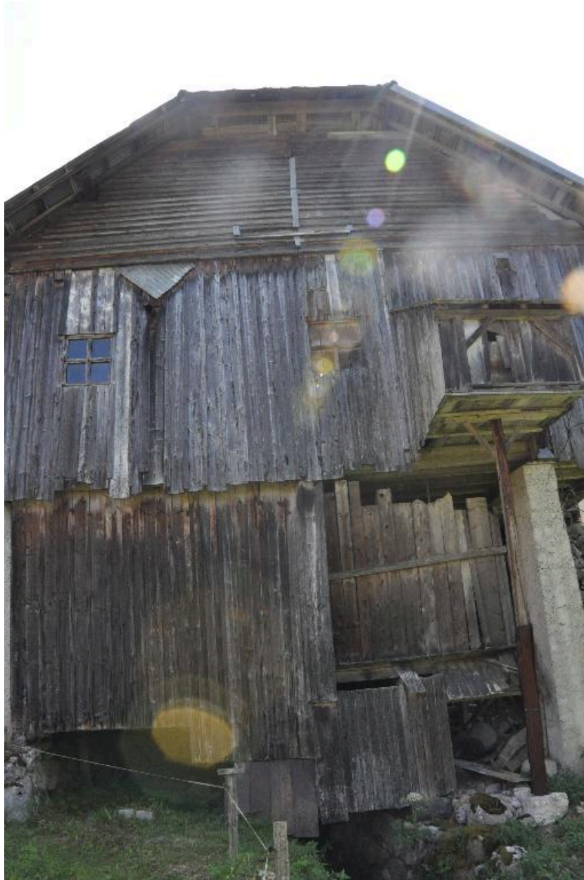
Vue du pignon ouest de la scierie.
