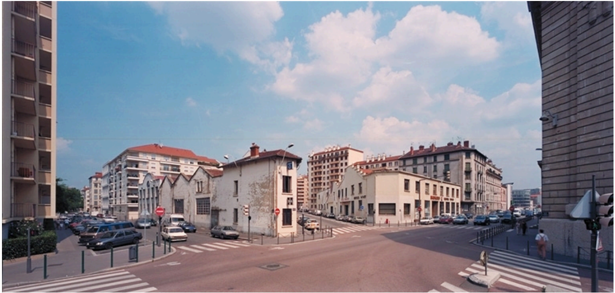
Vue générale des deux bâtiments
