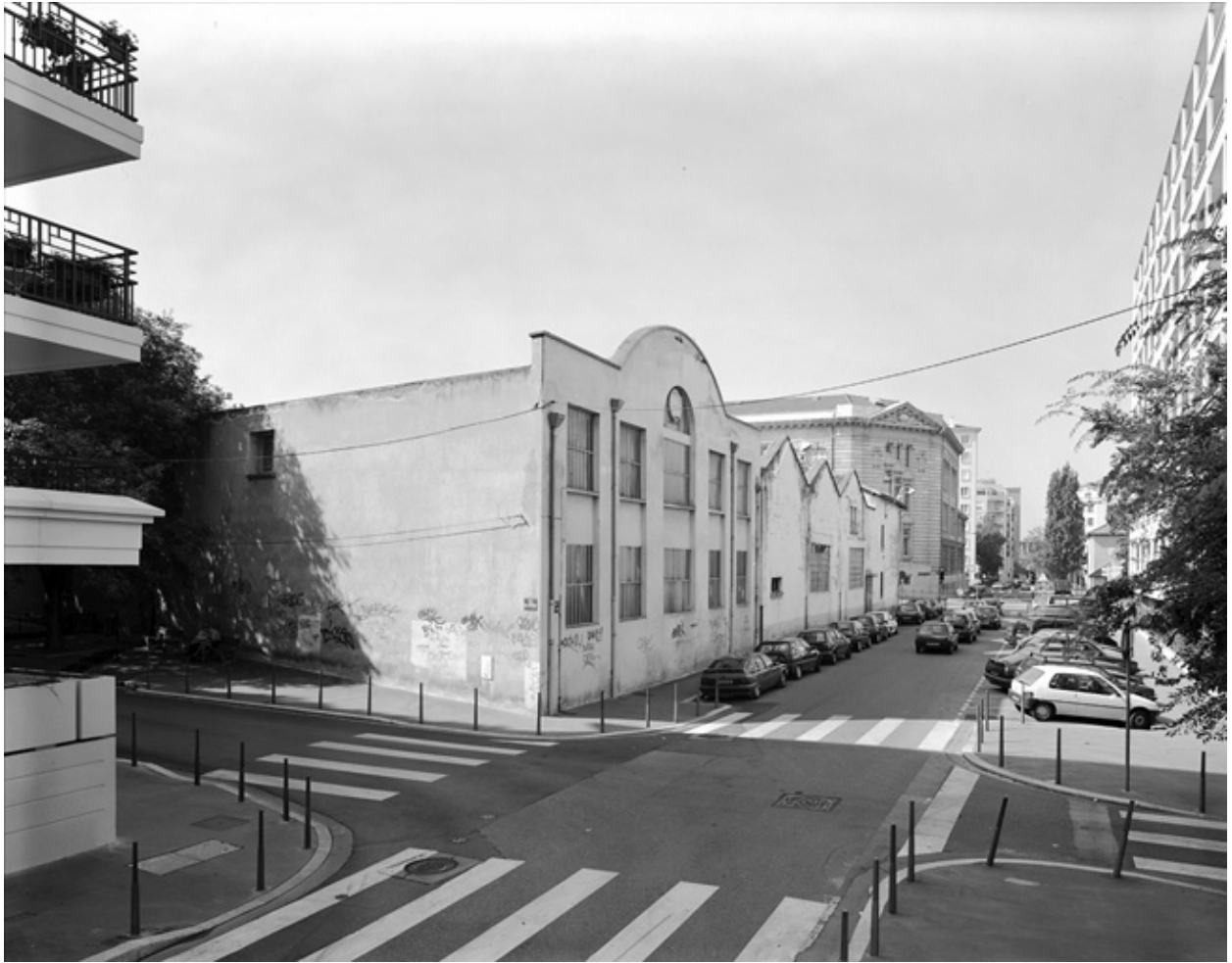
Vue nord-ouest du bâtiment ouest
