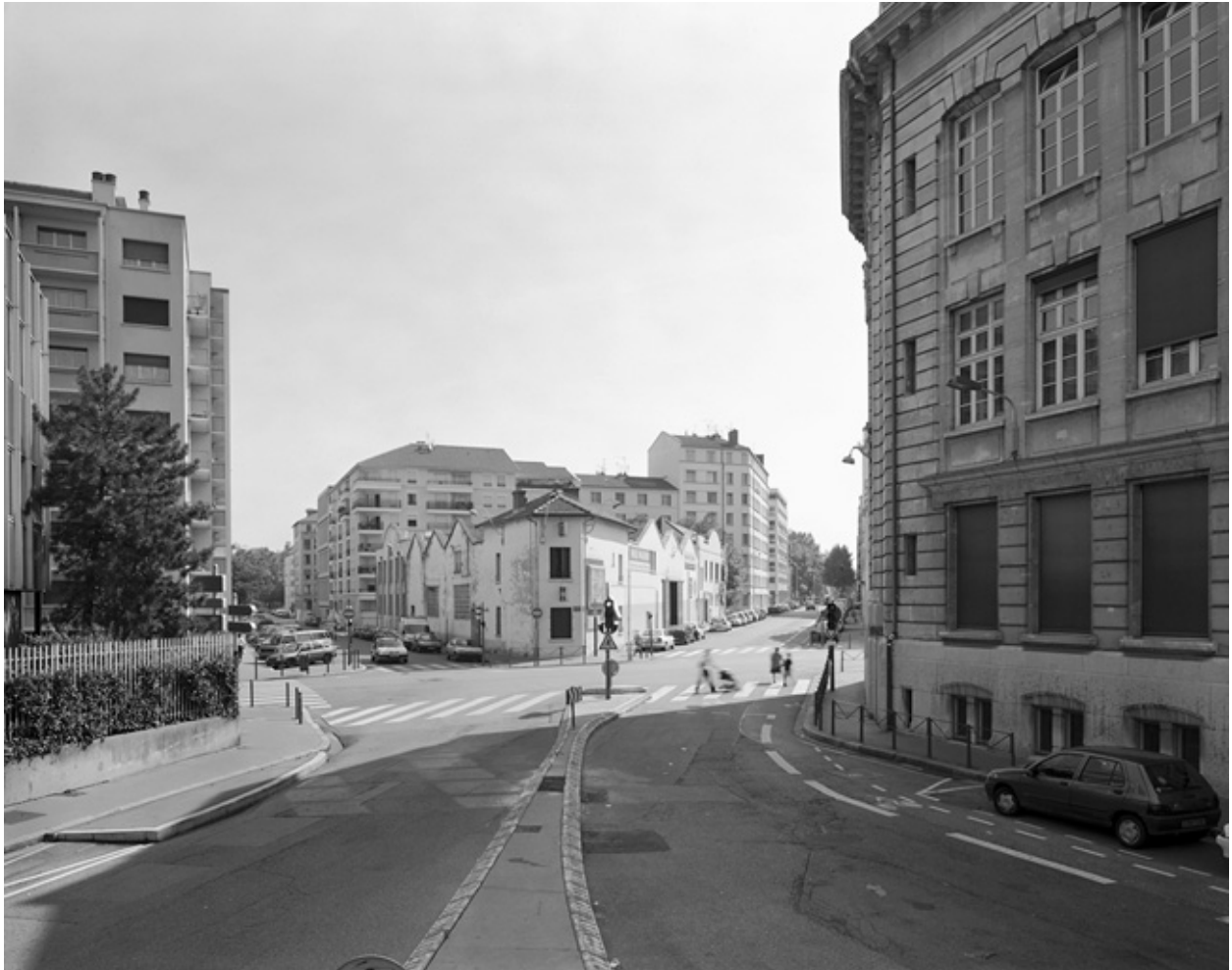
Vue d'ensemble bâtiment ouest, angle rue Lazare et rue Domer
