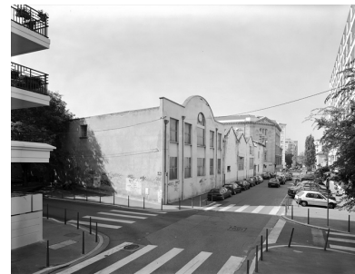
Vue nord-ouest du bâtiment ouest Phot. Eric Dessert IVR82_20016903092V
