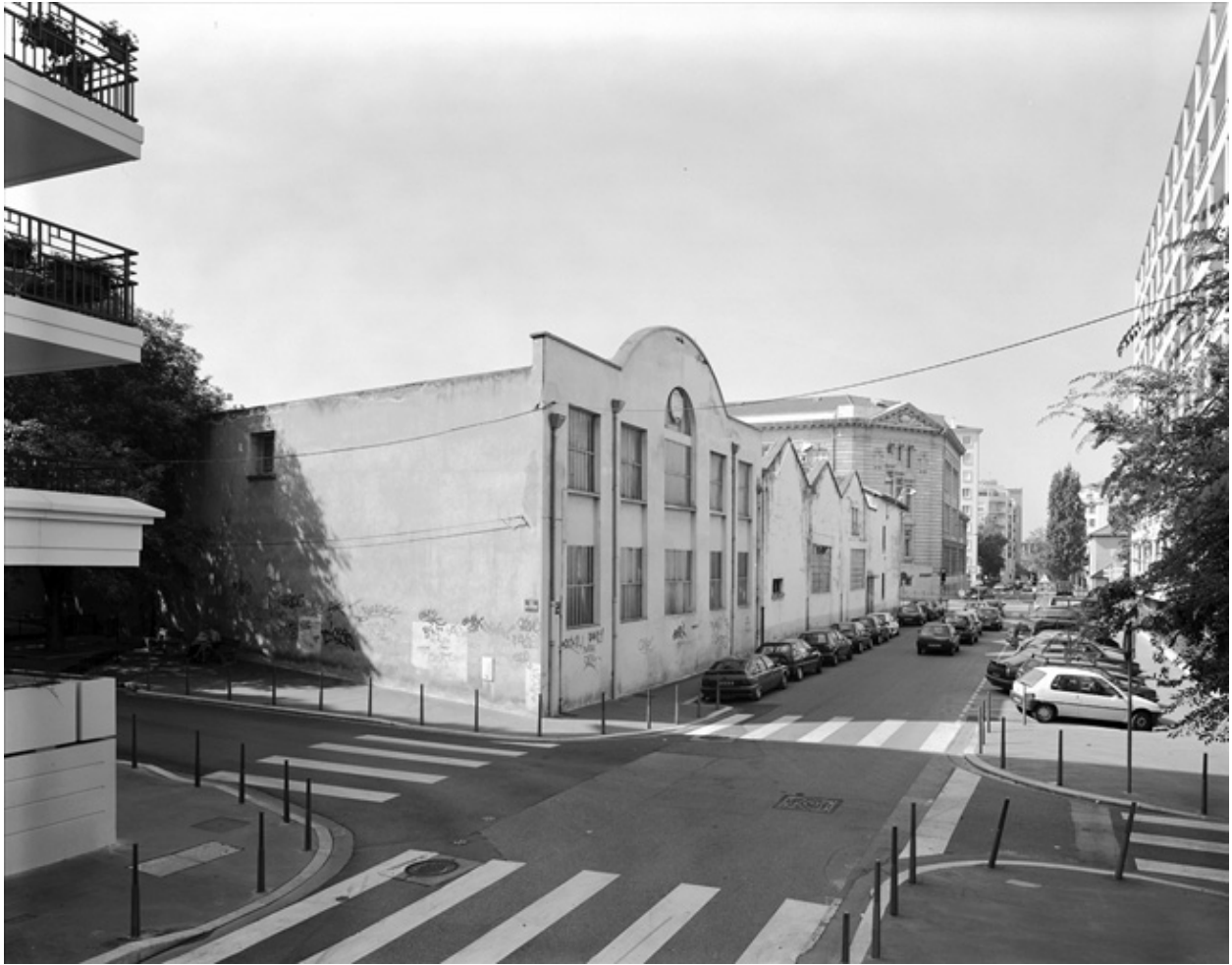
Vue nord-ouest du bâtiment ouest
