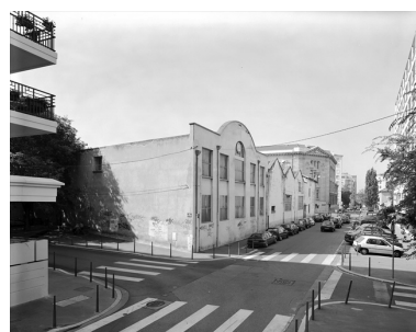
Vue nord-ouest du bâtiment ouest Phot. Eric Dessert IVR82_20016903092V
