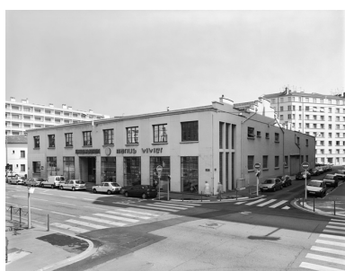
Bâtiment est, angle rue Marc Bloch et rue du Brigadier Voituret Phot. Eric Dessert IVR82_20016903093V
