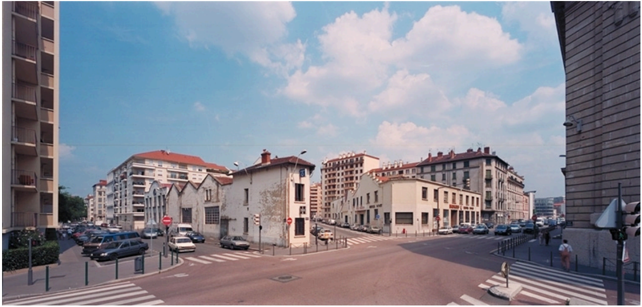
Vue générale des deux bâtiments
