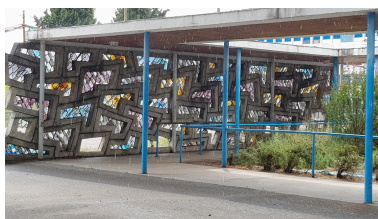
Mur avant sa démolition en 2022 Phot. Patrick Dutronc IVR84_20223800079NUCA
