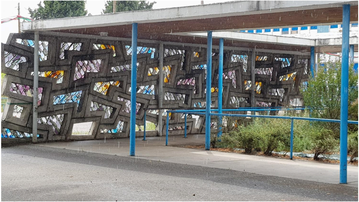
Mur avant sa démolition en 2022
