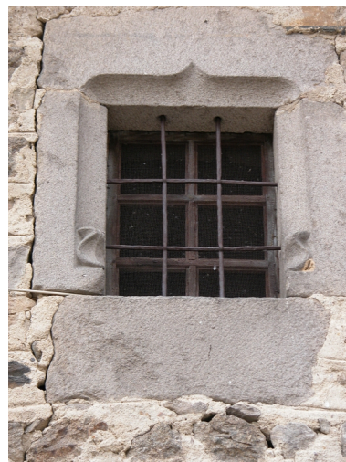
Détail d'ouverture en remploi sur l'élévation ouest : fenêtre à linteau en accolade. Phot. Thierry Monnet IVR82_20124200877NUCA
