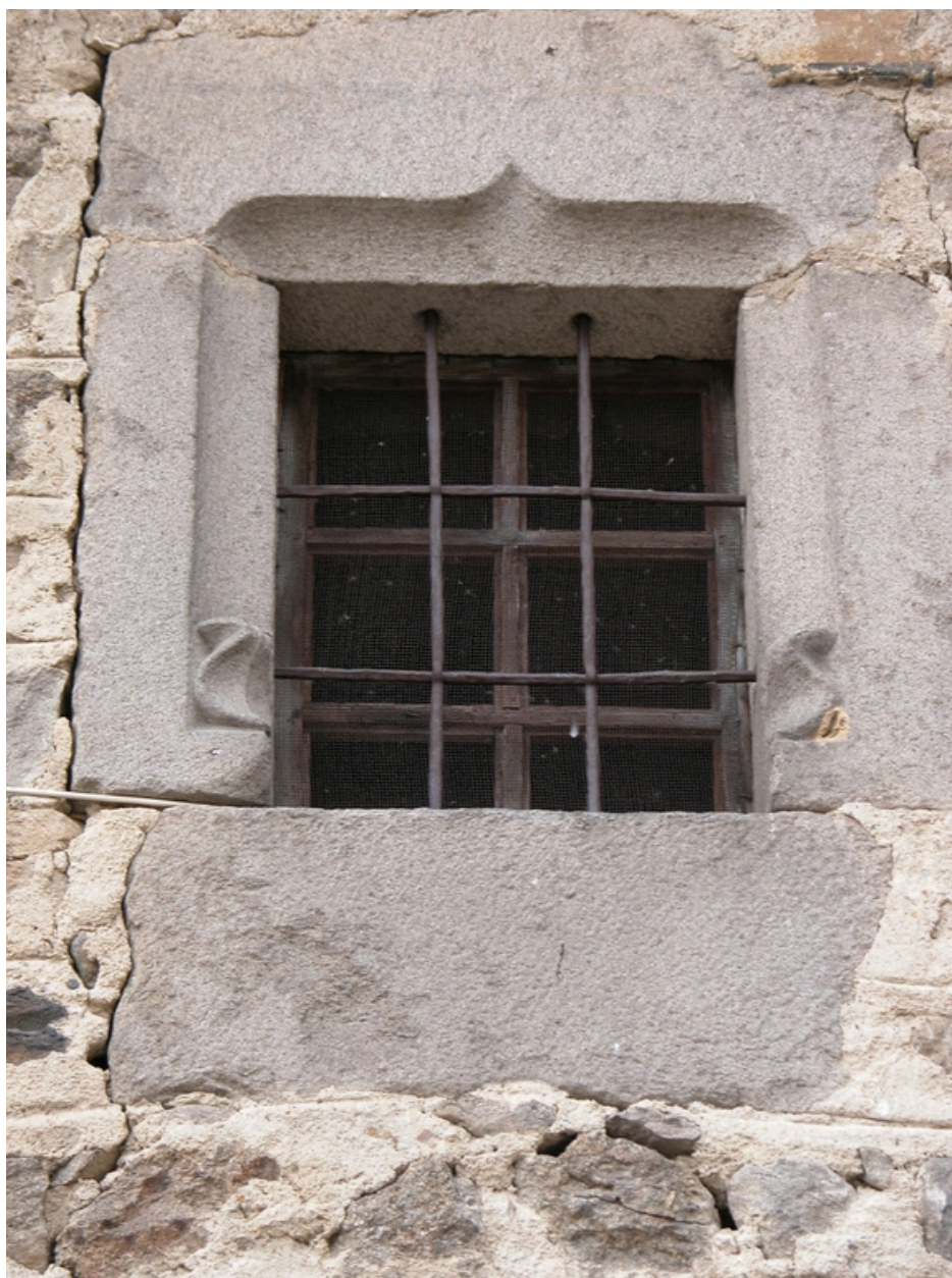
Détail d'ouverture en remploi sur l'élévation ouest : fenêtre à linteau en accolade.
