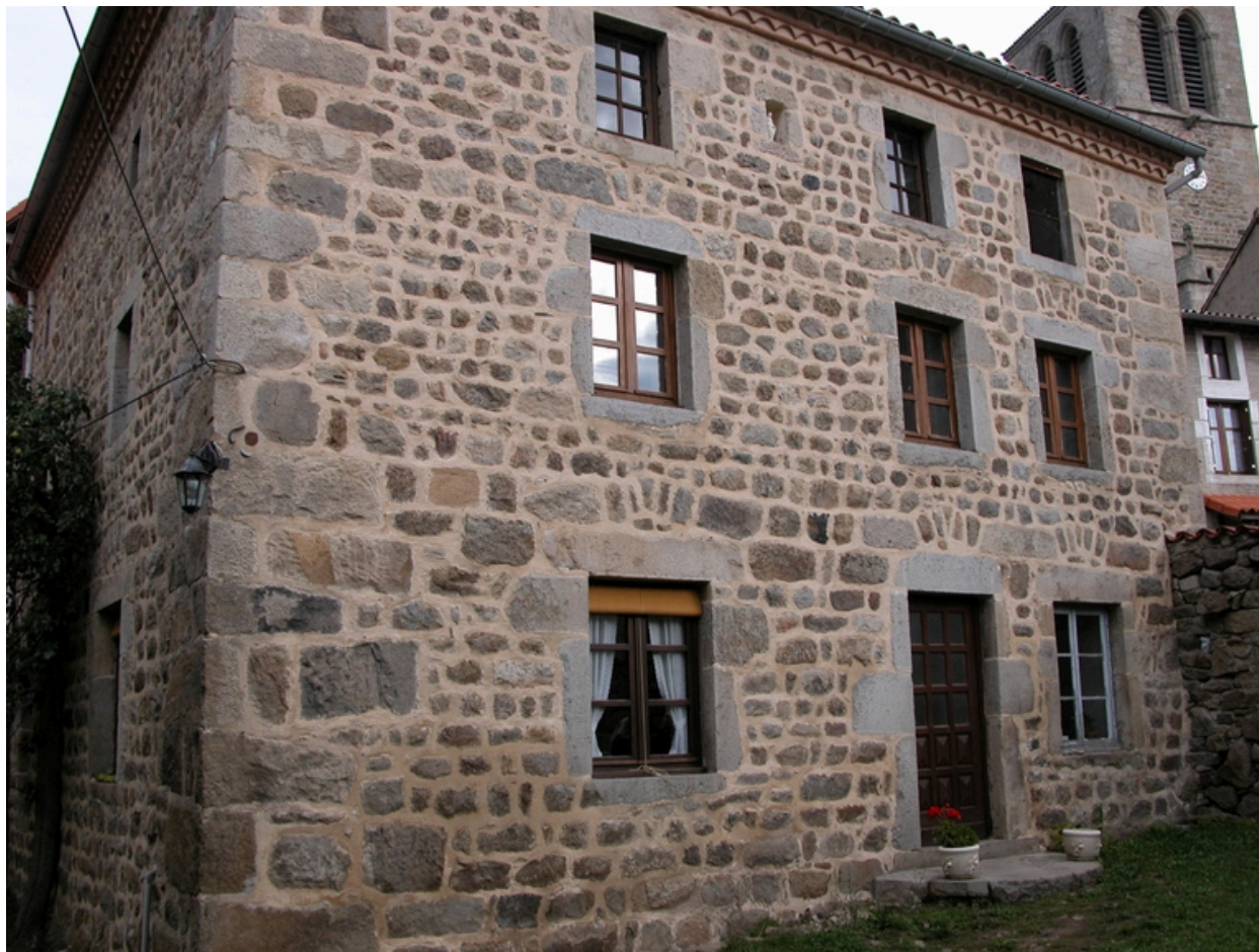
Vue d'ensemble de la façade sud du second logis.
