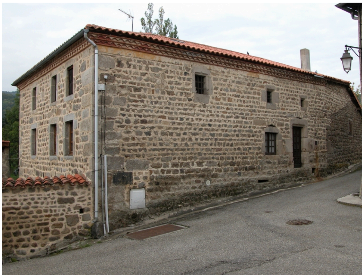
Vue générale depuis le sud-ouest.
