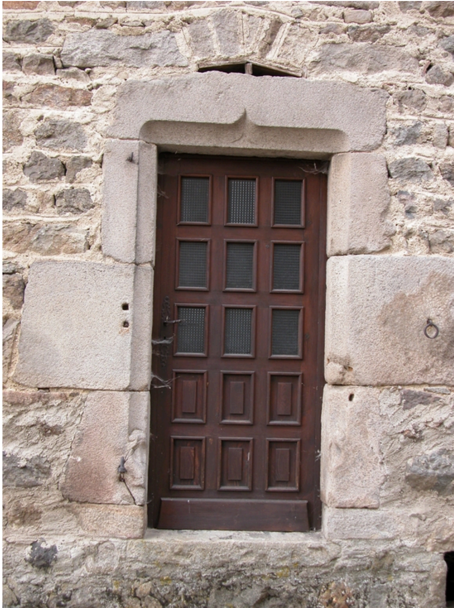
Détail d'ouverture en remploi sur l'élévation ouest : porte à linteau en accolade.
