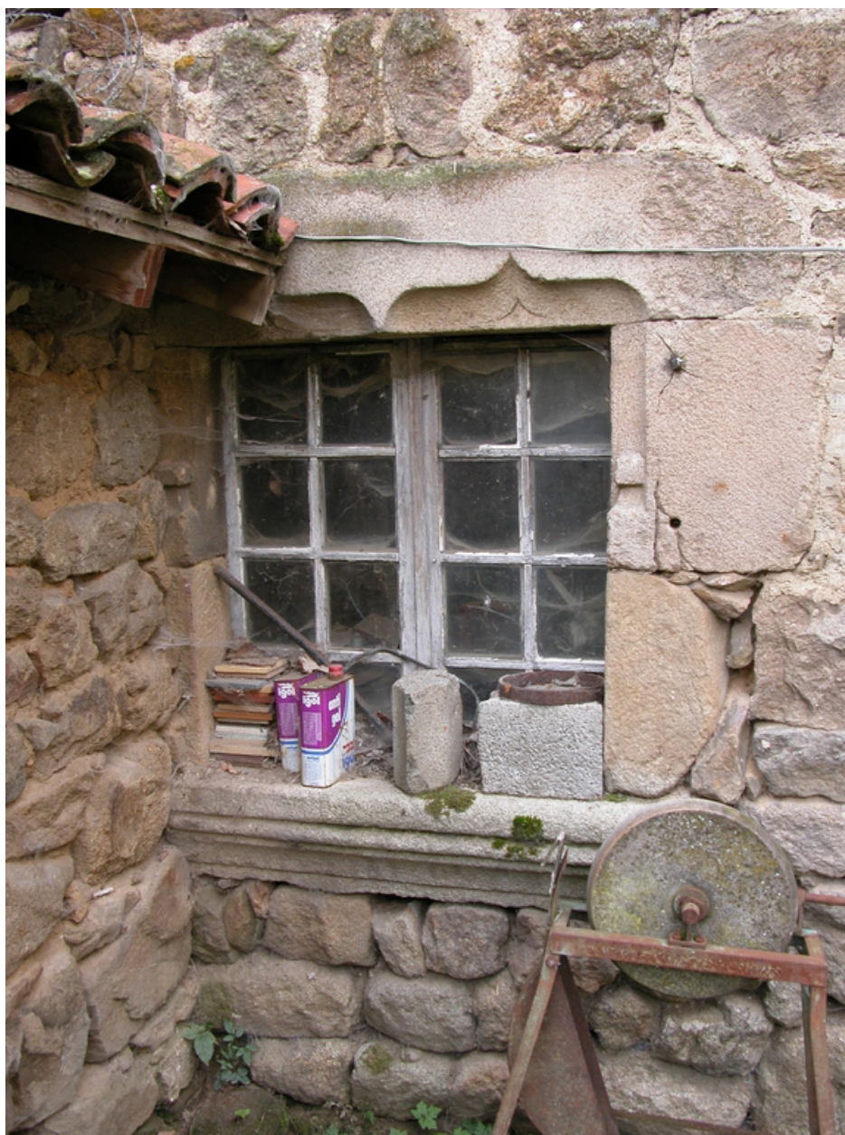
Fenêtre de la cuisine du logis ancien.
