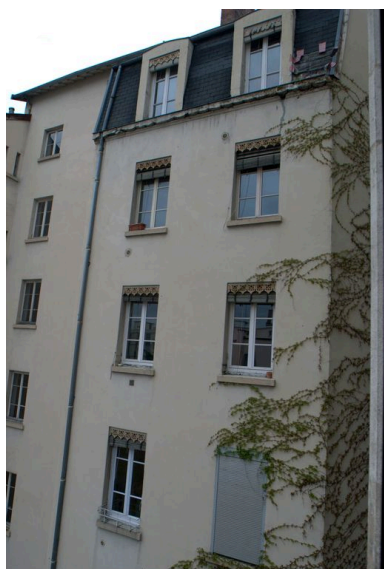
Elévation postérieure, détail Phot. Maryannick Chalabi IVR82_20106905096NUCA
