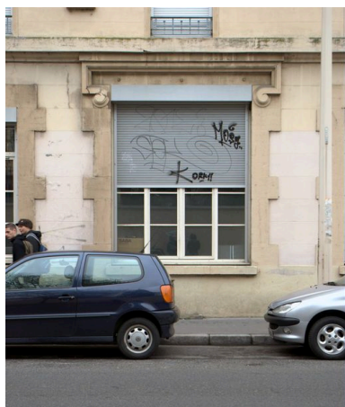
Détail d'une baie du rez-de-chaussée Phot. Maryannick Chalabi IVR82_20106905094NUCA
