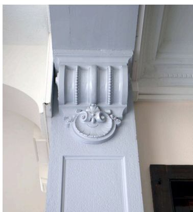
Passage cocher, détail d'une console Phot. Maryannick Chalabi IVR82_20106905100NUCA
