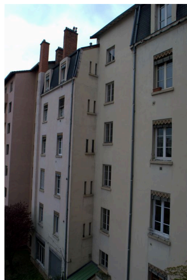
Elévation postérieure Phot. Maryannick Chalabi IVR82_20106905095NUCA
