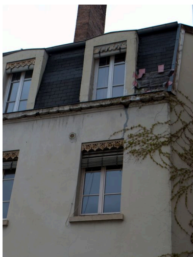
Elévation postérieure, détail de l'étage de comble Phot. Maryannick Chalabi IVR82_20106905097NUCA
