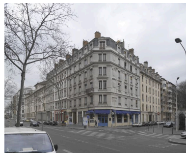
Vue d'ensemble depuis le nord Phot. Eric Dessert IVR82_20056900632NUCA
