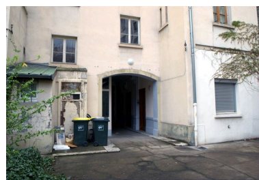
Vue du passage cocher depuis la cour Phot. Maryannick Chalabi IVR82_20106905098NUCA
