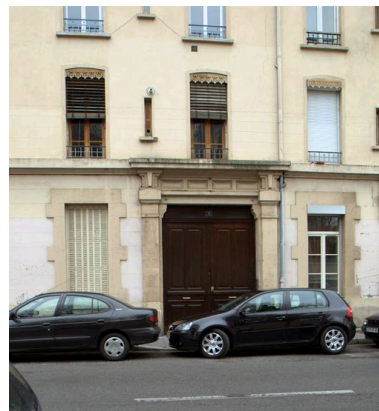
Détail de la porte sur rue Phot. Maryannick Chalabi IVR82_20106905093NUCA
