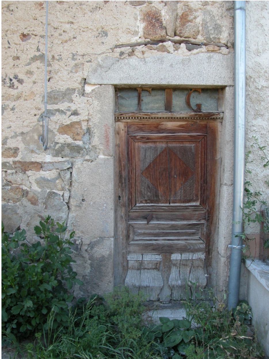
Détail de la porte d'entrée du premier logis.
