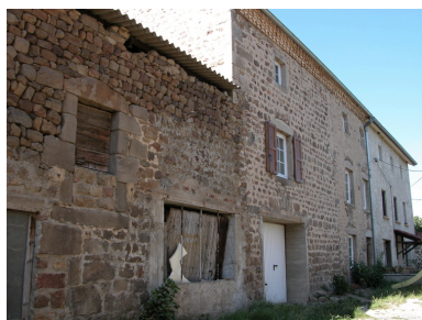
Vue d'ensemble d'une partie de la première grange-étable et des deux logis, depuis le sud-est.
