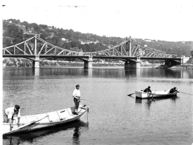
Le pont de la Mulatière, [1ere moitié XXe siècle]. Photogr. IVR82_20026903075NUCB
