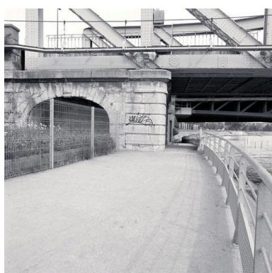
Arche maçonnée supportant le départ du pont Phot. Eric Dessert IVR82_20026903199X
