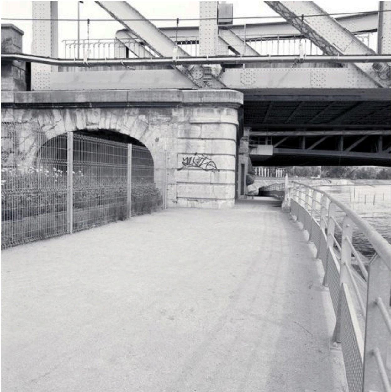
Arche maçonnée supportant le départ du pont
