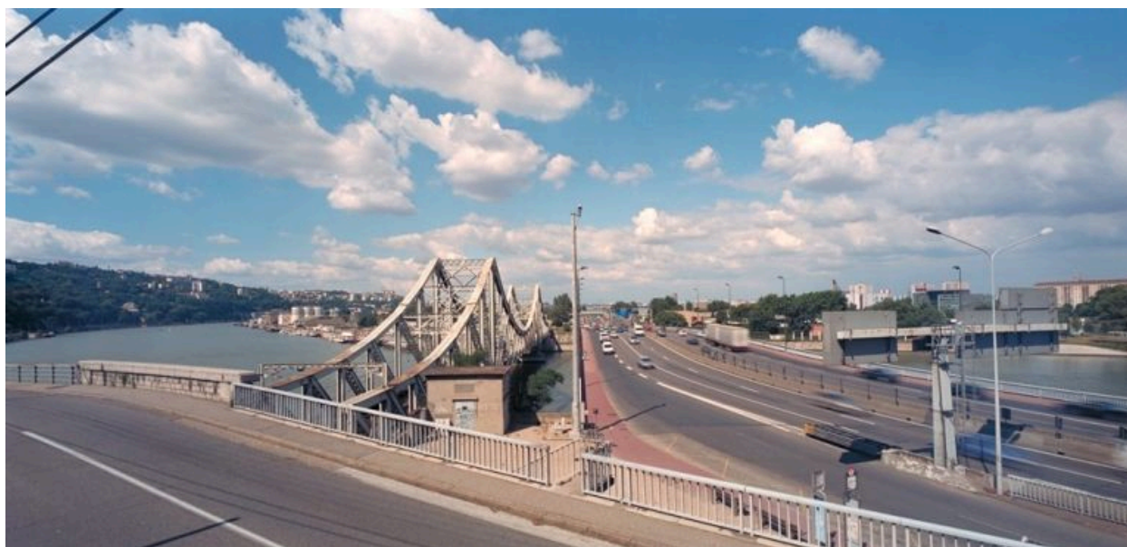
Le pont et le port Raimbaud depuis le sud
