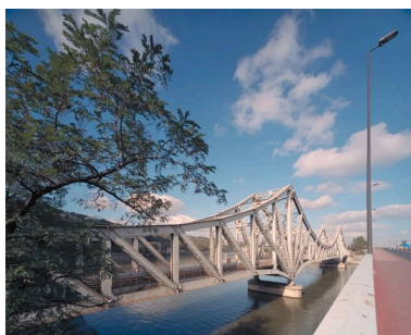
Vue d'ensemble depuis le nord-est Phot. Eric Dessert IVR82_20026903057VE
