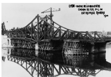
Viaduc de la Mulatière, 1914. Carte postale IVR82_20026903072NUCB
