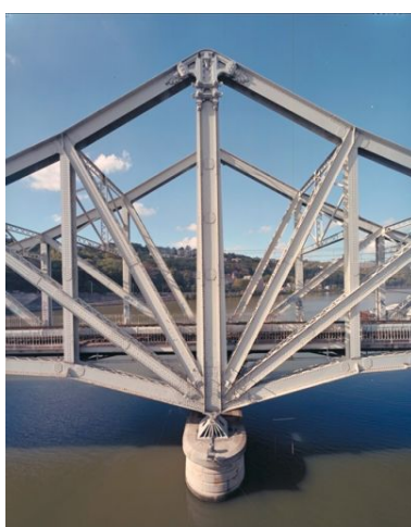
Détail d'une pile et d'un montant Phot. Eric Dessert IVR82_20026903058VE
