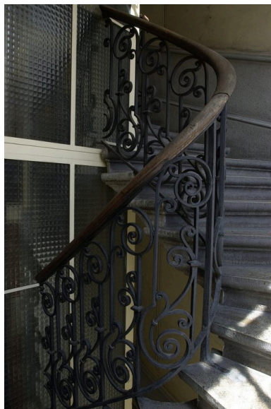
Garde-corps de l'escalier Phot. Bernard Ducouret IVR82_20046905248NUCA
