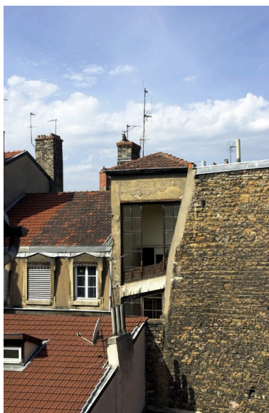
La tour d'escalier vue depuis celui de l'immeuble sis 60 rue du Président-Edouard-Herriot Phot. Bernard Ducouret IVR82_20046905316NUCA
