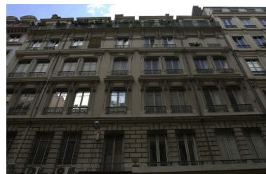
Elévation antérieure : partie supérieure Phot. Bernard Ducouret IVR82_20046905246NUCA
