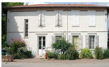
Façade principale (sud) : entrée principale à gauche. La fenêtre verticale à l'extrême gauche correspond à l'escalier secondaire.
