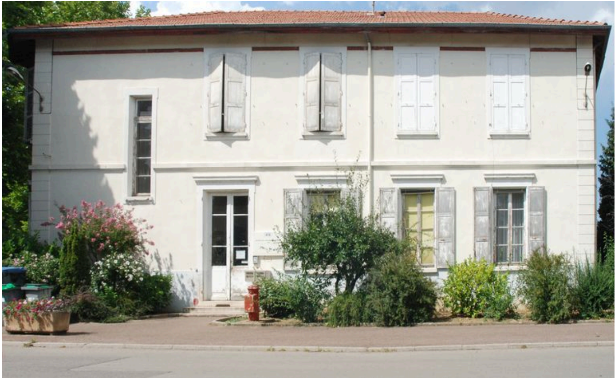
Façade principale (sud) : entrée principale à gauche. La fenêtre verticale à l'extrême gauche correspond à l'escalier secondaire. Un cordon de briques relie les linteaux des fenêtres de l'étage
