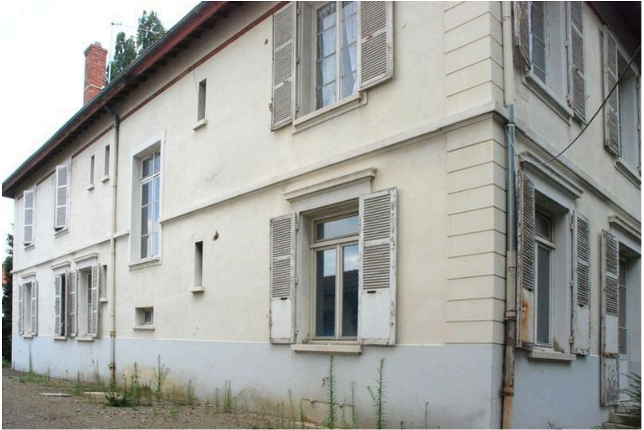
Façade postérieure (nord) et latérale (ouest). La fenêtre reliant les deux niveaux correspond à l'escalier principal
