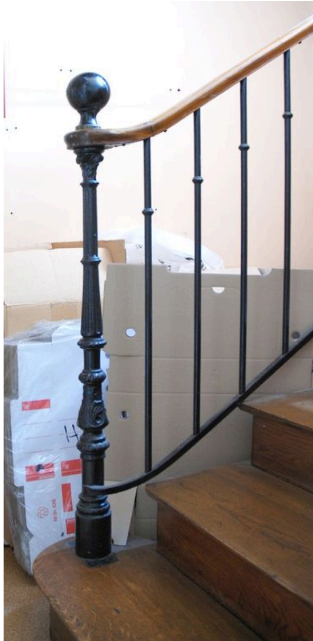
Escalier secondaire, détail de la rampe en métal et bois
