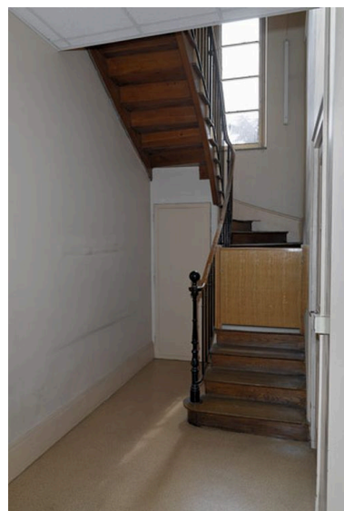
Escalier secondaire en bois, avec rampe en métal et barrière de sécurité postérieure Phot. Eric Dessert IVR82_20096903517NUCA
