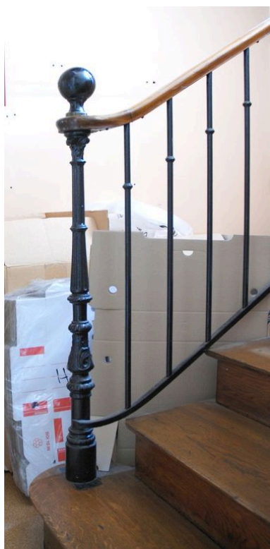
Escalier secondaire, détail de la rampe en métal et bois Phot. Ophélie Ferlier IVR82_20096904568NUCA
