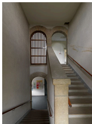
Bâtiment des services généraux, escalier sud, repos entre le premier et le deuxième étage Phot. Eric Dessert IVR82_20096903509NUCA
