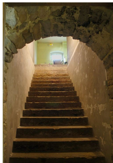
Sous-sol, escalier nord menant au rez-de-chaussée du bâtiment des services généraux Phot. Catherine Guégan IVR82_20096904378NUCA
