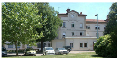
Ancienne façade principale du bâtiment des services généraux, aujourd'hui façade postérieure, avec l'ajout du bâtiment 308 (ouest) Phot. Ophélie Ferlier IVR82_20096904371NUCA
