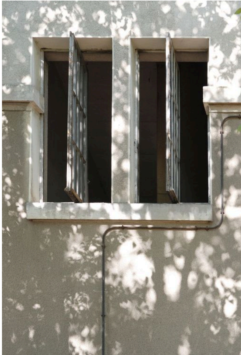
Détail du système d'ouvertures pivotant, façade est
