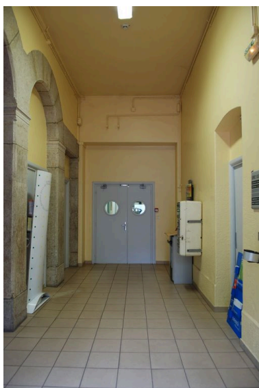
Couloir nord-sud, rez-de-chaussée du bâtiment des services généraux Phot. Catherine Guégan IVR82_20096904380NUCA
