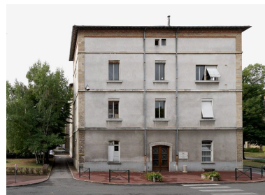
Façade latérale nord du bâtiment des services généraux Phot. Eric Dessert IVR82_20096903523NUCA
