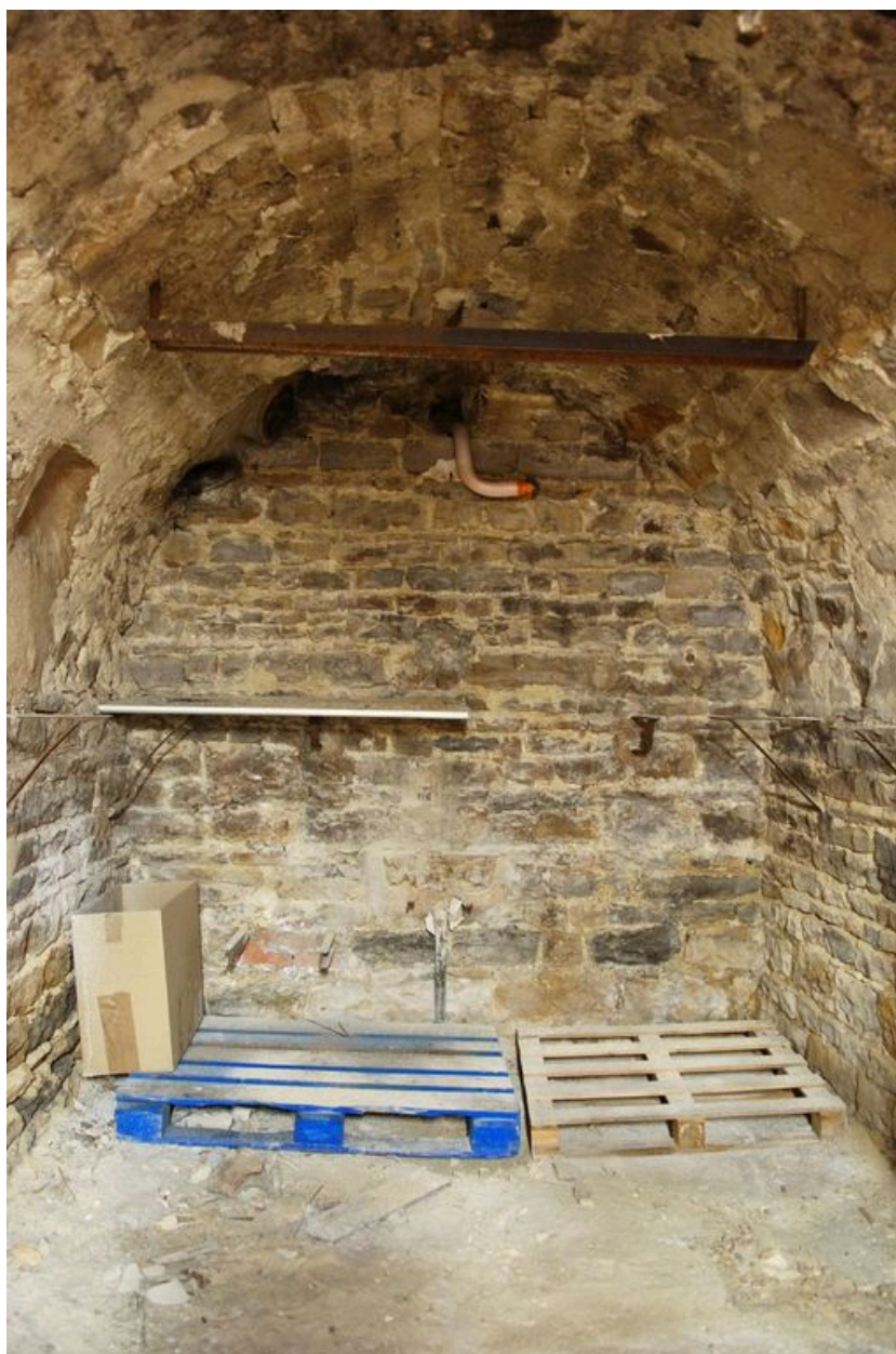
Sous-sol du bâtiment des services généraux, mur en moellons
