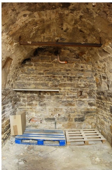
Sous-sol du bâtiment des services généraux, mur en moellons Phot. Catherine Guégan IVR82_20096904377NUCA
