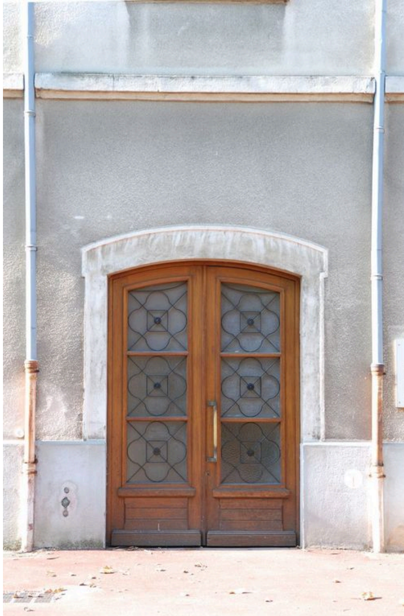
Détail de la façade latérale nord du bâtiment des services généraux : porte en chêne et verre cathédrale
