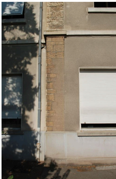
Détail du chaînage d'angle en moellons piqués, façade est Phot. Catherine Guégan IVR82_20096904366NUCA
