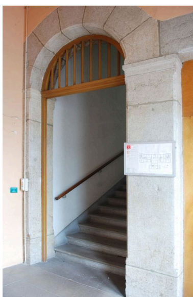
Bâtiment des services généraux, départ de l'escalier sud, encadrement en pierre et tympan de menuiserie Phot. Catherine Guégan IVR82_20096904383NUCA
