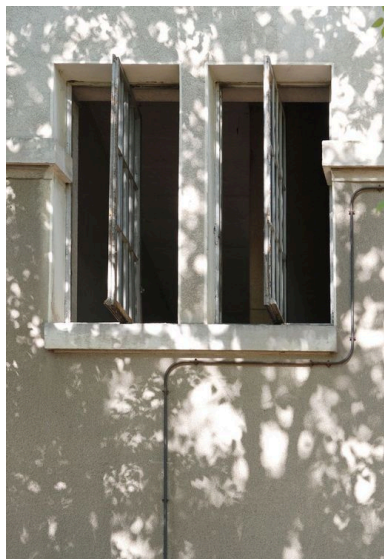
Détail du système d'ouvertures pivotant, façade est Phot. Catherine Guégan IVR82_20096904365NUCA
