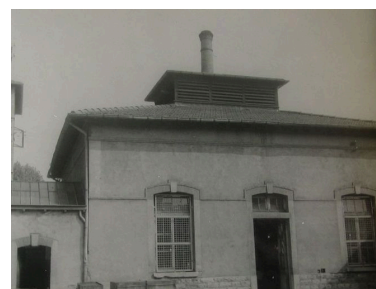
La cuisine, avant sa destruction en 1966 Repro. Ophélie Ferlier IVR82_20096904361NUC
