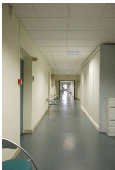
Bâtiment des services généraux, premier étage, enfilade du couloir nord-sud Phot. Catherine Guégan IVR82_20096904387NUCA
