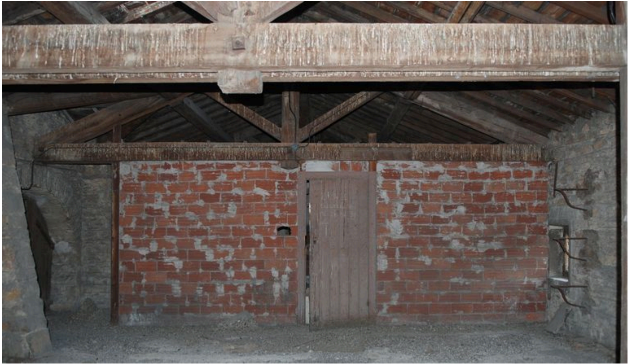
Bâtiment des services généraux, combles
