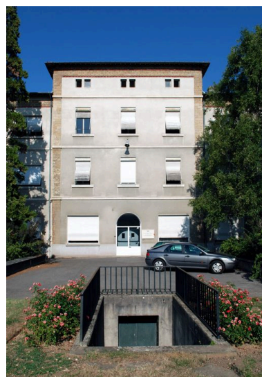
Façade principale du bâtiment des services généraux, détail de l'avant-corps central. Au premier plan, accès à la chaufferie située au sous-sol du bâtiment Phot. Ophélie Ferlier IVR82_20106905379NUCA
