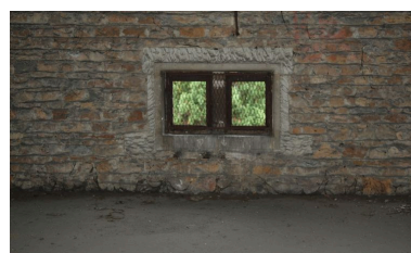
Bâtiment des services généraux, combles, détail des ouvertures Phot. Catherine Guégan
