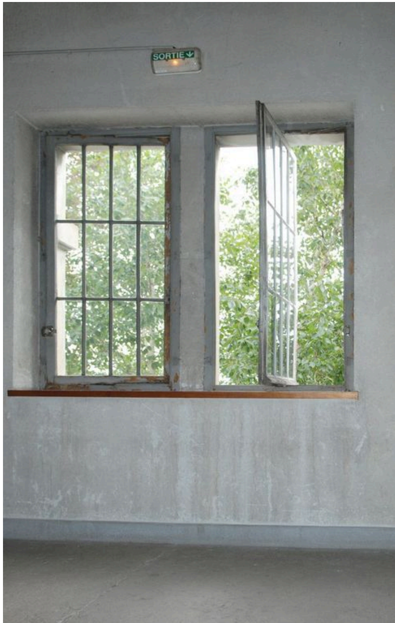
Bâtiment des services généraux, escalier sud, palier entre le premier et le deuxième étage, détail du système d'ouverture pivotant
