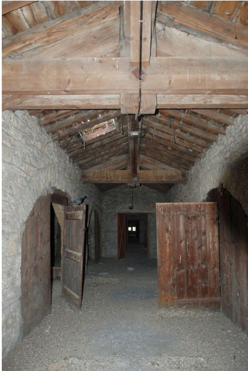
Bâtiment des services généraux, combles, murs en moellons
