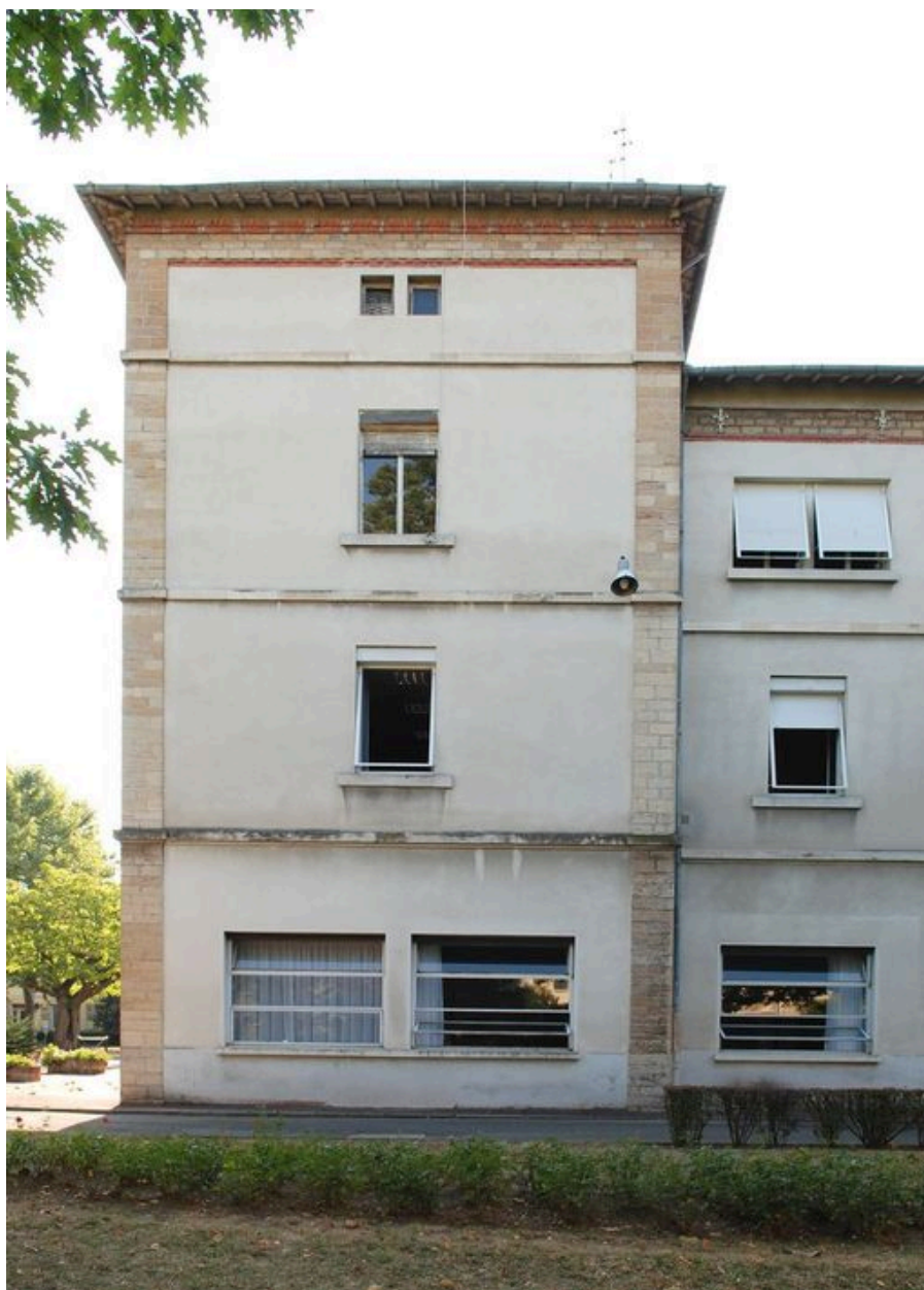
Façade ouest, détail de l'avant-corps latéral nord
