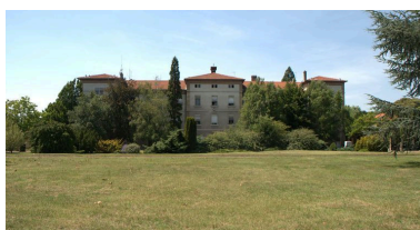
Vue de l'actuelle façade principale du bâtiment des services généraux, depuis l'est Phot. Ophélie Ferlier IVR82_20096904364NUCA
