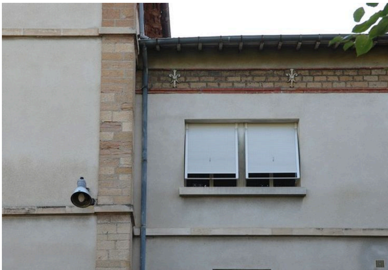
Façade ouest, détail du bandeau en briques, moellons et éléments métalliques sous la toiture
