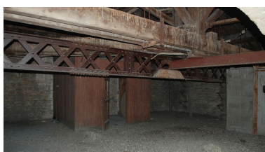
Bâtiment des services généraux, combles, pièce en bois renfermant le mécanisme de l'horloge Phot. Catherine Guégan
