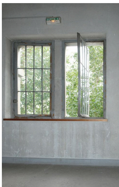
Bâtiment des services généraux, escalier sud, palier entre le premier et le deuxième étage, détail du système d'ouverture pivotant Phot. Catherine Guégan IVR82_20096904388NUCA
