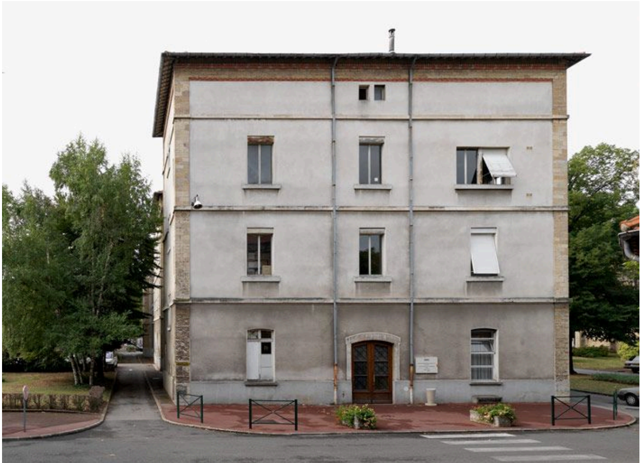
Façade latérale nord du bâtiment des services généraux
