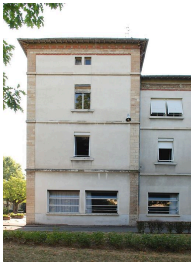
Façade ouest, détail de l'avant-corps latéral nord Phot. Catherine Guégan IVR82_20096904373NUCA
