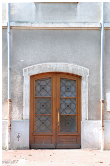
Détail de la façade latérale nord du bâtiment des services généraux : porte en chêne et verre cathédrale Phot. Catherine Guégan IVR82_20096904369NUCA
