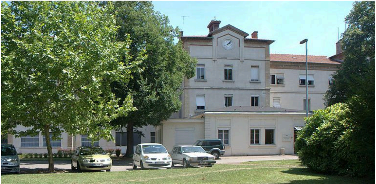
Ancienne façade principale du bâtiment des services généraux, aujourd'hui façade postérieure, avec l'ajout du bâtiment 308 (ouest)
