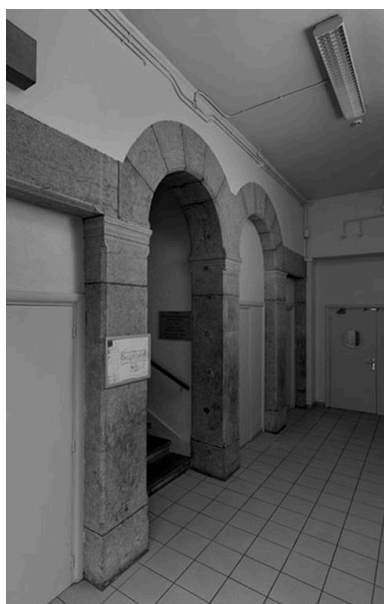
Encadrements en pierre de taille, départ de l'escalier nord du bâtiment des services généraux Phot. Eric Dessert IVR82_20096903508NUC
