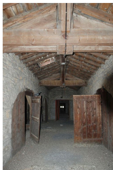
Bâtiment des services généraux, combles, murs en moellons Phot. Catherine Guégan IVR82_20096904390NUCA
