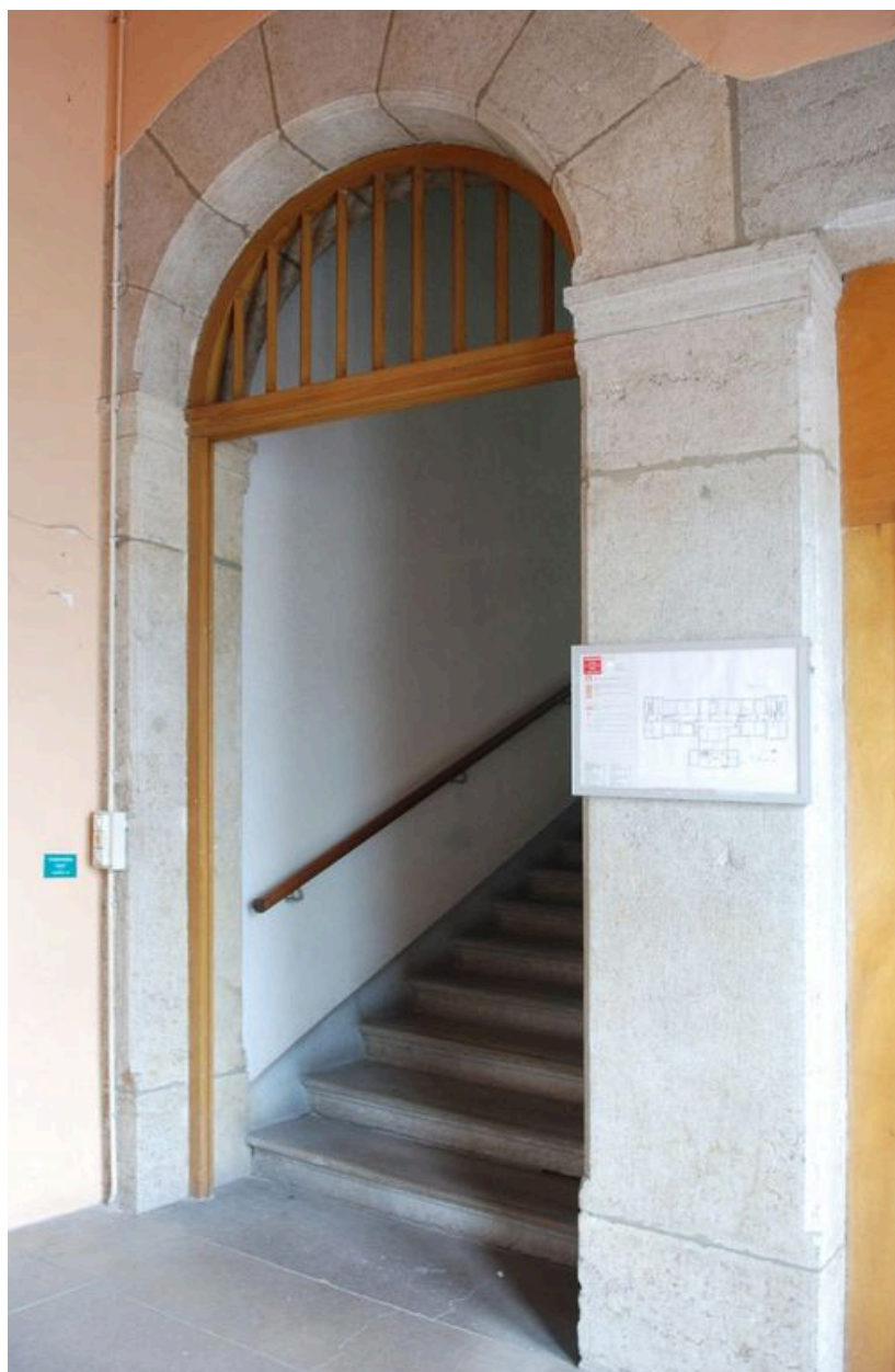
Bâtiment des services généraux, départ de l'escalier sud, encadrement en pierre et tympan de menuiserie
