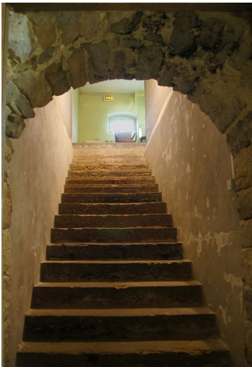
Sous-sol, escalier nord menant au rez-de-chaussée du bâtiment des services généraux
