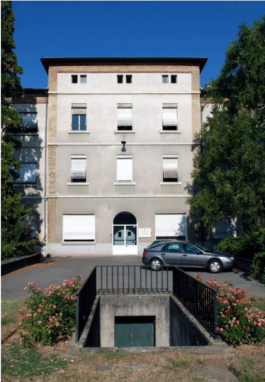
Façade principale du bâtiment des services généraux, détail de l'avant-corps central. Au premier plan, accès à la chaufferie située au sous-sol du bâtiment
