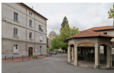
Vue d'ensemble de la façade nord et d'un édicule, autrefois reliés par une galerie Phot. Eric Dessert IVR82_20096903524NUCA
