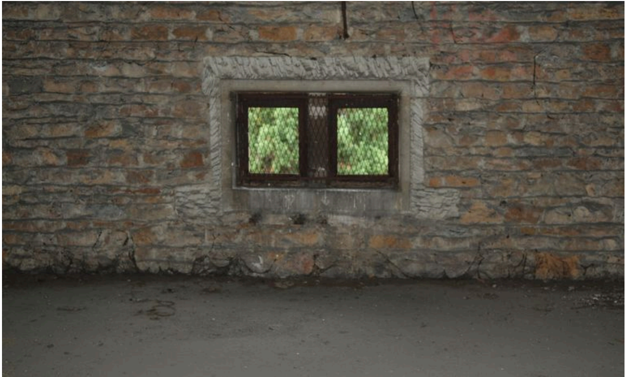
Bâtiment des services généraux, combles, détail des ouvertures
