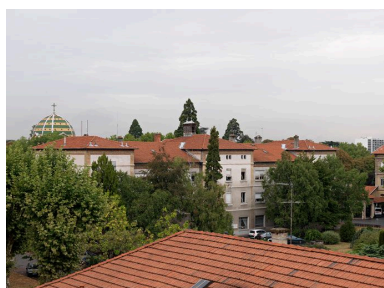
Vue du bâtiment des services généraux depuis le sud-est Phot. Eric Dessert IVR82_20096903511NUCA
