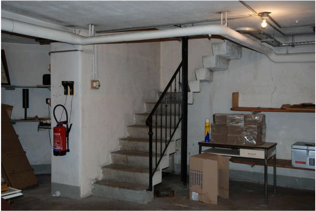
Bâtiment 308, escalier du sous-sol
