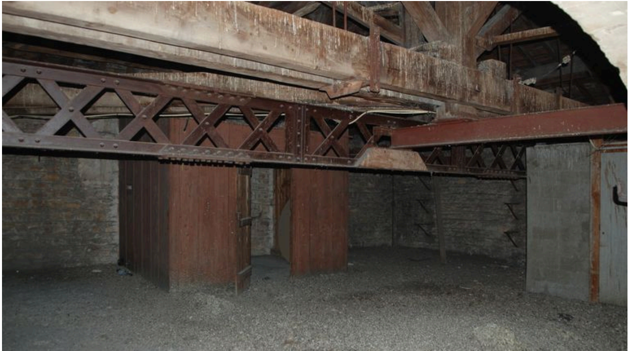
Bâtiment des services généraux, combles, pièce en bois renfermant le mécanisme de l'horloge
