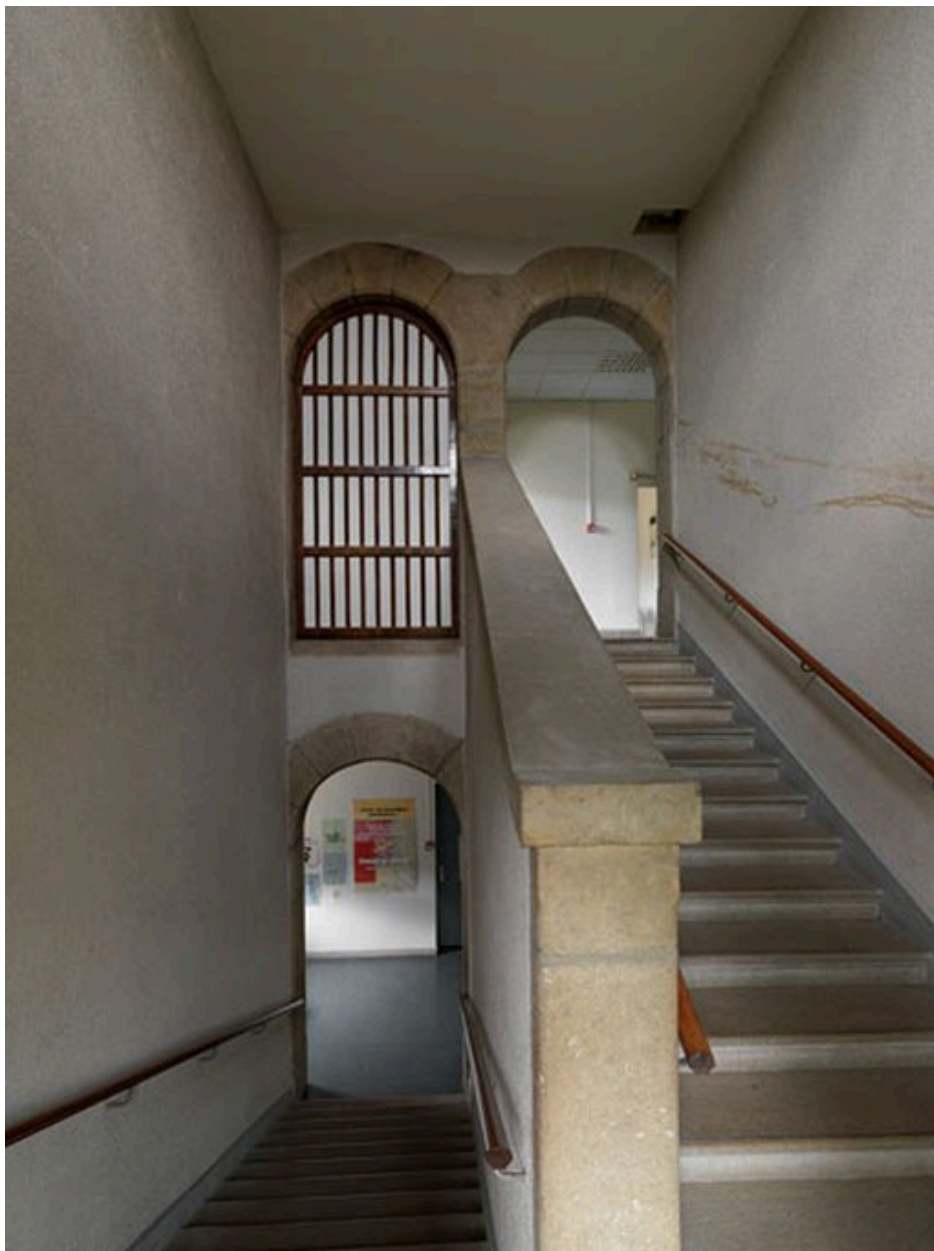
Bâtiment des services généraux, escalier sud, repos entre le premier et le deuxième étage
