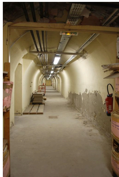
Sous-sol du bâtiment des services généraux, couloir voûté nord-sud Phot. Catherine Guégan IVR82_20096904375NUCA
