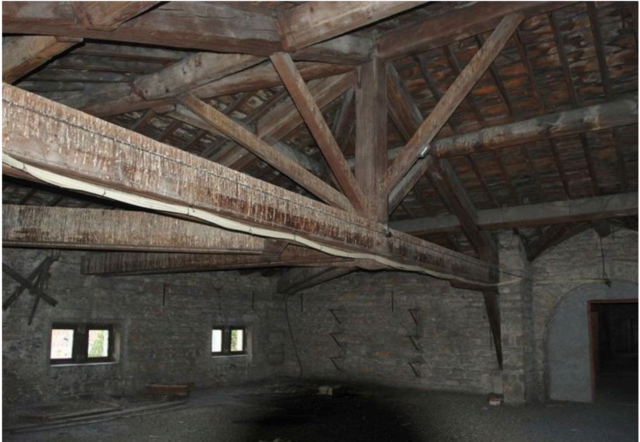
Bâtiment des services généraux, combles, détail de la charpente
