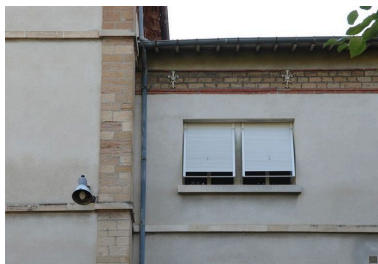
Façade ouest, détail du bandeau en briques, moellons et éléments métalliques sous la toiture Phot. Catherine Guégan IVR82_20096904374NUCA
