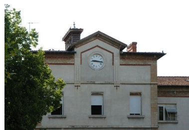
Détail de la façade ouest du bâtiment des services généraux : l'horloge Phot. Catherine Guégan IVR82_20096904372NUCA
