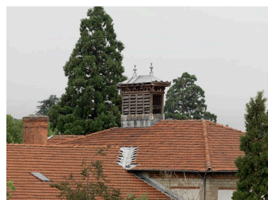
Vue depuis le sud-est du campanile en bois situé au sommet du toit de l'avant-corps central du bâtiment des services généraux Phot. Eric Dessert IVR82_20096903514NUCA
