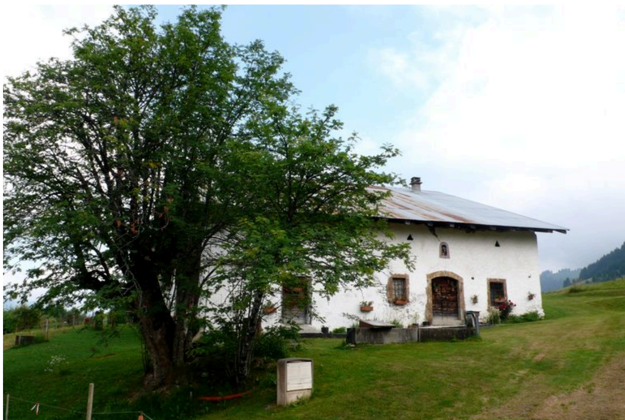
Ferme, 1849 route de la Cote 2000. Elévation principale
