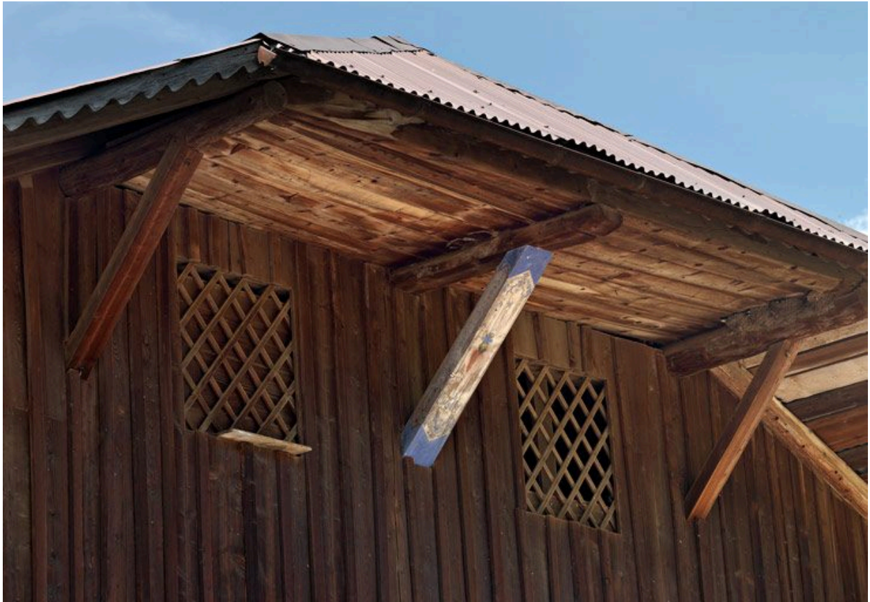
Hameau du Pleney. Détail de l'avant-toit et des baies du fenil
