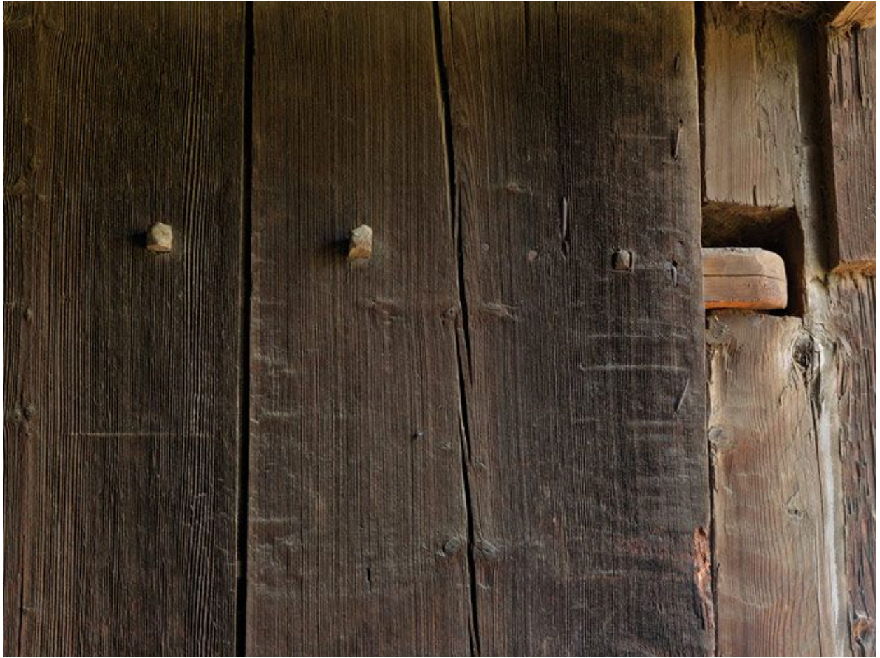
Hameau du Pleney. Détail de la porte du fenil
