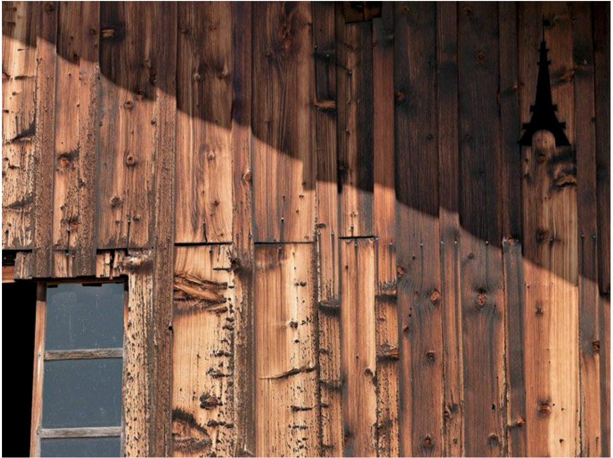
Hameau du Plennelet. Ferme ancienne. Détail de la façade de l'atelier
