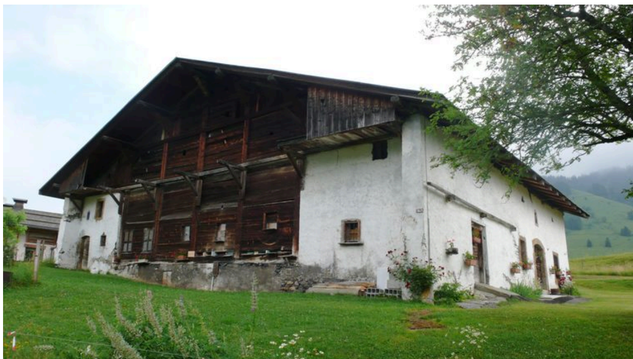
Ferme, 1849 route de la Cote 2000. Vue depuis le sud
