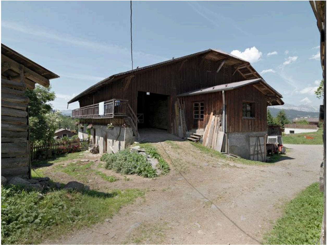
Hameau du Pleney. Vue d'ensemble d'une ferme. Entrée du fenil
