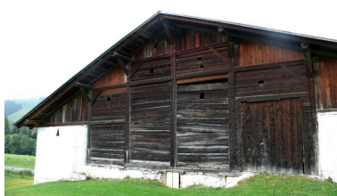
Ferme, 1849 route de la Cote 2000. Entrée du fenil Phot. Jean-François Lyon-Caen IVR82_20127401901NUCA
