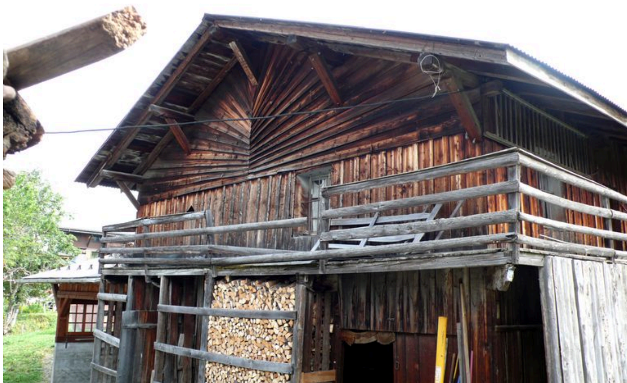
Hameau du Pleney. Remise à bois
