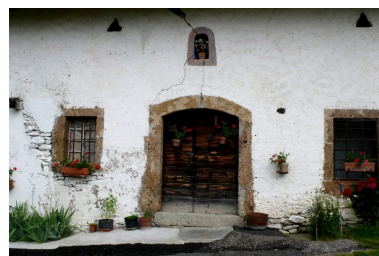
Ferme, 1849 route de la Cote 2000. Entrée Phot. Jean-François Lyon-Caen IVR82_20127401899NUCA
