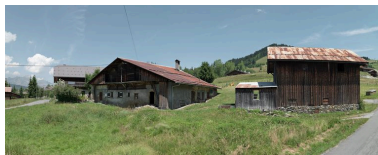
Hameau du Plenellet. Vue d'ensemble d'une ferme ancienne et de son atelier Phot. Eric Dessert IVR82_20117400177NUCA
