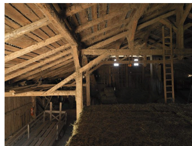
Hameau du Pleney. Intérieur du fenil Phot. Eric Dessert IVR82_20107401701NUCA
