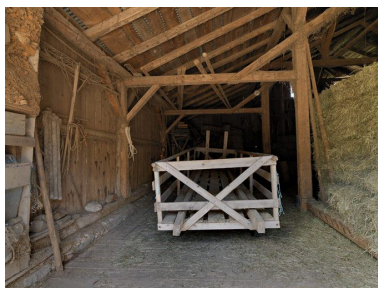
Hameau du Pleney. Intérieur du fenil. La mangeoire Phot. Eric Dessert IVR82_20107401698NUCA
