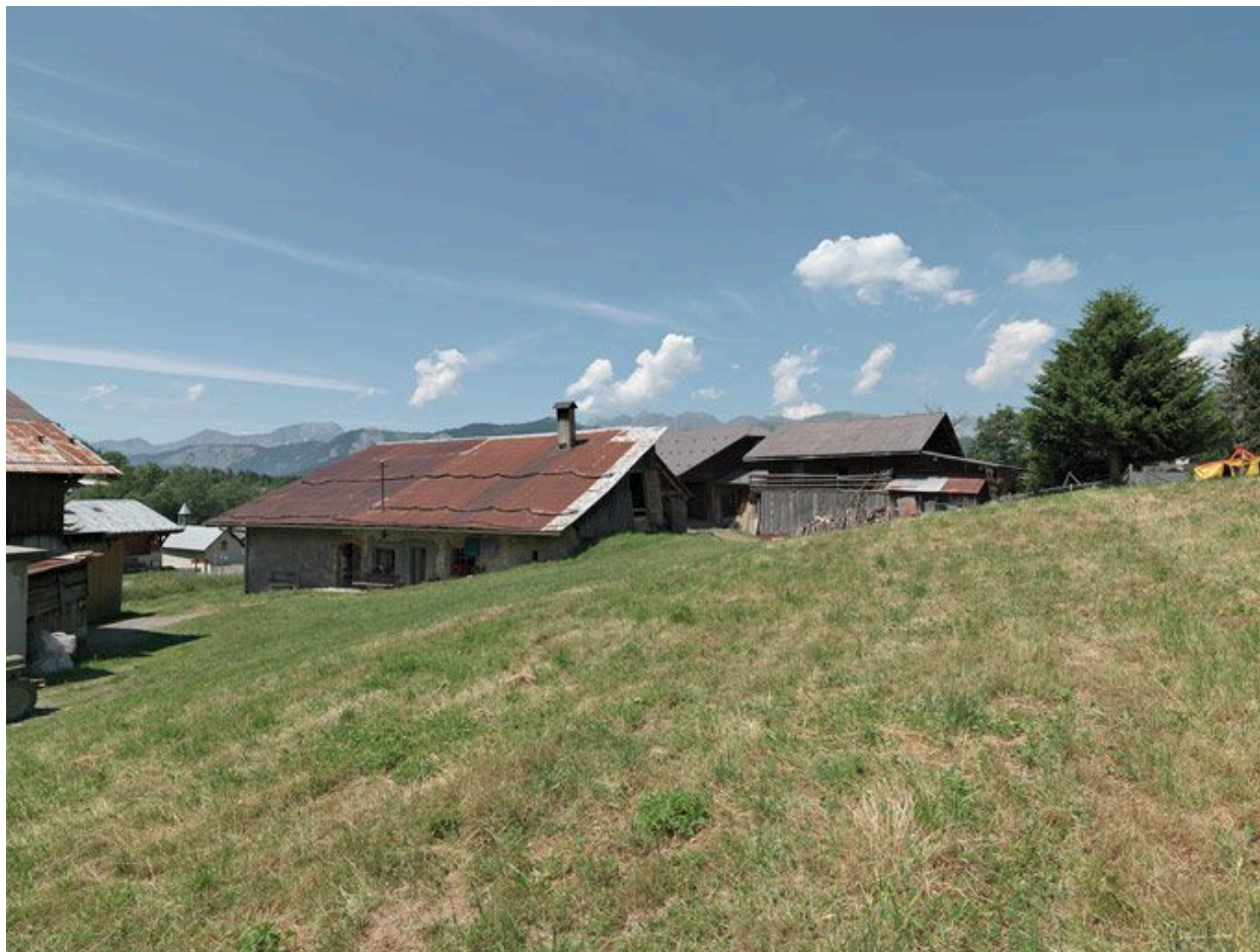
Vue d'ensemble du hameau de Plenellet
