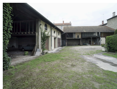
Vue générale des dépendances en direction du sud. Phot. Eric Dessert IVR82_20084200669NUCA
