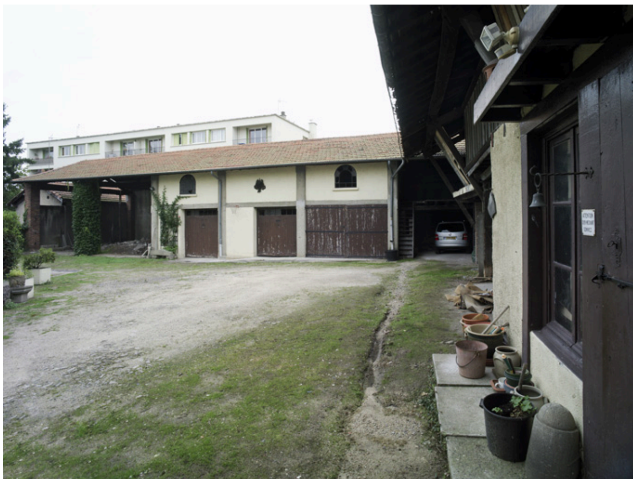
Vue d'ensemble des dépendances bordant les deux côtés du jardin ; vue en direction de l'est.
