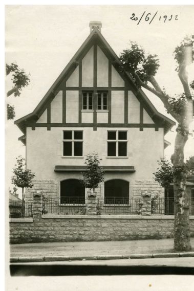
Photographie de l'élévation sur rue en 1932, par Dubost (?). Phot. Eric (reproduction) Dessert, Autr. Julien (entrepreneur) Dubost IVR82_20134200627NUCB
