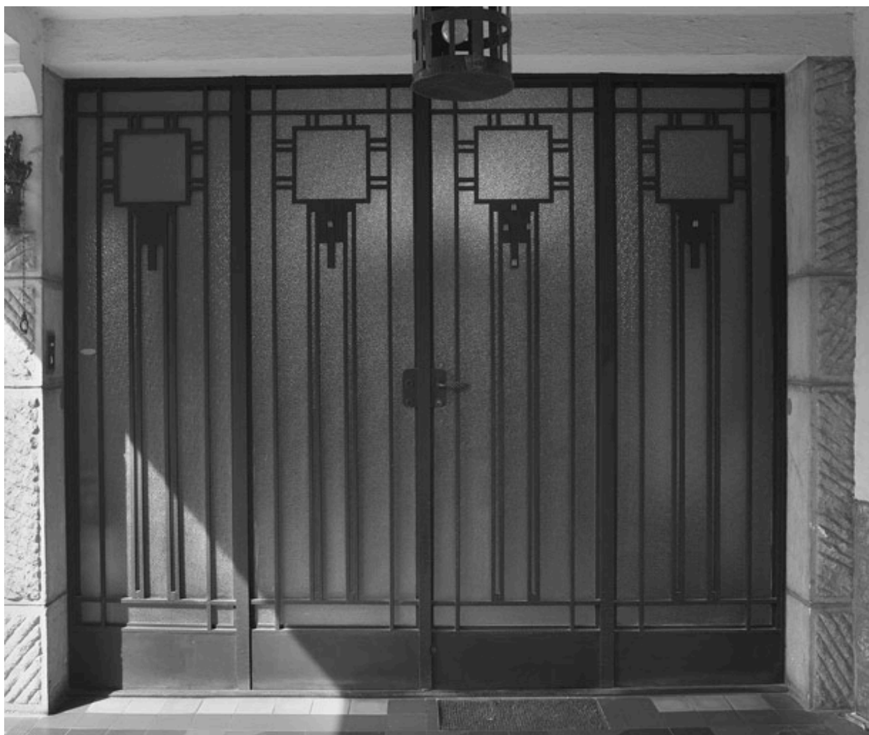
Vue de la porte en ferronnerie, réalisée en 1932.
