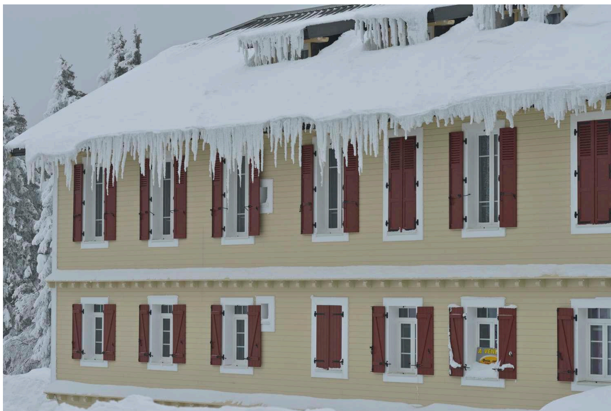
Façade arrière, détail sous la neige.
