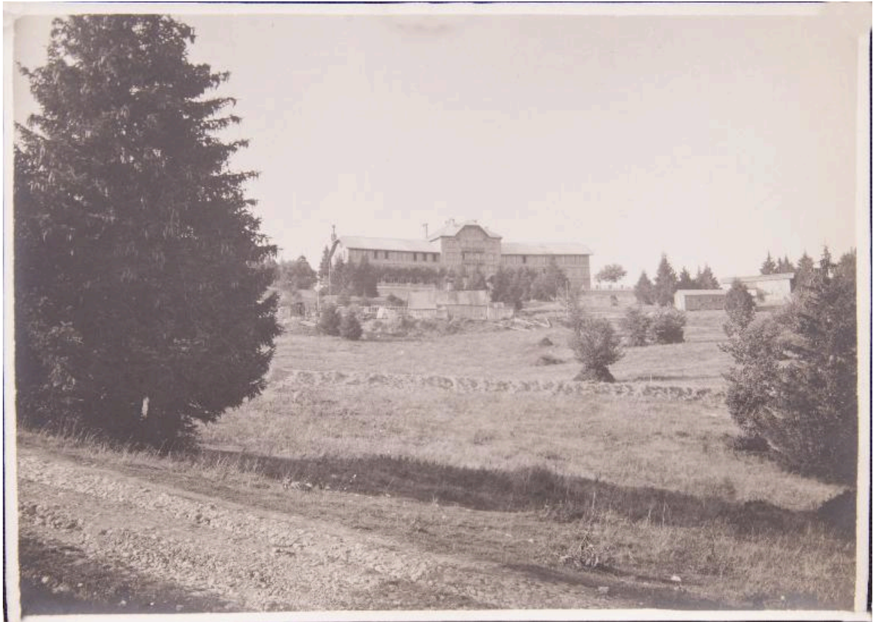
L'hôtel après la campagne de travaux de 1923-1925
