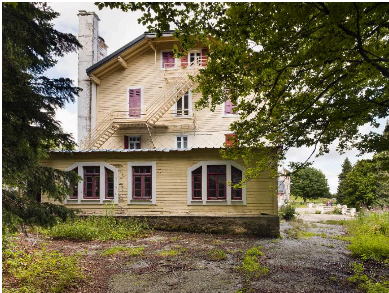
Pignon sud : construction en rez-de-chaussée pour agrandir la salle à manger
