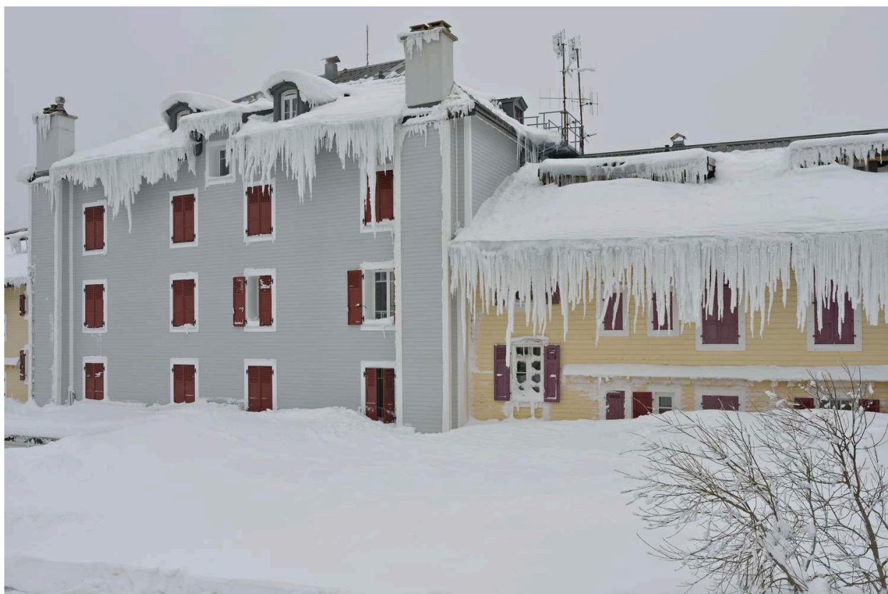
Façade arrière, détail sous la neige.
