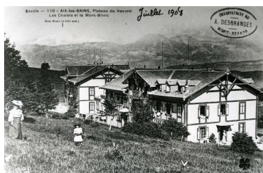
Vue d'ensemble depuis l'arrière, 1900 Repro. Denys Harreau IVR84_20167305704NUCB
