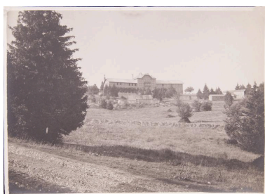
L'hôtel après la campagne de travaux de 1923-1925 Repro. Denys Harreau IVR84_20167305699NUCB
