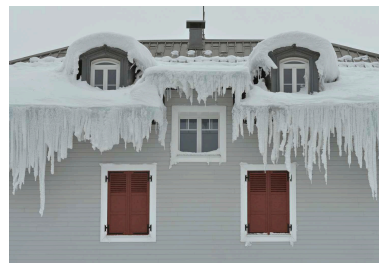
Façade arrière, détail du corps central, sous la neige. Phot. Thierry Leroy IVR82_20157304428NUCA
