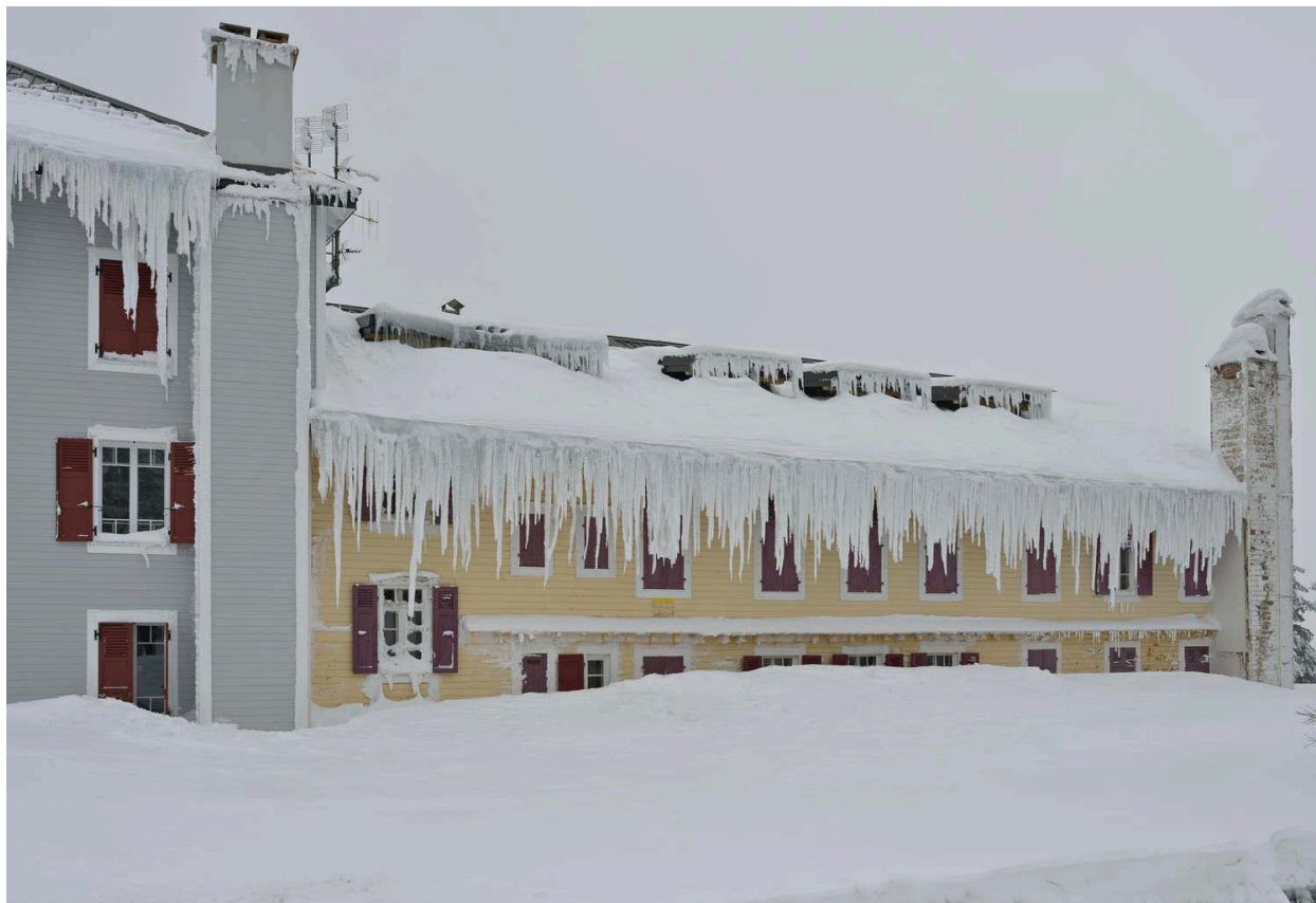
Façade arrière, détail sous la neige.
