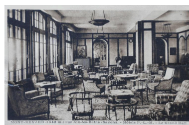
Le grand hall, vers 1930 Repro. Denys Harreau IVR84_20167305713NUCB
