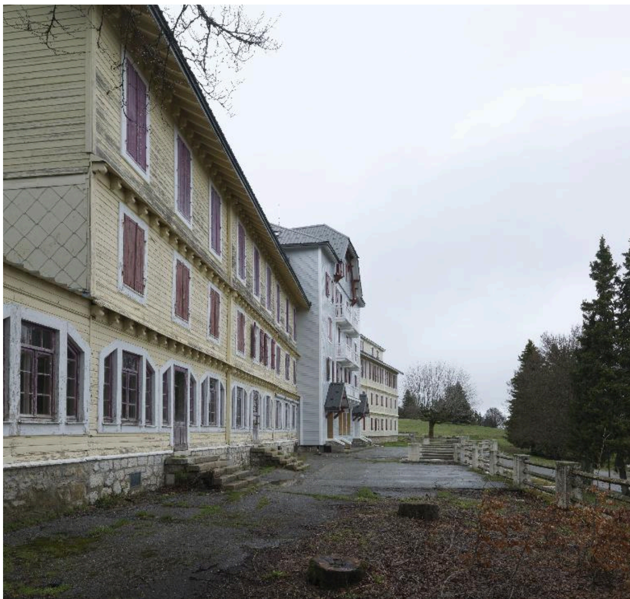
Vue de la terrasse et de la façade principale depuis le sud
