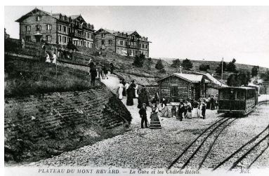
Les 2 chalets-hôtels et la gare, avant 1897 Repro. Denys Harreau IVR84_20167305703NUCB
