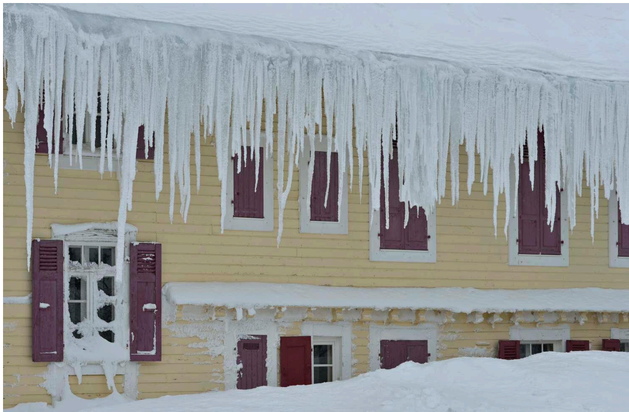
Façade arrière, détail sous la neige.
