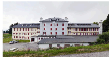
Façade postérieure et bâtiments annexes Phot. Eric Dessert IVR82_20147304534NUCAQ
