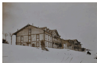
Vue depuis le sud en hiver, après 1897 Repro. Denys Harreau IVR84_20167305715NUCB
