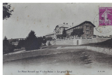
Vue depuis le nord, vers 1925 Repro. Denys Harreau IVR84_20167305707NUCB
