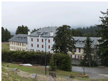
Vue d'ensemble : façade postérieure Phot. Eric Dessert IVR82_20147302050NUCA
