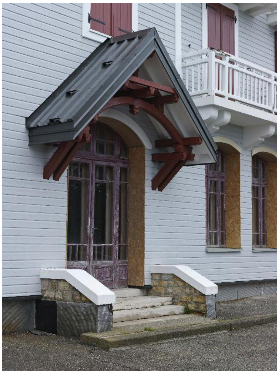
Façade principale : entrée sur le corps central
