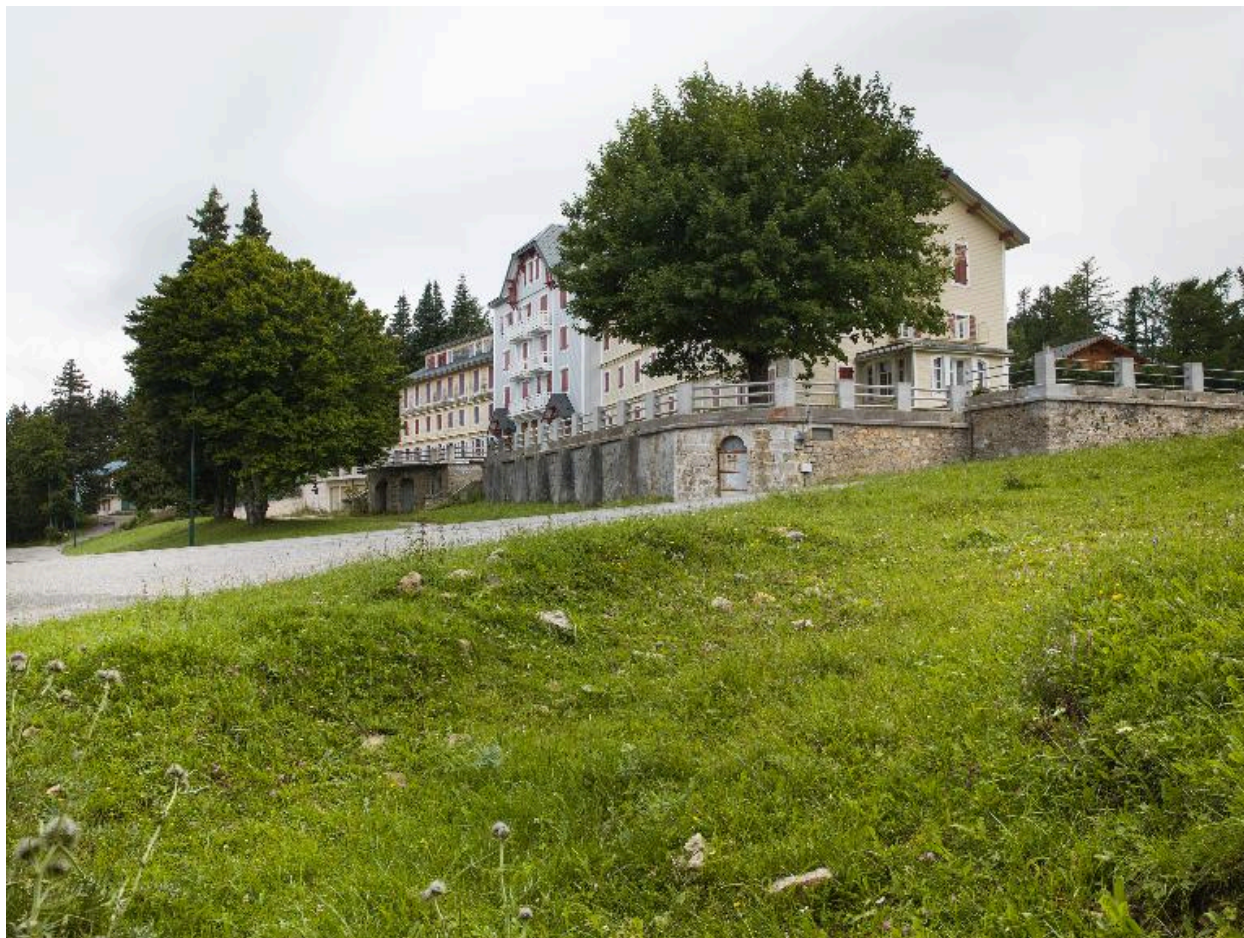
Vue d'ensemble : façade principale et pignon nord
