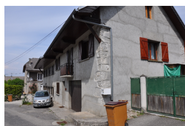
Vue sud de l'ancien moulin Phot. Yannick Milleret IVR82_20117302398NUCA
