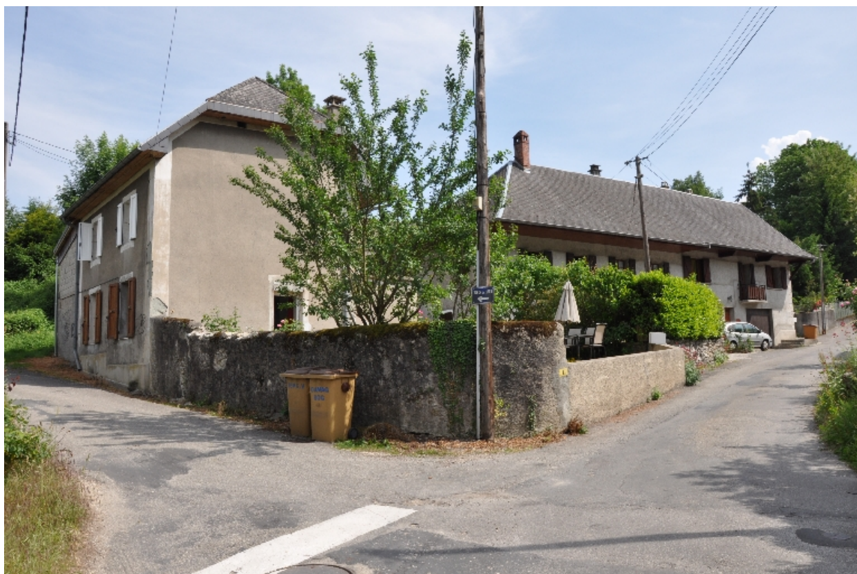
Vue générale des anciens moulins, nord
